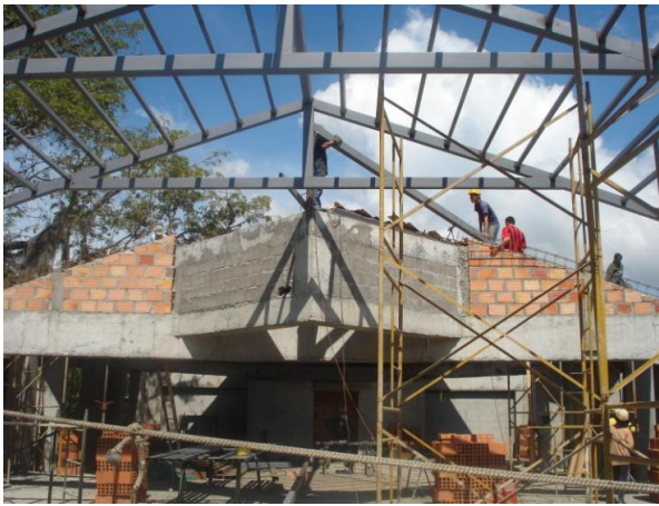
Figura 3. Montaje de cubiertas
