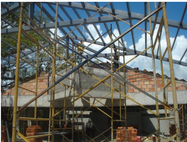
Figura 4. Montaje de cubiertas
