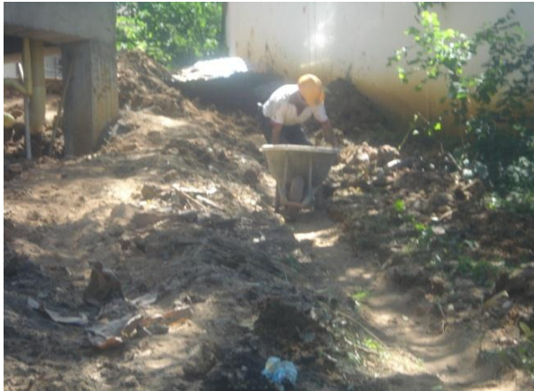
Figura 7. Transporte de material para relleno de instalaciones hidráulicas y sanitarias
