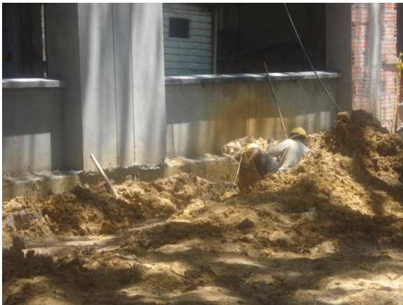
Figura 6. Excavación instalaciones hidráulicas y sanitarias
