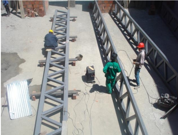
Figura 5. Estructura metálica para cubierta
