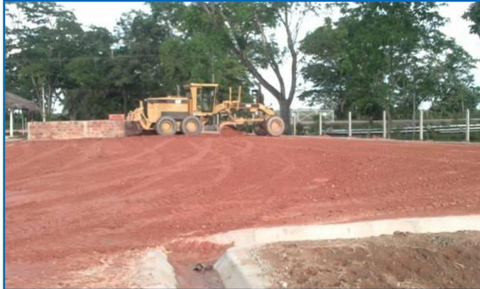
En la foto No. 23 se indica que se realizó la conformación y céreo de la superficie para llevar a cabo la operación siguiente de compactación.
