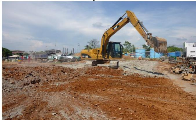
Hacia parte fundamental de las actividades objetos de la práctica que el practicante controlara fiel y estrictamente las humedades de los materiales en su proceso de estabilización, calcular las proporciones del agente estabilizante y el cemento y verificar que la homogenización del material estabilizado fuese del 100%. De igual forma también controlar la llegada y salida de materiales con cemento, combustibles, recebo tipo II, subbase del patio de mezclado.
