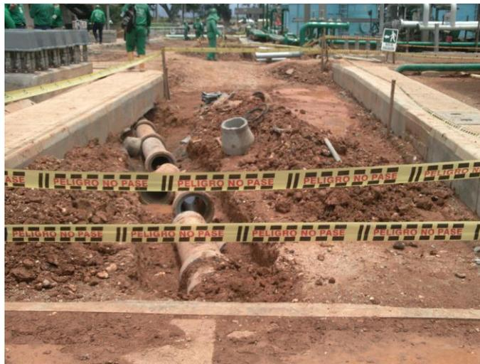
El practicante supervisó la colocación de un sistema de alcantarillas para realizar el drenaje del box.
