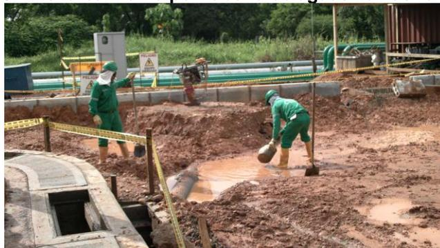
En la foto 30 se muestra, como por resultado del daño de una tubería, se produce encharcamiento de la zona de trabajo. Es así como el practicante ordena la evacuación de dichas aguas.
