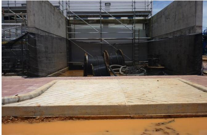
El empozamiento presentado en las cajas construidas para los transformadores de la planta esta resumiendo agua por debajo de la placa construida a causa de la vibración de la capa estabilizada.
