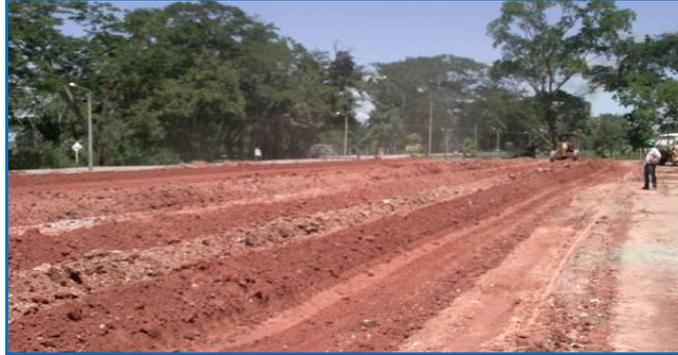
**Foto 13. Escarificación de área a intervenir con el espesor definido  $e = 0.15\text{m}$**
