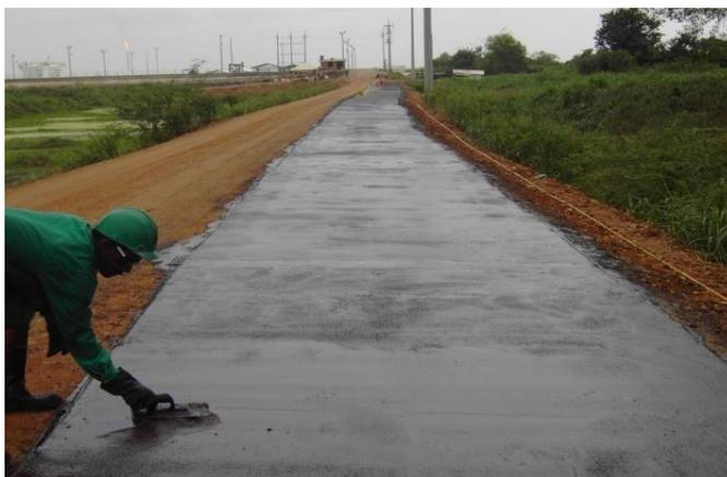
**Foto 10. Aplicación de la segunda capa de Slurry Seal  $e=0.01m$**
