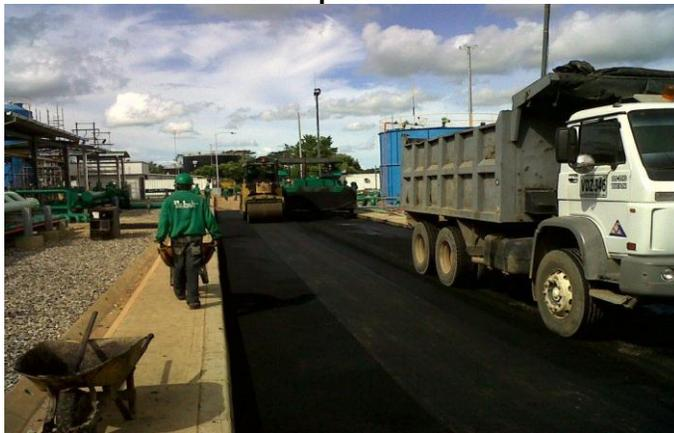
Con la finisher se trabajan anchos de 3 m (es decir, media calzada) y la MDC – 2 se extendió en dos capas teniendo en cuenta el factor de compactación de la mezcla para garantizar los 15 cm de diseño.
