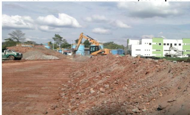
La humedad de compactación debe estar entre el -2% y el +2% de la óptima, obtenida del ensayo del Proctor Modificado. Así mismo, deberá asegurarse el contenido uniforme de humedad en toda la capa.
