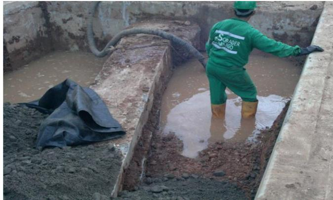
Como se ve en la foto 45, se presentan problemas de filtración ya que los manjoles o pozos de los sistemas de alcantarillado de aguas aceitosas y aguas lluvias no estaban impermeabilizados correctamente, caso que se presento en la mayoría de los pozos del proyecto.
