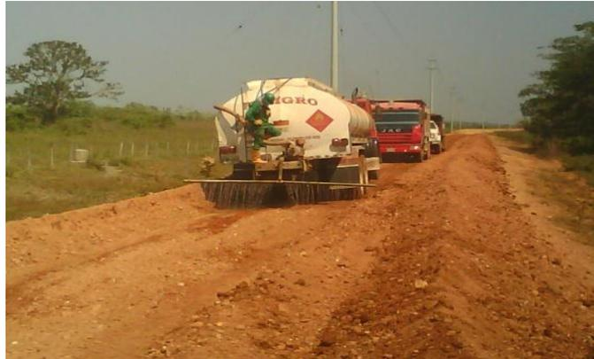
Como se muestra en la Foto No. 4, fue necesario como parte del procedimiento, realizar un acordonamiento para que el material impregnado con la enzima se homogenizara, para lo cual, por supuesto, el practicante estuvo atento para que los operarios realizaran la operación de forma adecuada y el resultado de homogenización material-enzima-agua fuera el idóneo.
