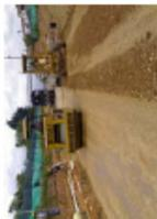
4. *Sellado de la superficie*. Para el acabado final y protección al desgaste de la superficie se recomienda, aplicar una capa de asfalto de bajo espesor o una capa de Slurry Seal que
