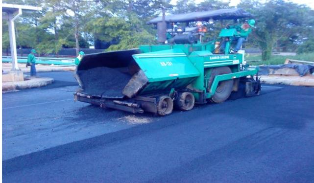
Una vez llegó la volqueta cargada con el material al sitio de la obra se le tomaron la temperatura de llegada de la MDC – 2, y el practicante controló que en el momento de la aplicación esta contenga la temperatura adecuada para su compactación establecida en el diseño Marshall presentado en el anexo No 4. Se debe tener pleno cuidado con que la compactación de la MDC-2 no se haga a temperaturas inferiores a 100°C.
