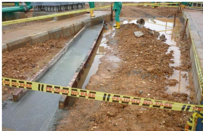
**Foto 44. Excavaciones para construcción de filtro francés**
