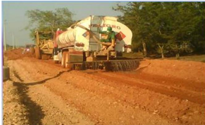
La moto niveladora que opera después del carrotanque, recoge y acordona a un lado de la vía el material impregnado con la enzima. En esta parte del proceso el practicante debía velar por la disposición oportuna de la maquinaria para ejecutar la tarea de recogida y acordonamiento del material impregnado por la enzima.
