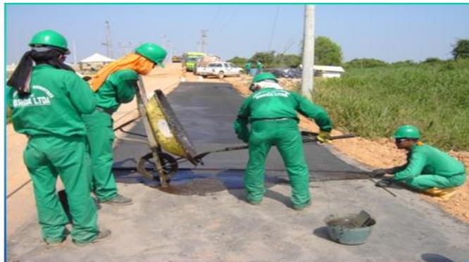
**Foto 9. Acabado final con llana metálica y boquillera**
