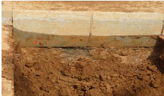
Debido a lo mostrado en la foto 41, donde se evidencian fallos estructurales por infiltración de aguas, el practicante ordena el desagüe de la zona para evitar así mas deterioro por aguas laterales y de igual manera el retiro del material saturado.
