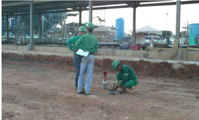
Teniendo en cuenta las indicaciones técnicas del practicante, el material producto de la excavación es transportado al patio del pozo Yarigui 506 donde se le bajó a la humedad necesaria para poder adicionarle el agente estabilizante con el agua necesaria para llevarla a la humedad óptima del proctor modificado. Ahí en la foto 31 se ve al practicante coordinando la toma de densidades de la subrasante.
