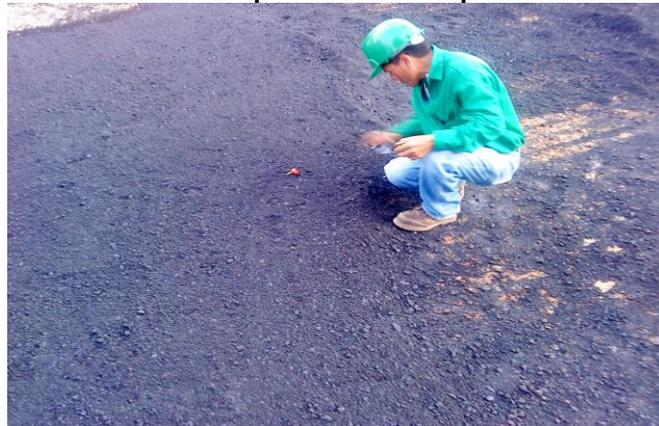
En la Foto 70 se puede observar la toma temperatura, y la apta (140,8°C) para la compactación donde primero se le pasa el vibro tándem y seguidamente el compactador neumático o enllantado para dar el acabado final de la superficie.
