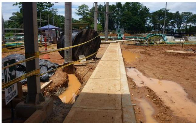
**Foto 49. Tubería superficial sin recubrimiento**
