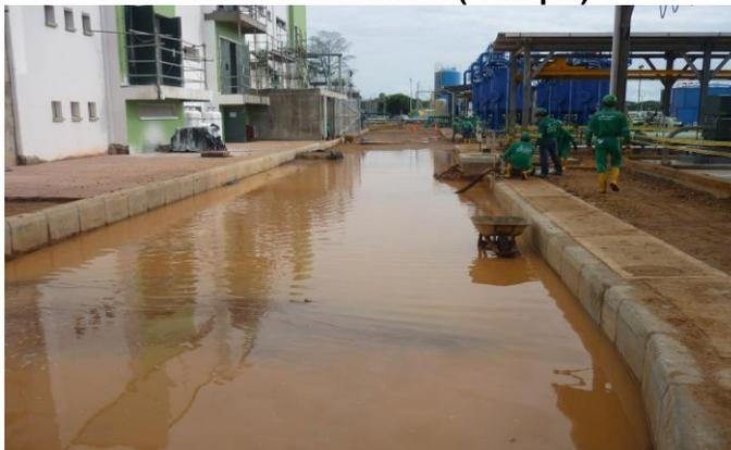
La problemática se centra en que el empozamiento de agua de manera continua, debido a las permanentes lluvias, e imposibilidad de drenajes, que no permiten que la estructura seque suficientemente, está causando una migración de la humedad hacia la parte inferior de la estructura causando saturación y deterioro de la misma. Los problemas en mención se hicieron evidentes mediante la presencia de fallos de estructuras que ya se encontraban debidamente conformadas.
