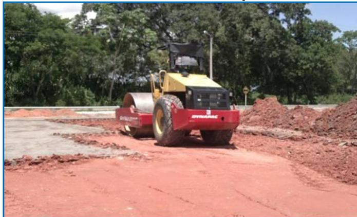
En la foto 24 se muestra como con el vibrocompactador se lleva a cabo la labor de compactación, la cual fue supervisada por el practicante con el fin de seguir a la operación de terminado de la superficie.
