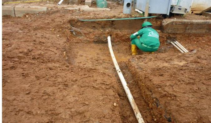
Debido a los elementos en concreto, ya construidos tales como box coulvert, y sardineles específicamente, están causando confinamiento de aguas lluvias, por la inexistencia de descoles provisionales, esto sumado a las continuas lluvias, aunque se están realizando obras de control (achiques), no permiten un secado suficiente de las estructura antes de ser sometidas nuevamente al empozamiento. Ver Foto 52 y 53.
