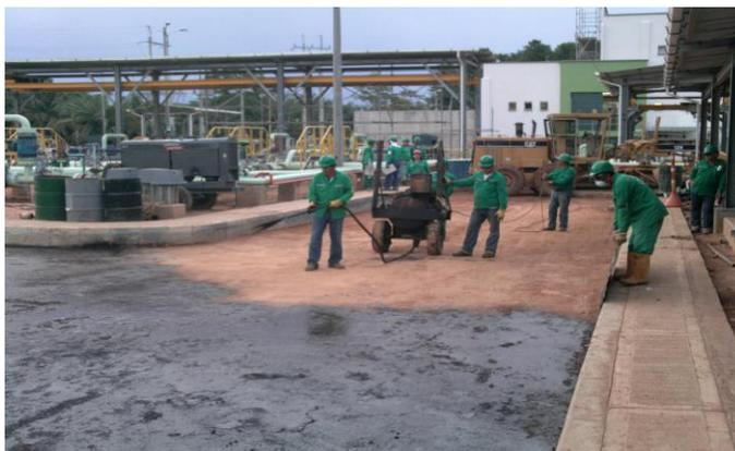
El ligante bituminoso que se utilizó para el sello imprimante de la capa estabilizada fue una emulsión asfáltica de rotura lenta tipo CRL-0.
