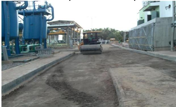
Se manejó básicamente en los puntos donde persistían los fallos por infiltraciones laterales de agua rellenos con material de cantera (subbase) de tal manera que su composición aluvial no permitiera ninguna afectación por humedad constante.
