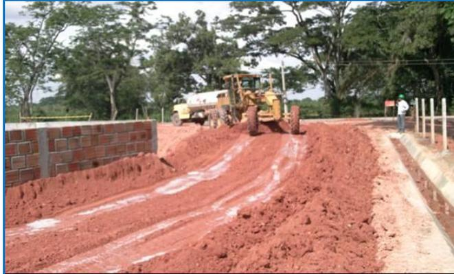
En la foto 21 se muestra como con la ayuda de maquinaria se hace la homogenización de la enzima-agua-material con el fin de dejar listo el terreno para el céreo. Estas operaciones fueron coordinadas por el practicante velando porque la dosificación enzima-agua fuera la indicada. Y coordinar la intervención de la topografía tanto para la escarificación como para el céreo.
