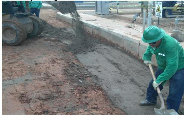
La capa de 0,30m de material granular estabilizado se compactó en una sola capa, para esto el practicante solicitó un vibrocompactador con la capacidad necesaria que garantice la compactación de dicho espesor y las densidades de la capa trabajada.
