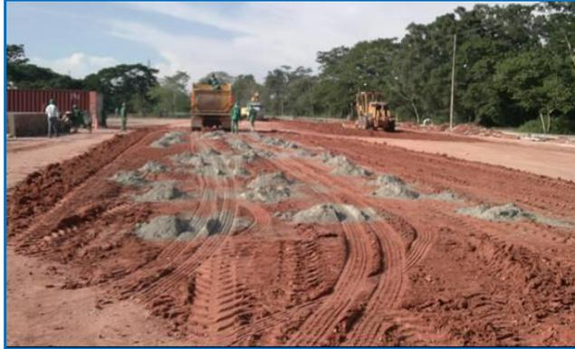
Se muestra en la Foto No. 16 que con apoyo de la maquinaria, se distribuye el cemento en la zona de trabajo, con el fin de proceder a la homogenización del recebo.
