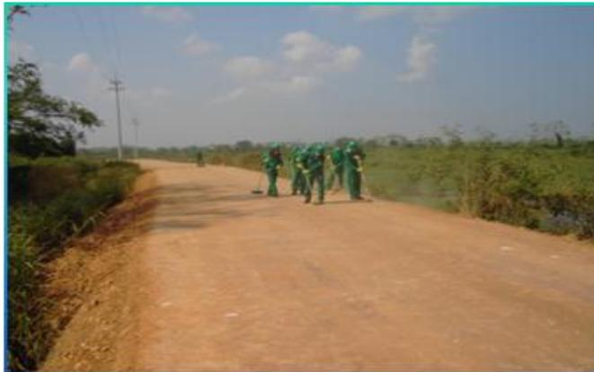
Bajo el seguimiento del practicante, la aplicación de la emulsión se realizó manualmente con la ayuda de un balde con pequeños orificios en el inferior para dejar salir la emulsión lanzada como se muestra en la Foto 7; seguidamente era barrida con escobas de cerdas livianas. Esto se hizo por razones de economía, ya que permitía ahorro en horas-máquina. y transporte de la misma
