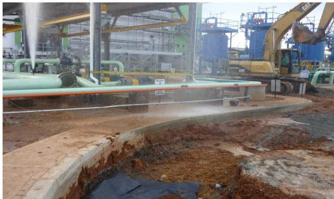
Se evidencia en la foto 34, la humedad producida por el agua en la zona de trabajo por pruebas hidrostáticas cuando se retiran los fallos.
