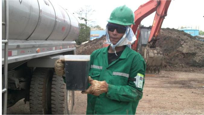
Tal como se muestra en la foto No 60 la cantidad de enzima se dosificaba de acuerdo a la cantidad de material, en jarras que tuviesen medidas, este debe luego homogeneizarse con el agua mediante la motobomba re circulando el agua o en un forcejeo del carro acelerando y frenando bruscamente.
