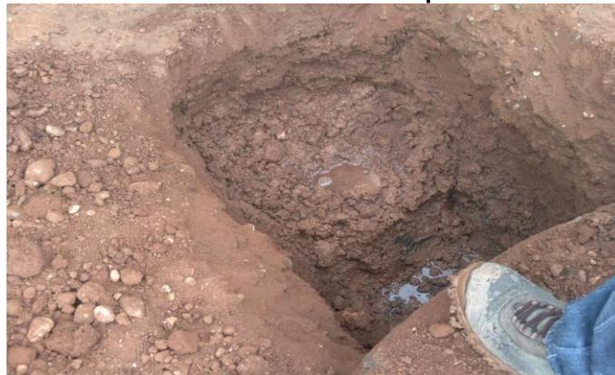
En la mayoría de los pozos y/o manjoles se presentó filtración de agua, ya sea por el mal procedimiento de impermeabilización o la no utilización de productos impermeabilizantes, generando grandes pérdidas y reproceso en la ejecución de las actividades objetos del proyecto.
