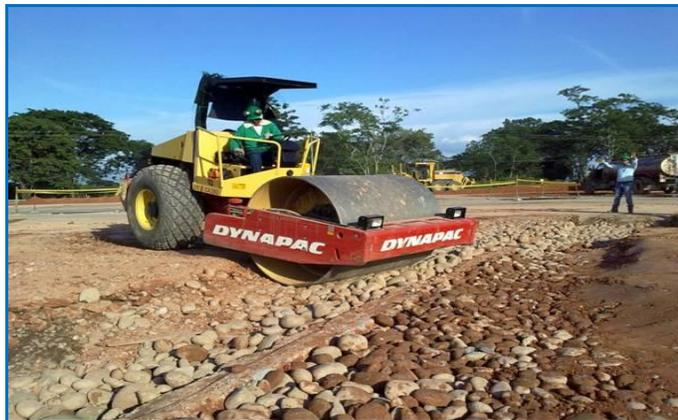
En la Foto No. 15, bajo la guía del practicante, se procede a retirar el fallo con material crudo de río.
