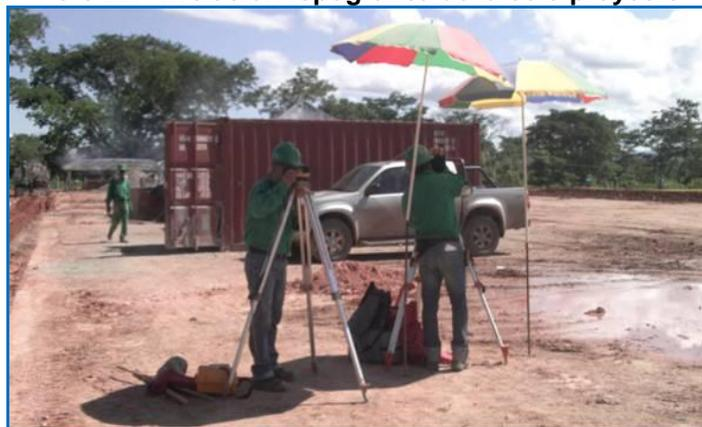
Como se muestra en la foto 22, los topógrafos realizan la labor de cota del terreno para así permitir la posterior compactación y céreo de la superficie del proyecto.
