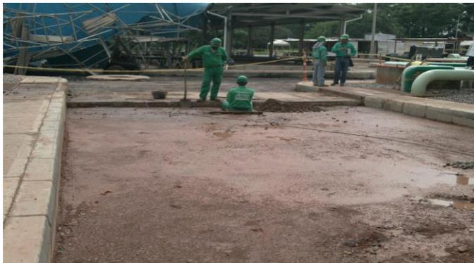
Luego de insistir en la posibilidad de perforar las estructuras ya construidas para permitir el drenado de las vías, las estructuras estabilizadas luego de las fuertes lluvias inmediatamente drenaban concediéndonos que el sol hiciera su trabajo de darnos la humedad para la toma de las densidades.
