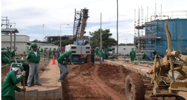
**Foto 61. Manejo de aguas laterales con material aluvial, sub-base**
