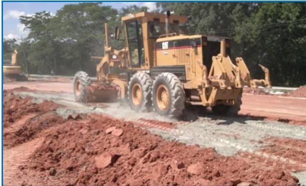
Seguidamente, bajo la supervisión del practicante, se mezcló el cemento con el material y fue acordonado, para disponer en capas de espesores aproximados de 5 cm, donde se le aplicaron la enzima previamente preparada en el carrotanque como muestra las fotos siguientes:
