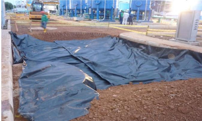
**Foto 40. Excavaciones para instalación de mallas a tierra del sistema eléctrico de operaciones de la planta**
