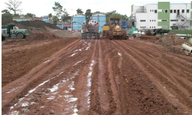
**Foto 55. Mezcla con cemento al 1,5% en peso**
