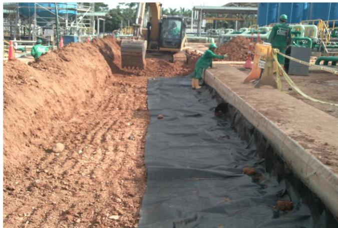
En la foto 36 se muestra como el mejoramiento de algunos puntos de la subrasante donde casualmente se presentaban humedales por nivel freático alto o por filtraciones laterales, se utilizó Geotextil T-1700 como separador de capa, con lo cual se obtuvieron buenos resultados.
