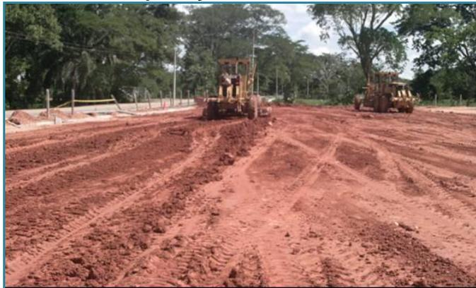
**Foto 12. Acordonado del material escarificado, costado occidental.**
