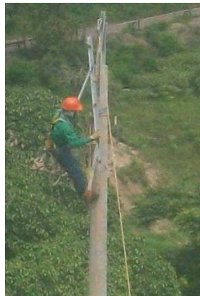
Figura 191. Posicionamiento del liniero en el poste 194
