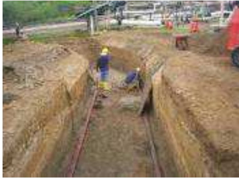
Figura 12. Colocación de escaleras 15
