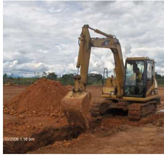
Figura 25. Relleno con retroexcavadora 28
