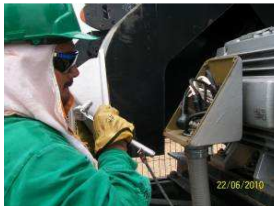
Figura 137. Conexión del motor 140
