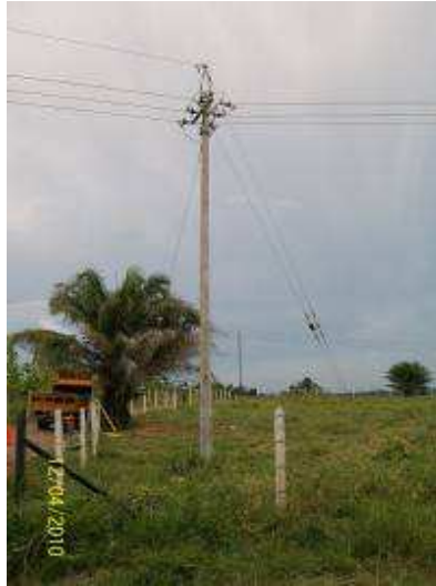
Figura 226. Limpieza en el área de trabajo de la línea 229
