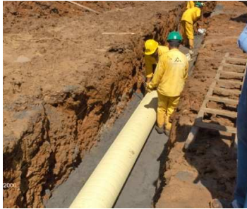
Figura 8. Excavación de zanja 10
