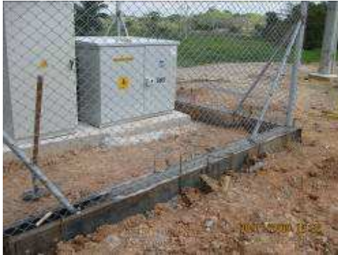
Figura 95. Vaciado de concreto para viga perimetral 98
