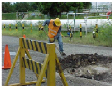
Figura 10. Excavación cerca a cimientos 12
