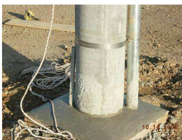
Figura 41. Bajante puesta a tierra del pórtico 44
