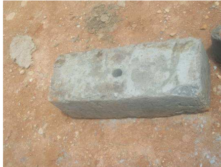
Figura 199. Bloque de concreto para templete 202
