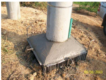
Figura 183. Punta de diamante en poste 186
