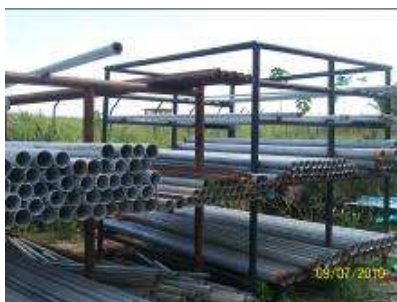
Figura 48. Almacenamiento de tubería conduit 51
