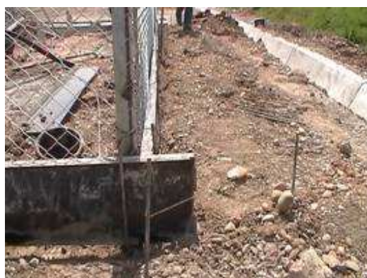
Figura 94. Nivelación de formaletas 97
