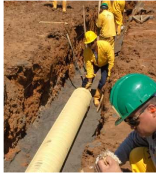
Figura 16. Cama arena para tubería 19
