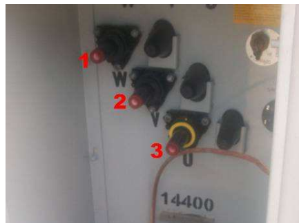
Figura 105. Fases del transformador 108
