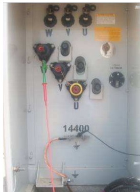
Figura 108. Prueba de aislamiento entre alta tensión y tierra 111
