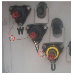
Figura 106. Medición de continuidad entre fases 109
