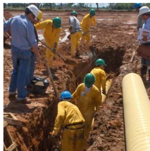
Figura 23. Remoción de escombros 26
