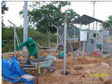
Figura 90. Fundición de concreto 93
