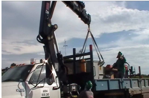
Figura 134 Traslado del motor con grúa 137
