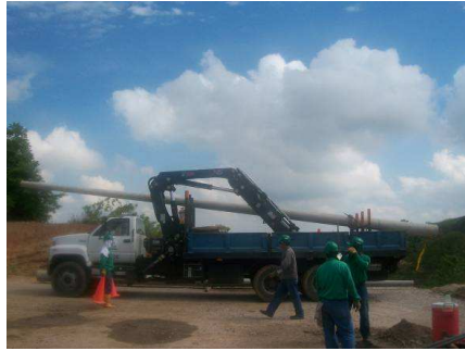
Figura 179. Traslado de postes en Camión-Grúa 182
