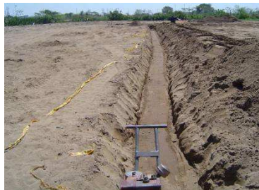
Figura 56. Compactación del terreno 59
