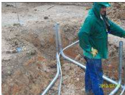
Figura 132. Curvas en tubería conduit 135
