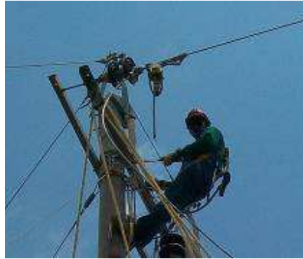
Figura 213. Instalación del diferencial en el cable 216
