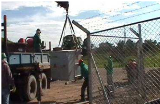
Figura 101. Descarga del transformador 104
