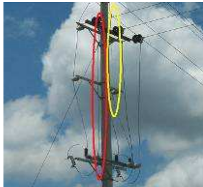
Figura 223. Verificación de distancia entre conductores 226
