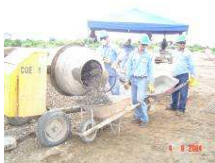
Figura 68. Mezcla de concreto en trompo 71
