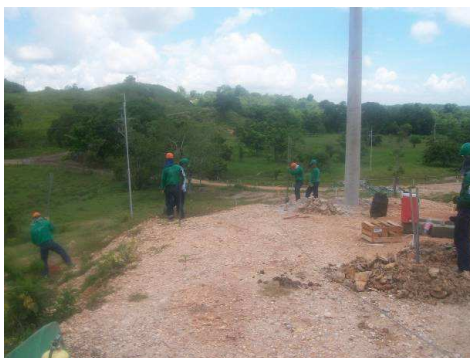
Figura 184. Limpieza en zona de trabajo 187
