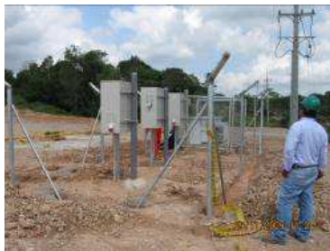
Figura 91. Fundición de concreto para parales 94
