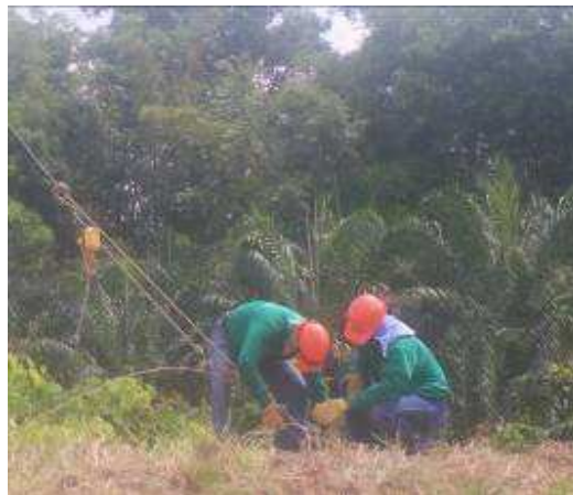
Figura 206. Tensionado del templete 209
