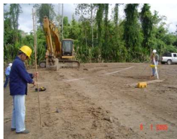
Figura 4. Replanteo de puntos 6
