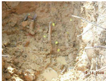
Figura 38. Electrodo de dispersión 41
