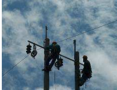
Figura 211. Instalación de poleas en poste 214
