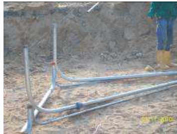
Figura 51. Instalación de tubería conduit 54
