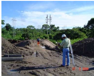
Figura 2. Instalación de equipos topográficos 4
