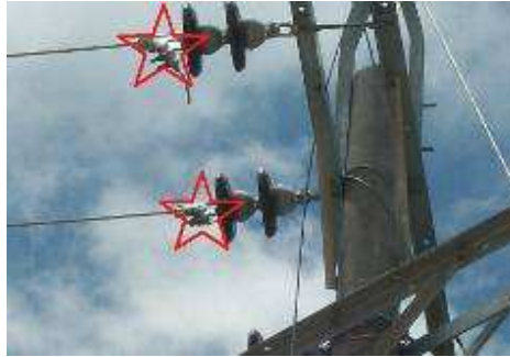
Figura 222. Amarre de conductores 225
