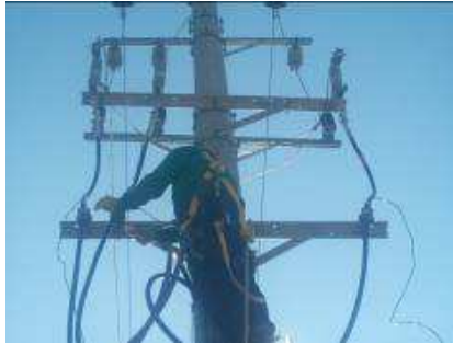
Figura 84. Conexión de premoldeados 87
