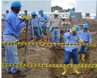
Figura 18. Señalización de excavación 21
