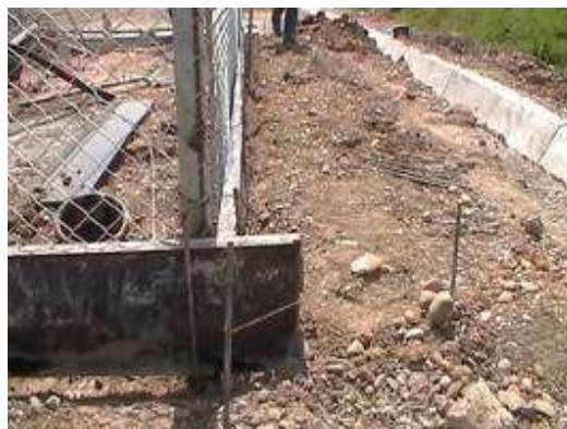
Figura 78. Nivelación de formaletas 81
