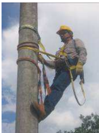
Figura 194. Descenso del poste 197
