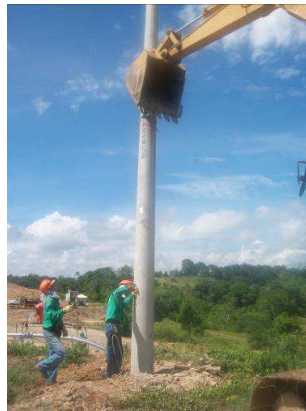
Figura 182. Hincada y aplomada de poste con retroexcavadora 185
