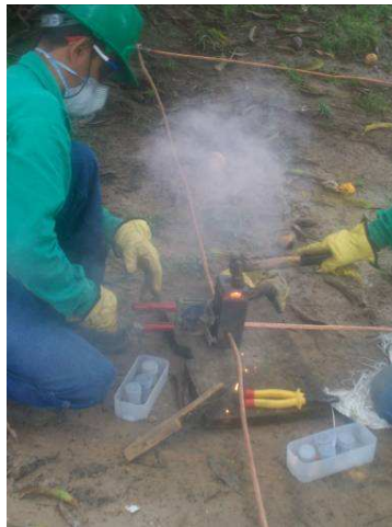
Figura 29. Soldadura Cadwell 32
