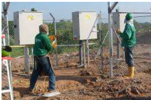
Figura 92. Montaje de malla expansible 95
