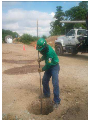
Figura 178. Excavación de poste 181
