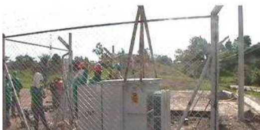
Figura 102. Nivelación del transformador 105
