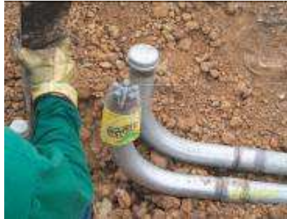
Figura 113. Tapón en extremos de tubería conduit (Provisionales) 116
