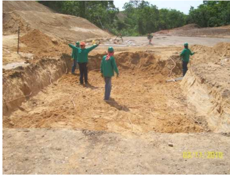
Figura 19. Perfilado en excavación 22
