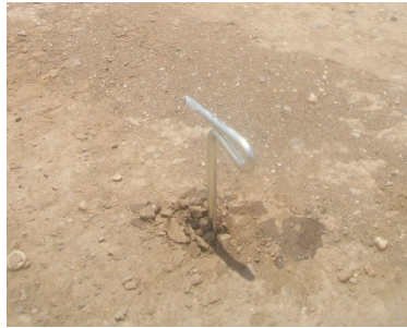
Figura 146. Puesta de electrodo en terreno 149
