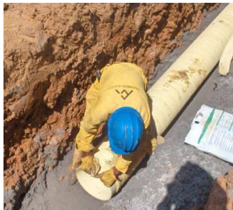
Figura 17. Instalación de tubería 20
