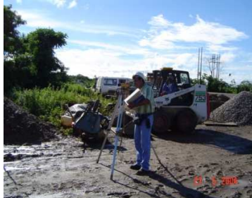
Figura 3. Verificación de ejes 5
