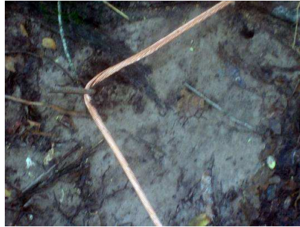
Figura 27. Estacado de la malla 30
