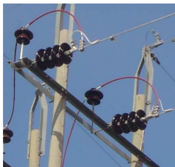
Figura 195. Terminación de vestida de estructura 198
