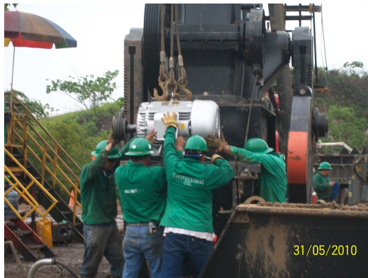
Figura 135. Montaje de motor en pozo 138
