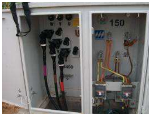
Figura 159. Marcado de cables por colores 162
