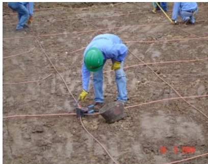
Figura 34. Instalación de malla de puesta a tierra 37
