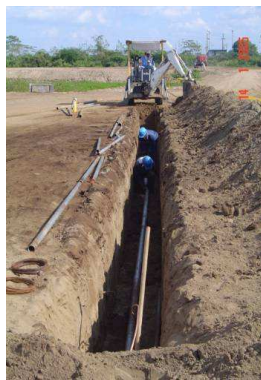
Figura 54. Tendido de tubería conduit 57
