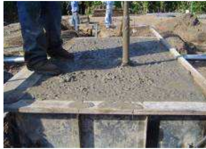
Figura 69. Vaciado del concreto 72
