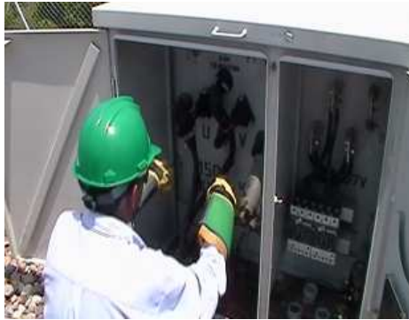
Figura 121. Implementos de seguridad para medición del cable 124
