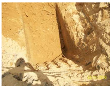
Figura 46. Instalación de contrapesos en malla 49
