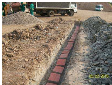
Figura 55. Concreto de señalización en tendido de tubería conduit 58
