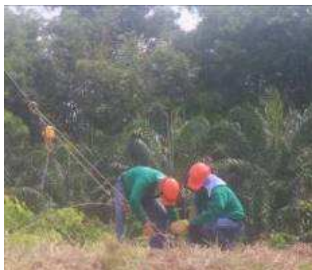
Figura 208. Tensionado con diferencial del templete 211
