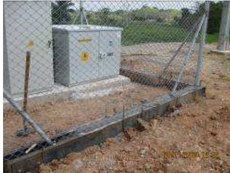
Figura 79. Vaciado de concreto 82
