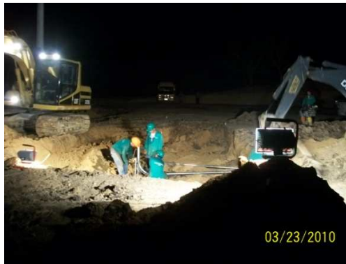
Figura 20. Luminarias en excavación 23
