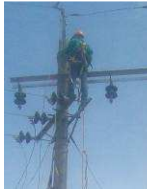
Figura 203. Instalación del cuello del templete 206
