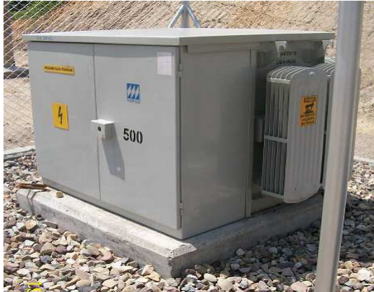
Figura 164. Nivelación de la subestación 167
