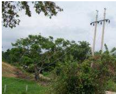
Figura 212. Tendido de cable 215
