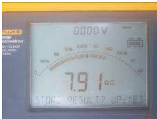
Figura 123. Lectura del megguer en prueba de aislamiento de cables 126
