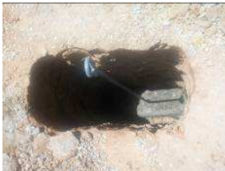
Figura 207. Anclaje de templete 210
