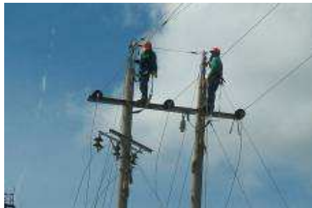
Figura 216. Aplicación de tensión 219
