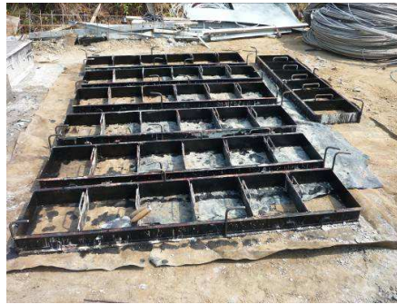
Figura 198. Vaciado de concreto en moldes 201
