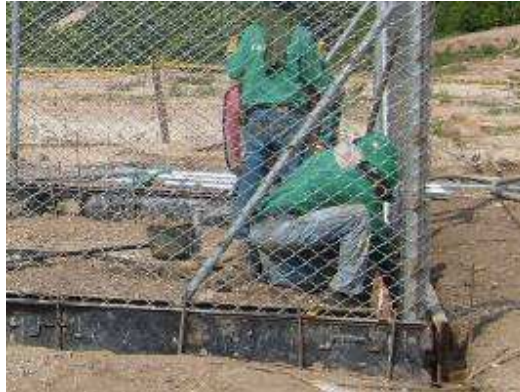
Figura 77. Colocación de formaletas 80
