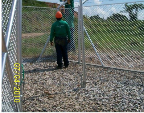
Figura 97. Colocación de gravilla en subestación 100
