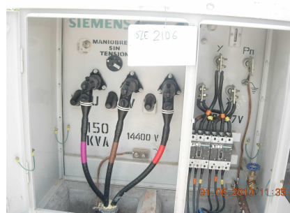
Figura 129. Marcado decables 132
