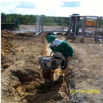
Figura 40. Compactación del terreno con saltarin 43
