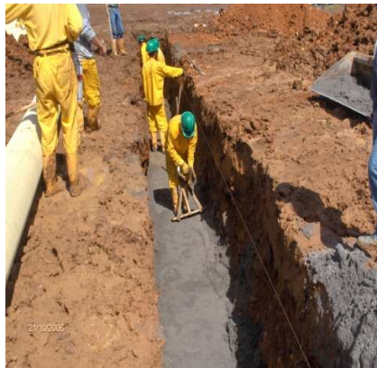
Figura 13. Solado en zanja 16
