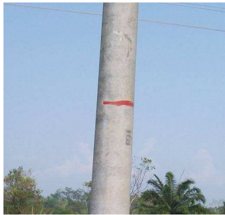
Figura 181. Marca de centro de gravedad del poste 184
