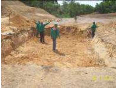
Figura 33. Excavación malla de puesta a tierra 36
