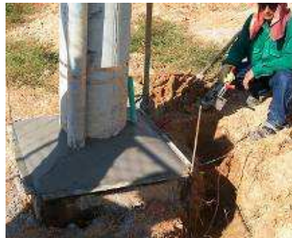
Figura 221. Instalación de puesta a tierra en poste 224
