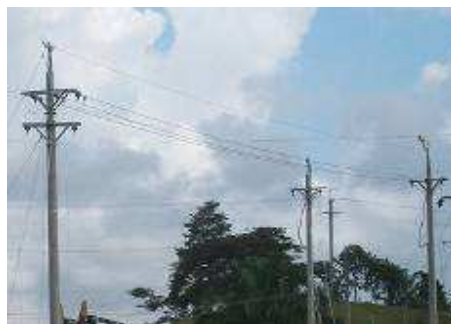
Figura 218. Verificación de los vanos 221
