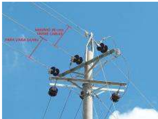
Figura 220. Verificación de distancia entre cables 223
