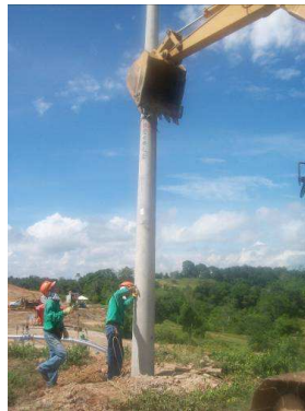
Figura 82. Hincado y aplomado de poste 85
