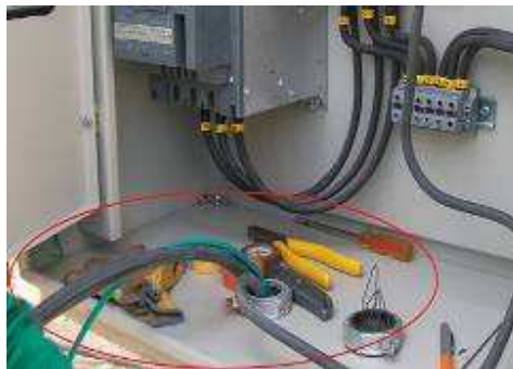
Figura 118. Cortado de cable 121
