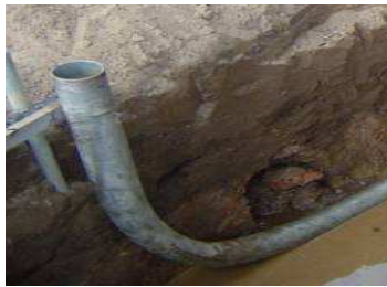
Figura 52. Curvas en tubería conduit 55
