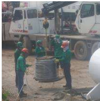
Figura 210. Descargue de carrete 213
