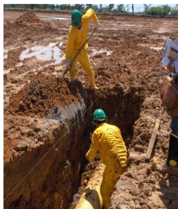
Figura 21. Relleno manual 24
