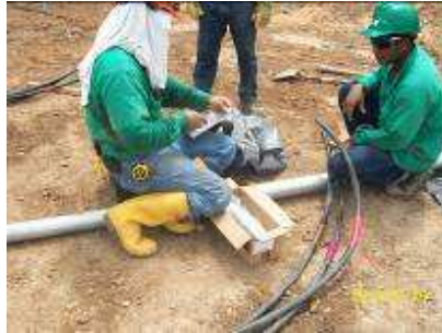
Figura 111. Inspección del cable 114
