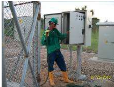
Figura 114. Introducción de soga de halado 117
