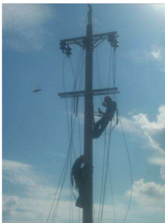
Figura 193. Instalación de crucetas 196
