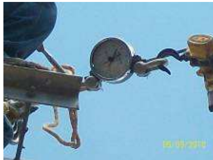
Figura 217. Verificación de tensión 220
