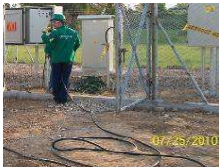
Figura 112. Limpieza del cable 115
