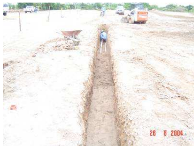
Figura 53. Excavación de zanja 56
