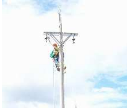
Figura 215. Ascenso del cable 218
