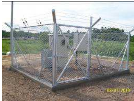
Figura 80. Fundición de concreto 83
