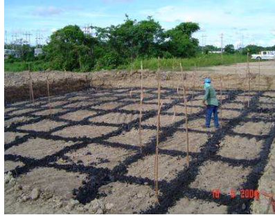
Figura 39. Recubrimiento de la malla con Coque 42
