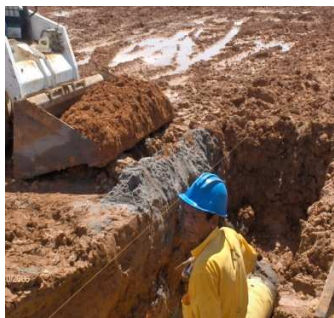
Figura 22. Relleno con maquina 25
