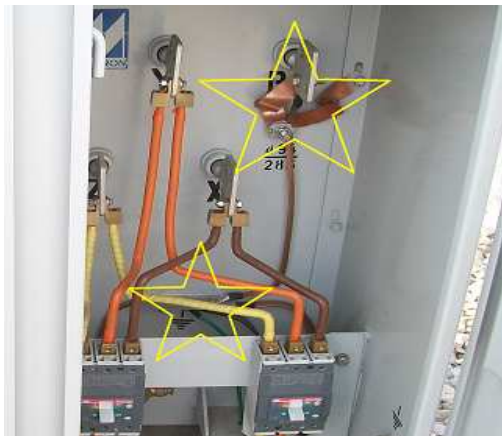
Figura 165. Aterrizaje del neutro y la tierra 168
