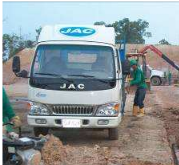
Figura 89. Transporte de materiales 92
