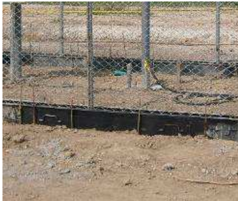
Figura 76. Lubricación y colocación de formaletas 79
