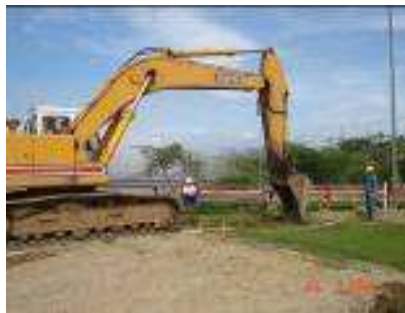
Figura 9. Excavación con retroexcavadora 11
