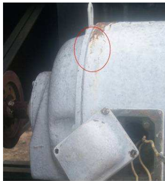
Figura 138. Verificación placa del motor 141
