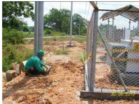
Figura 70. Fraguado del concreto 73
