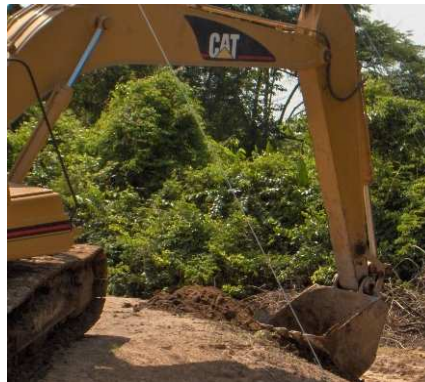
Figura 174. Primera capa del terraplen 177
