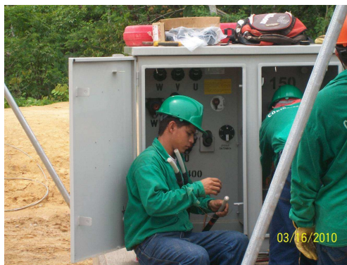
Figura 120. Corte en puntas para medición 123
