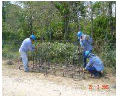
Figura 67. Refuerzos en varilla para concreto 70
