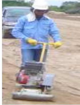
Figura 177. Compactación de terraplén en la base 180
