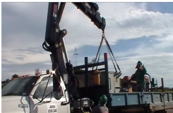
Figura 99. Transporte del transformador 102
