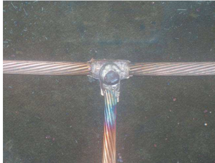
Figura 30. Uniformidad en soldadura cadwell 33
