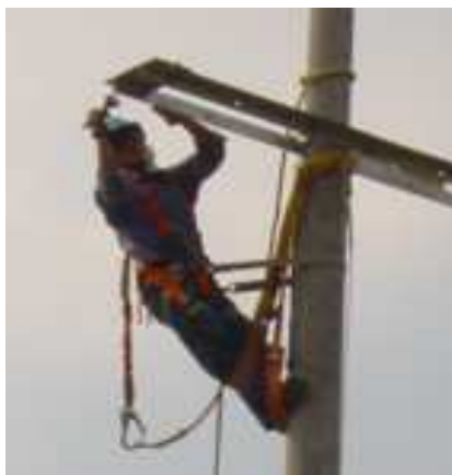
Figura 192. Fijación de pernos, tuercas y herrajes 195
