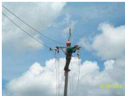
Figura 214. Tensionado del cable 217
