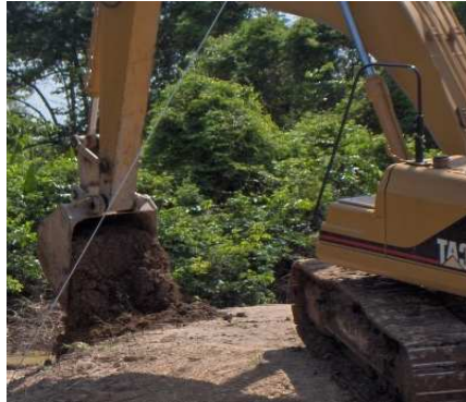
Figura 175. Conformación del terraplén y nivelación 178
