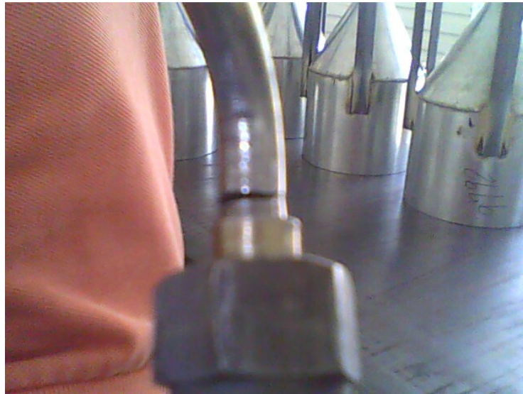
Figura 35. Falla del tubo que comunica al inyector
