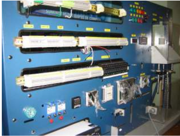
Figura 10. Montajes tanques válvulas manuales y solenoides [7]
