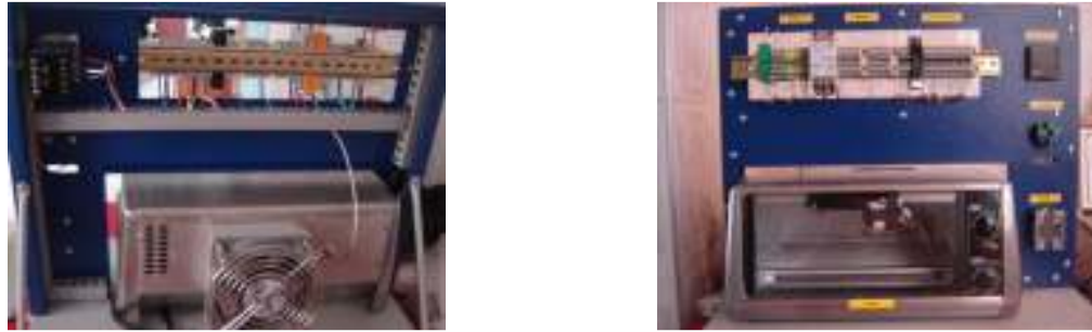
Figura21. Construcción modulo control de temperatura [7]
