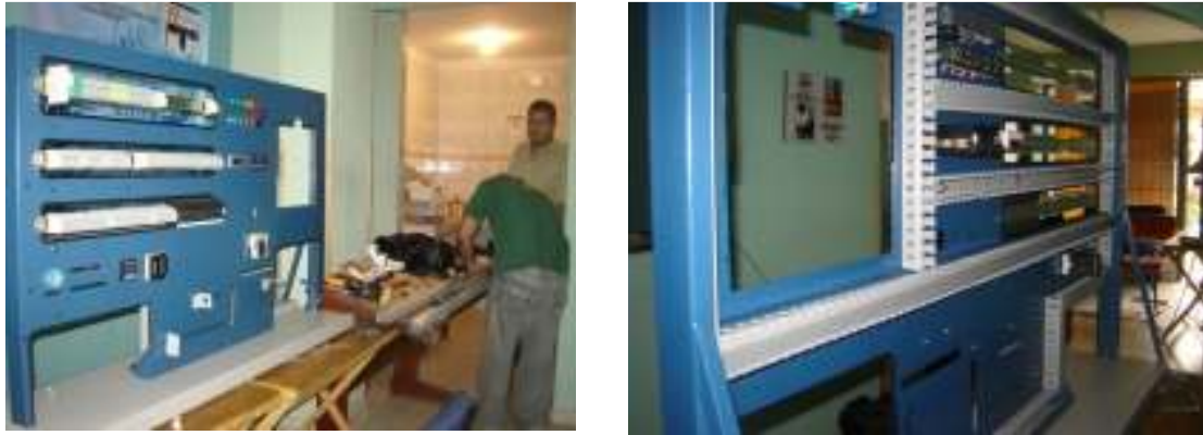
Figura 8. Cortes y adecuación de canaletas [7]
