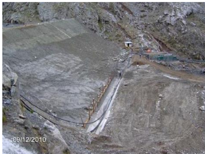
Imagen 15. Relaves con Obras para el manejo y aislamiento de aguas lluvia
