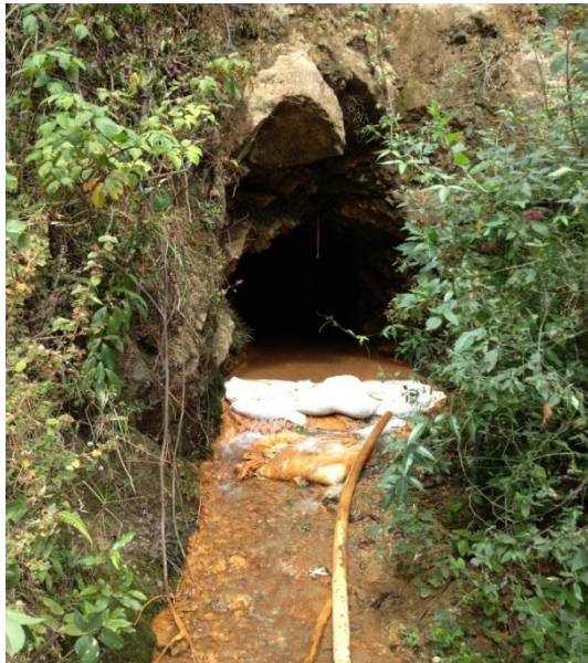
Imagen 26. Túnel de Minería Artesanal Abandonado en California Santander
