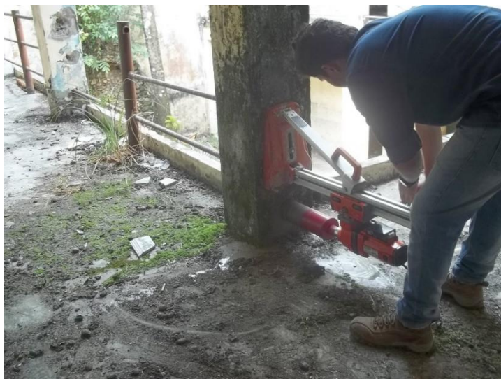
Ilustración 23: Extracción de núcleo en columna del segundo nivel (Autor).
