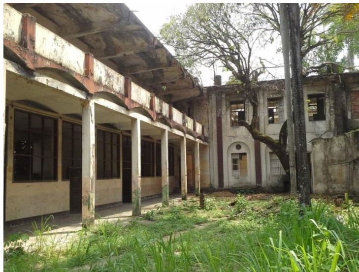
Ilustración 7: interior de la estructura (Autor).
