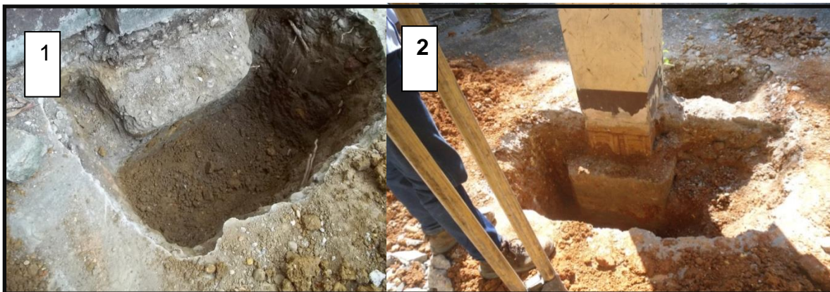
Ilustración 21: Zapata sobre viga de cimentación perimetral (1), Zapata central (2) (Autor).
