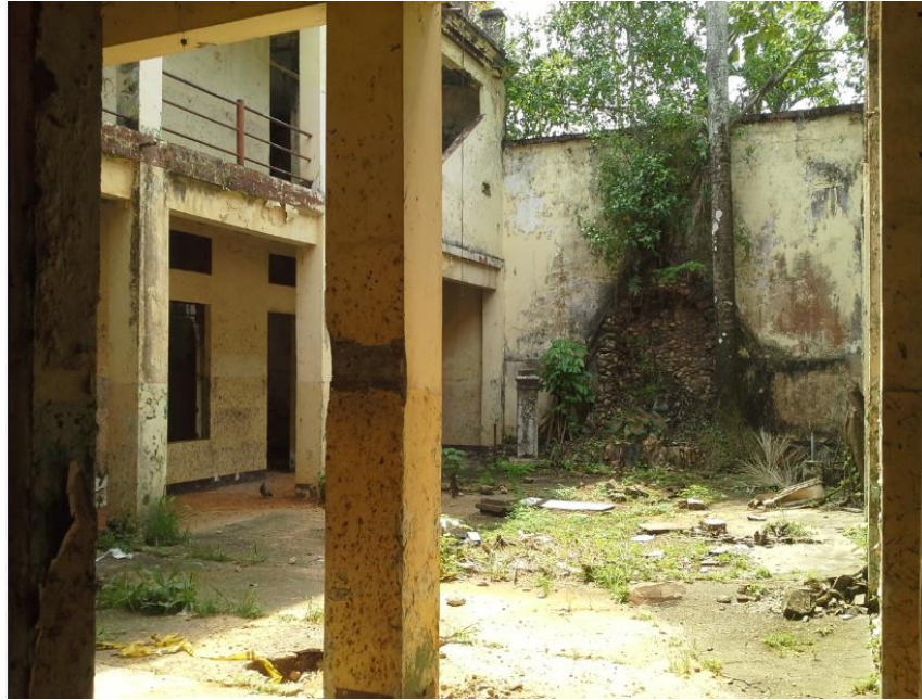
Ilustración 6: interior de la estructura (Autor).
