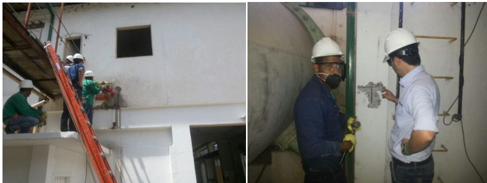
Ilustración 2: Extracción de núcleos y trabajos de regatas en vigas y columnas de la Planta Cascada (Autor).
