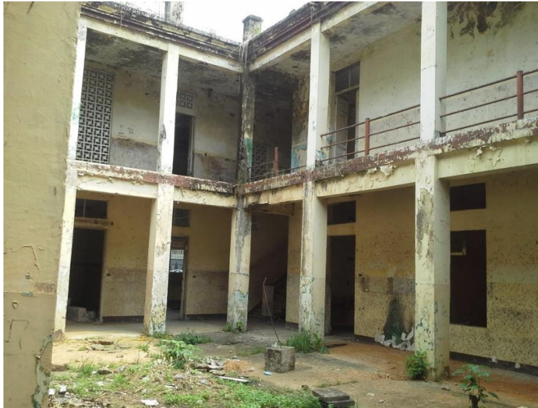
Ilustración 8: Interior de la estructura (Autor).
