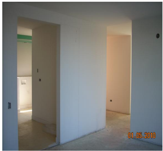
Estuco y pintura blanca FOTO 7
