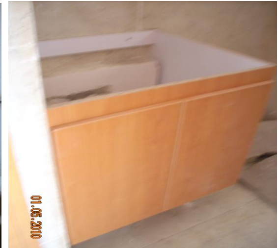
Carpintería de baños FOTO 9
