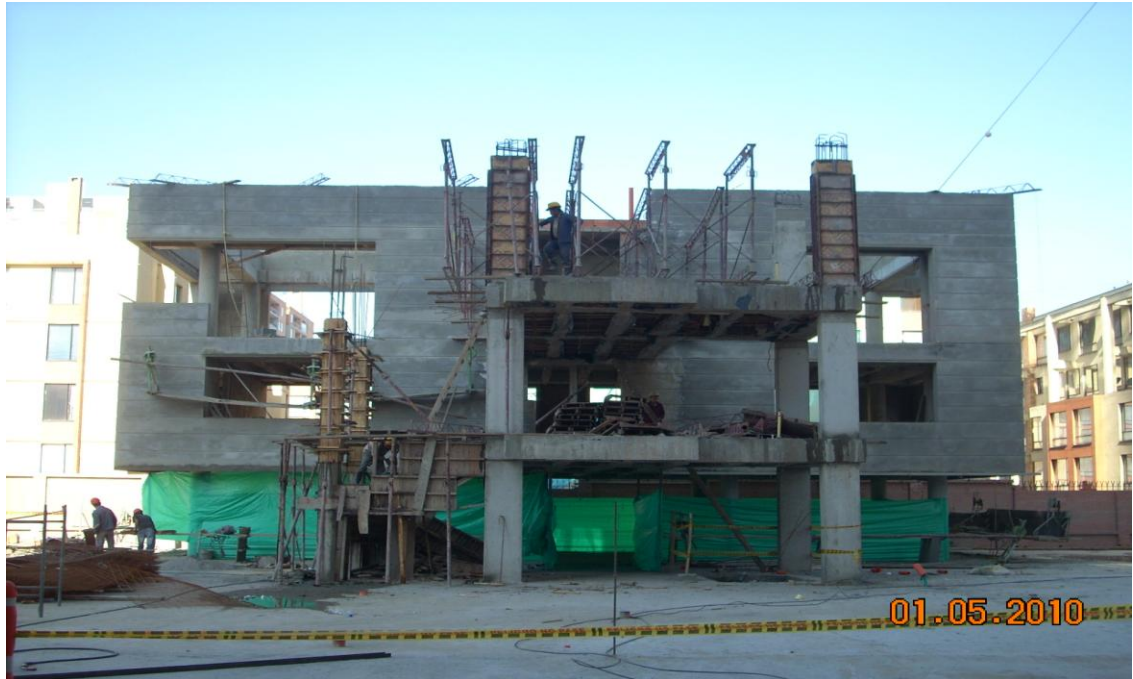
FOTO 13. Vista desde torre 2. Salón comunal
