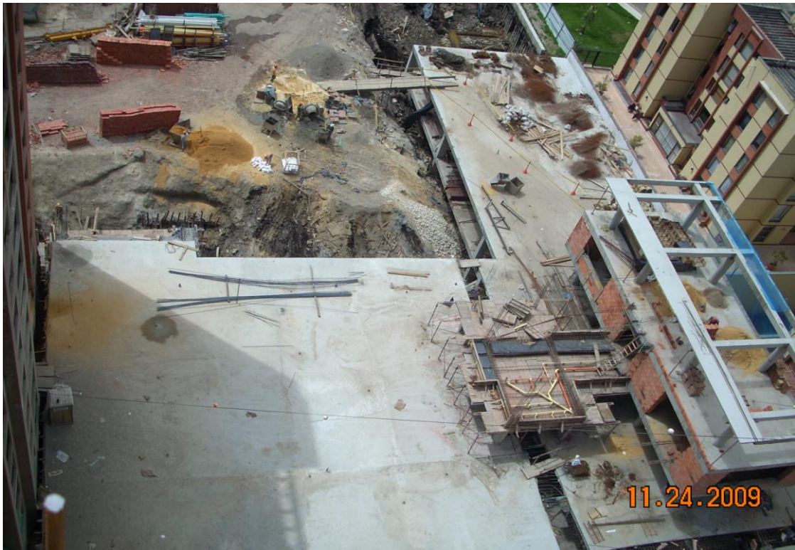
FOTO 12. Vista superior de plataformas del proyecto CVE 1
