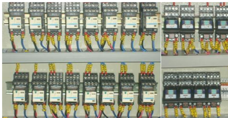
Figura 94. Instalación de la etapa de acondicionamiento de señal. [74]
