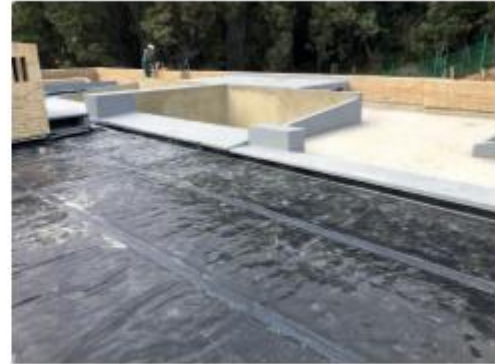
Figura 27. Sistema de impermeabilización paraseal. Fuente: Toxement (2020)
