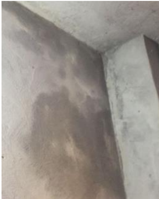
Figura 3. Humedad de construcción. Fuente: propia.
