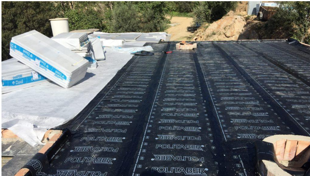
Figura 28. Impermeabilización con láminas SBS-POLITABER. Fuente: Chova (2021)
