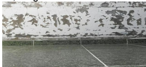
Figura 19. Elemento analizado con eflorescencia.
