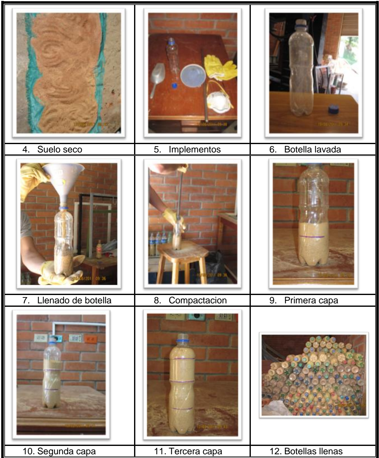
Continuación Figura 24. Llenado De Botellas PET. Fuente: Propia
