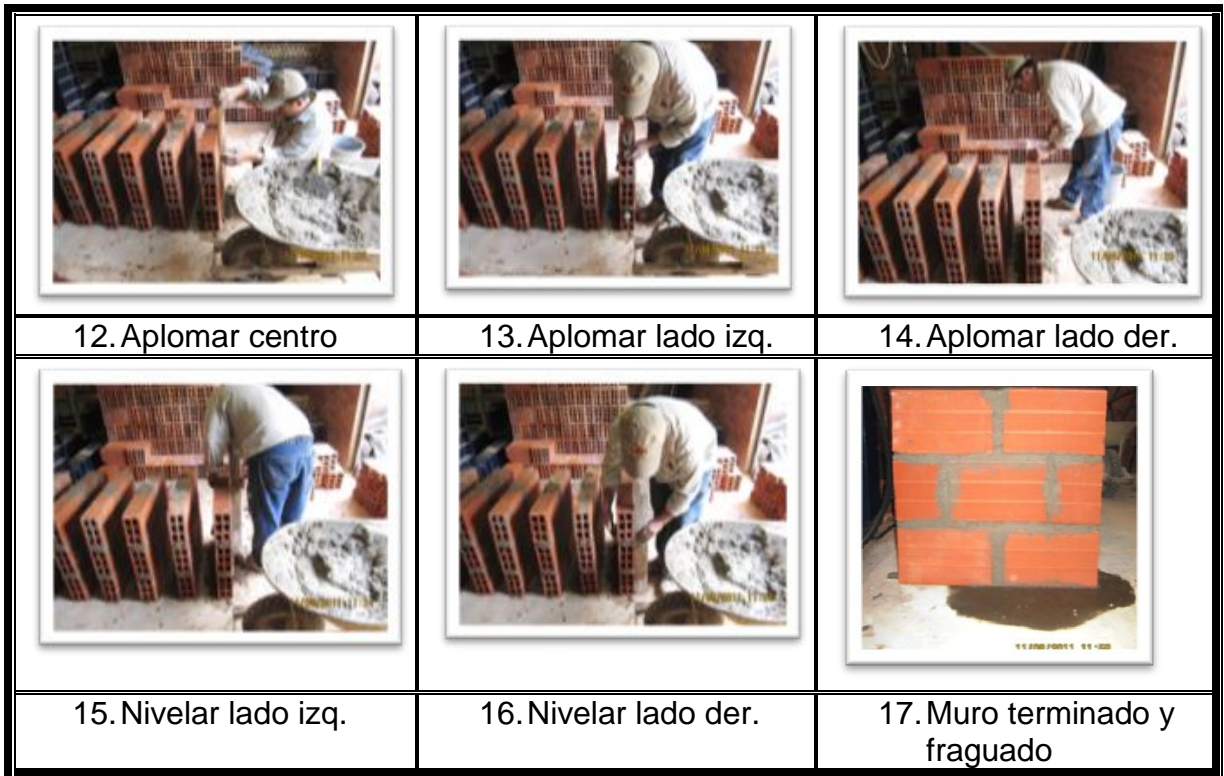
Continuación Figura 22. Construcción de Muretes Tradicionales. Fuente: Propia
