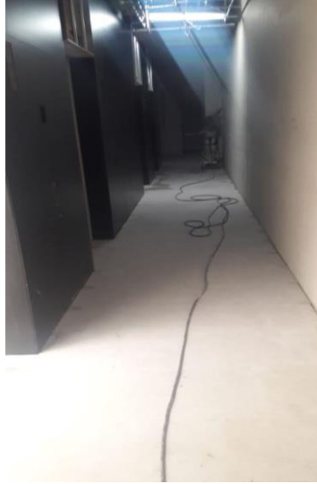
Figura 24. Destronque en pasillo de lobby.
