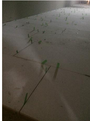
Figura 18. Detalle de distanciadores puestos en baldosas de mármol
