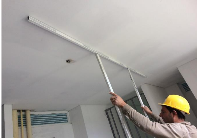
Figura 39. Revisión de nivel
