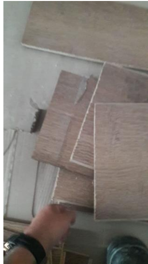
Figura 54. Corte con pulidora erróneo.
