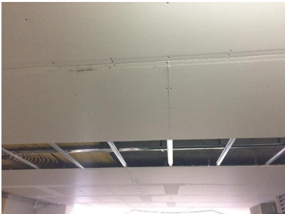
Figura 36. Detalle uniones de láminas con tornillos
