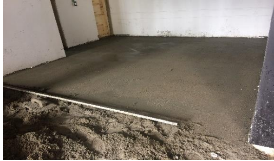
Figura 8. Nivelación manual de mortero
