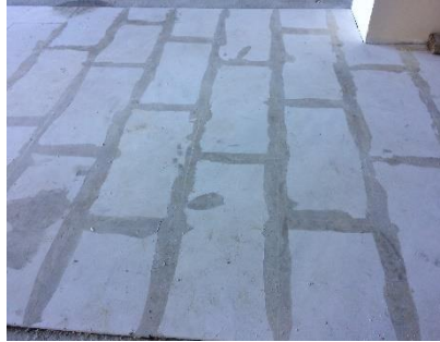
Figura 20. Ston mix aplicado en juntas de baldosas de marmol.
