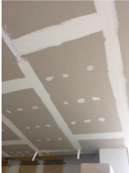
Figura 35. Resane de uniones y tornillos con masilla y cinta
