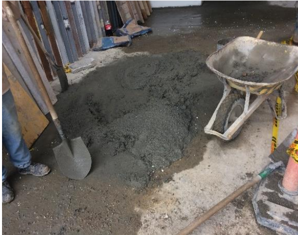
Figura 6. Mezcla de mortero 1:3
