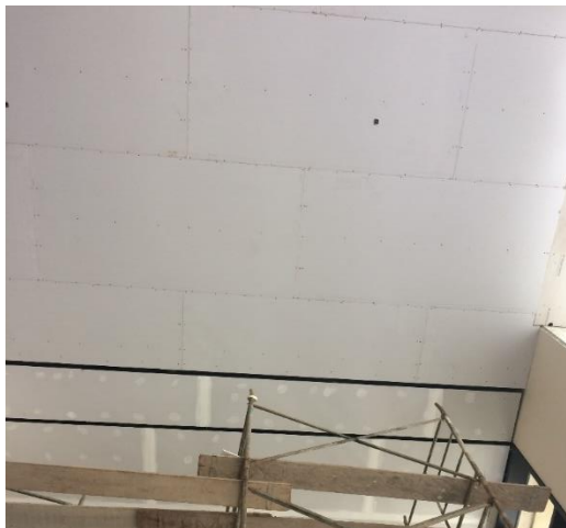
Figura 34. Conformación del cielo raso completo.
