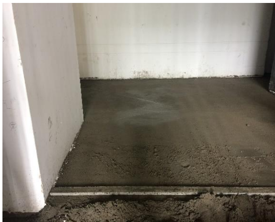
Figura 7. Distribución del mortero.
