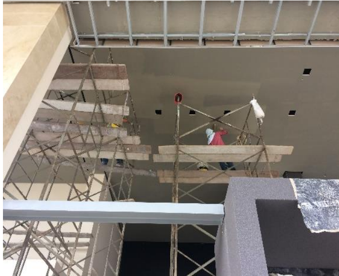
Figura 38. Aplicación de pintura final de cielo raso parte alta.
