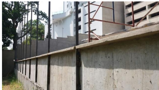
Figura 49. Detalle anclaje de tubos.
