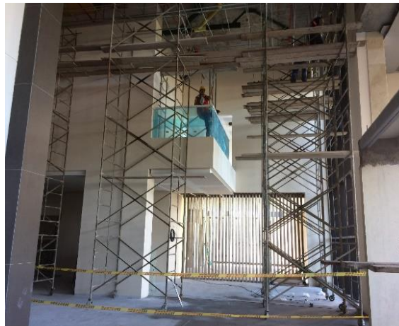
Figura 29. Instalación de andamio tipo cruceta
