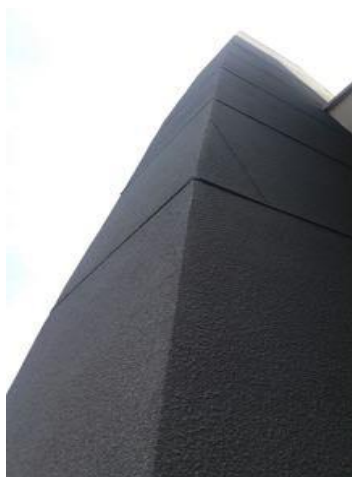
Figura 44. Detalle dilataciones piso 33 – 37
