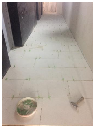
Figura 17. Detalle de pasillo en lobby enchapado.
