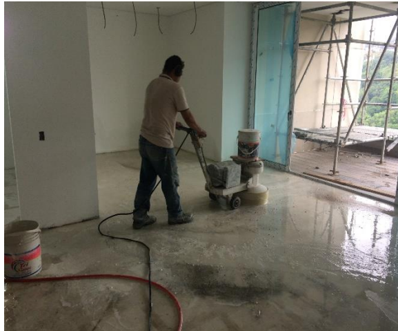
Figura 53. Pulido de mármol apto 3102
