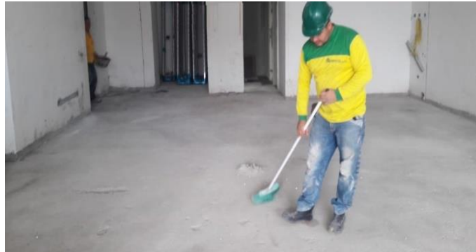
Figura 14. Limpieza del sustrato.
