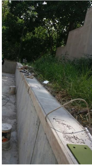
Figura 48. Encofrado de alfajías en canchas.
