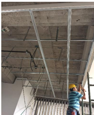
Figura 31. Fijación de estructura metálica
