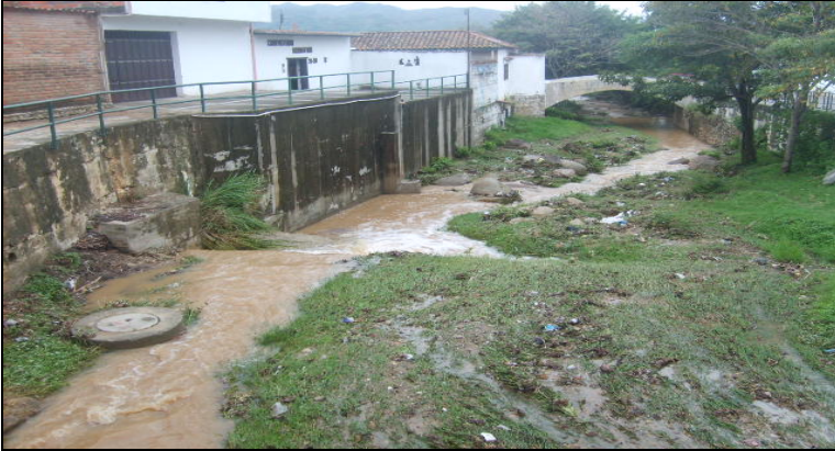
Figura 10. Canalización Quebrada Las Nieves en la zona urbana
