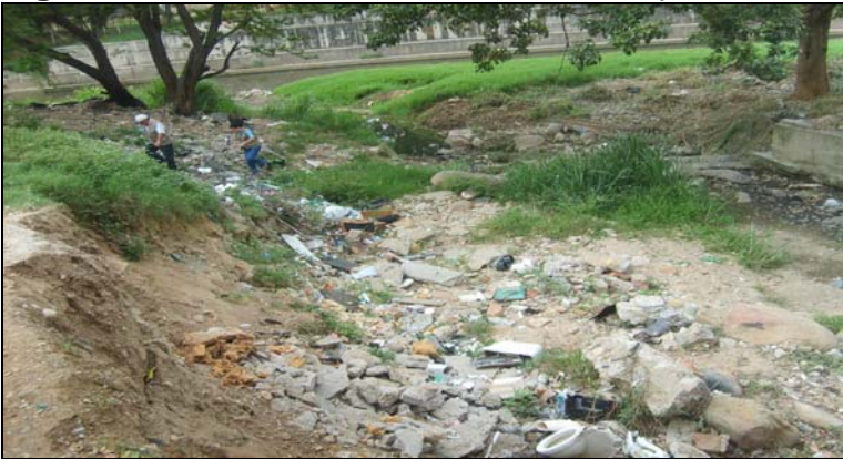
Figura 11. Falta de mantenimiento de la quebrada
