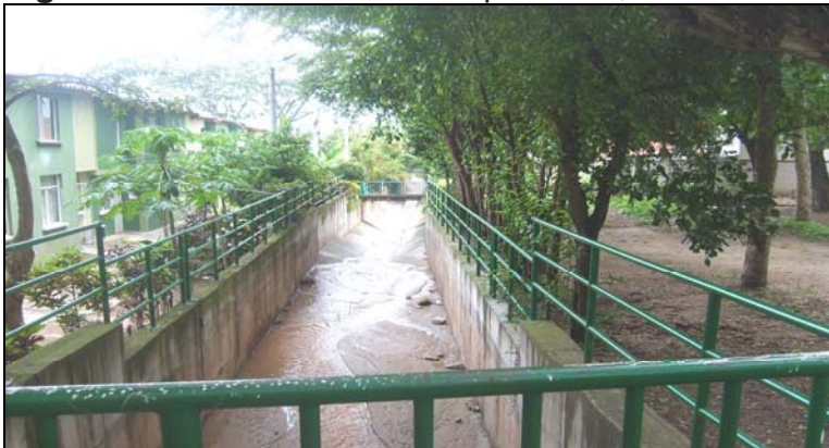
Figura 24. Canalización de la quebrada, Barrio San Antonio del Carrizal
