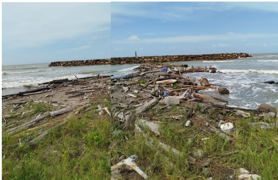
Figura 27 Foto en campo obra #3
