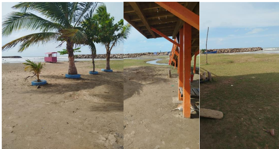
Figura 37 Foto en campo Obra #8
