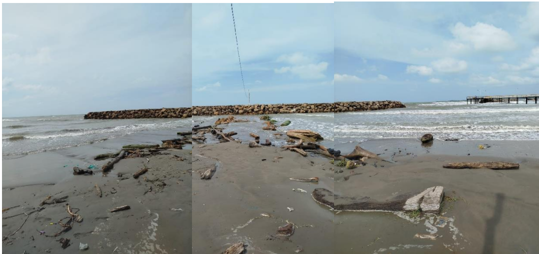
Figura 33 Foto en campo Obra #6
