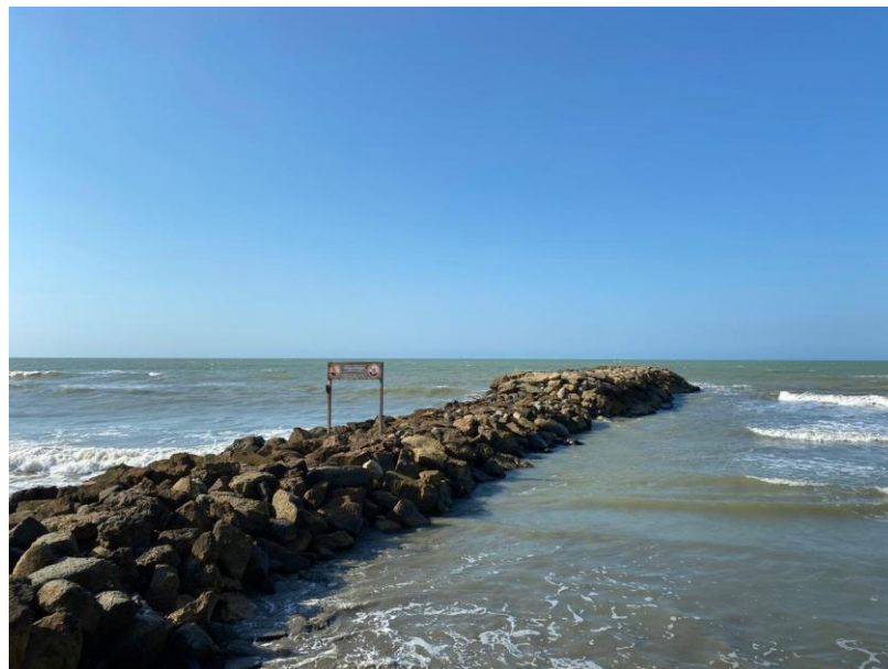
Figura 23 Foto en campo Obra #1
