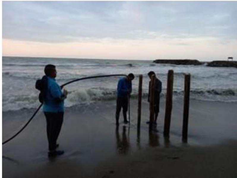
Figura 47 Resultado esperado hincado de troncos. Fuente: (Gobernación de Antioquia, 2023)
