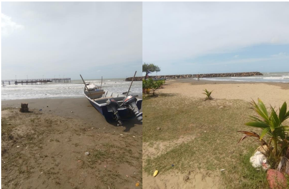
Figura 35 Foto en campo Obra #7
