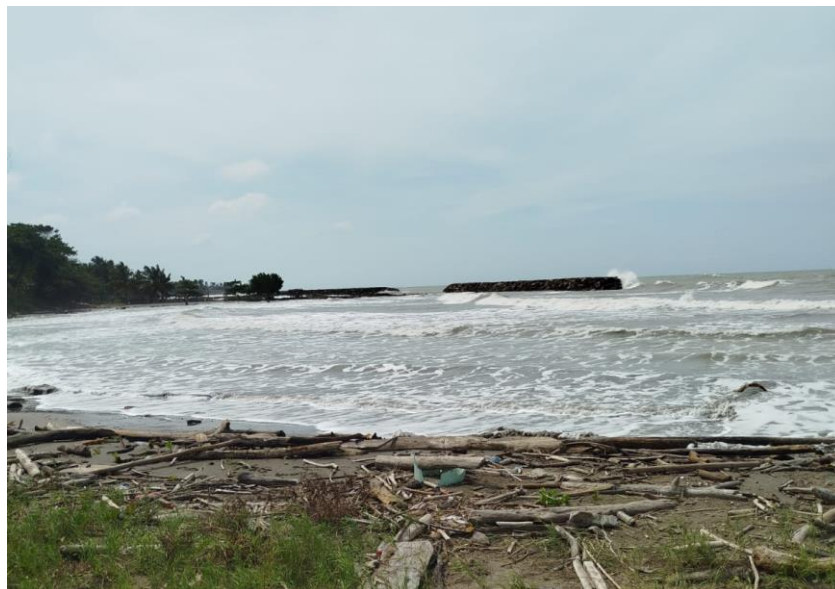
Figura 25 Foto en campo Obra #2
