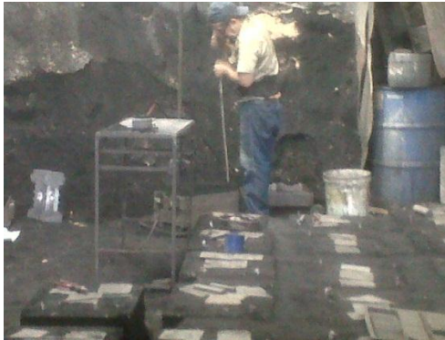
Figura 37. Proceso de Compactar la Arena
