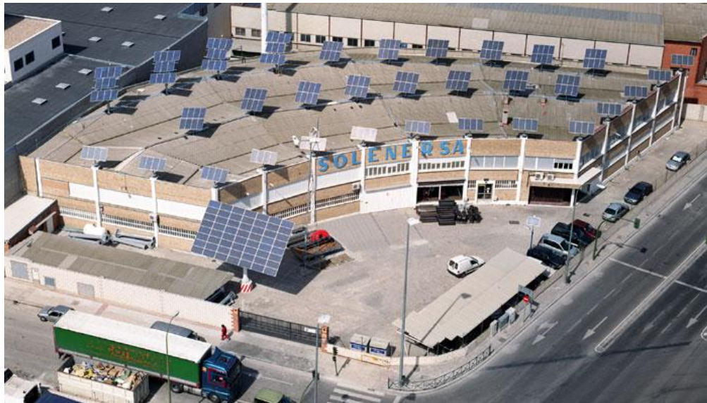
Figura 18. Instalaciones Soluciones Energéticas
