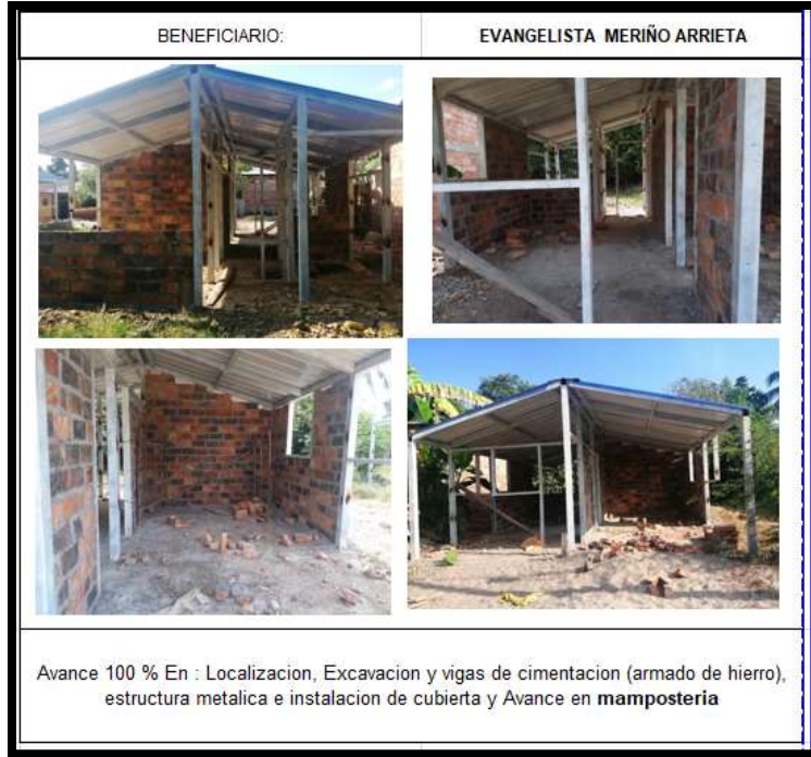
Ilustración 35. Registro fotográfico N°4 construcción de vivienda en Puerto Wilches, Santander
