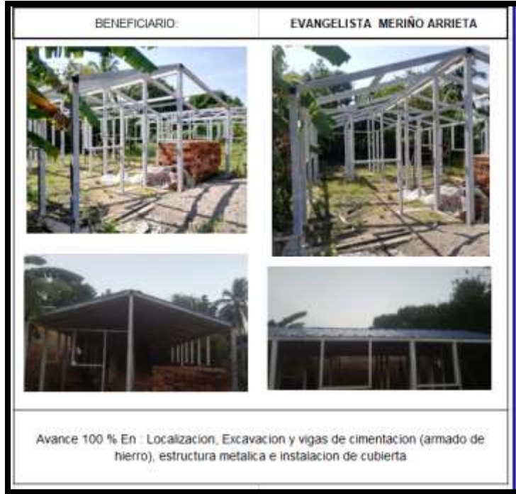
Ilustración 23. Registro fotográfico N°2 construcción de vivienda en Puerto Wilches, Santander.
