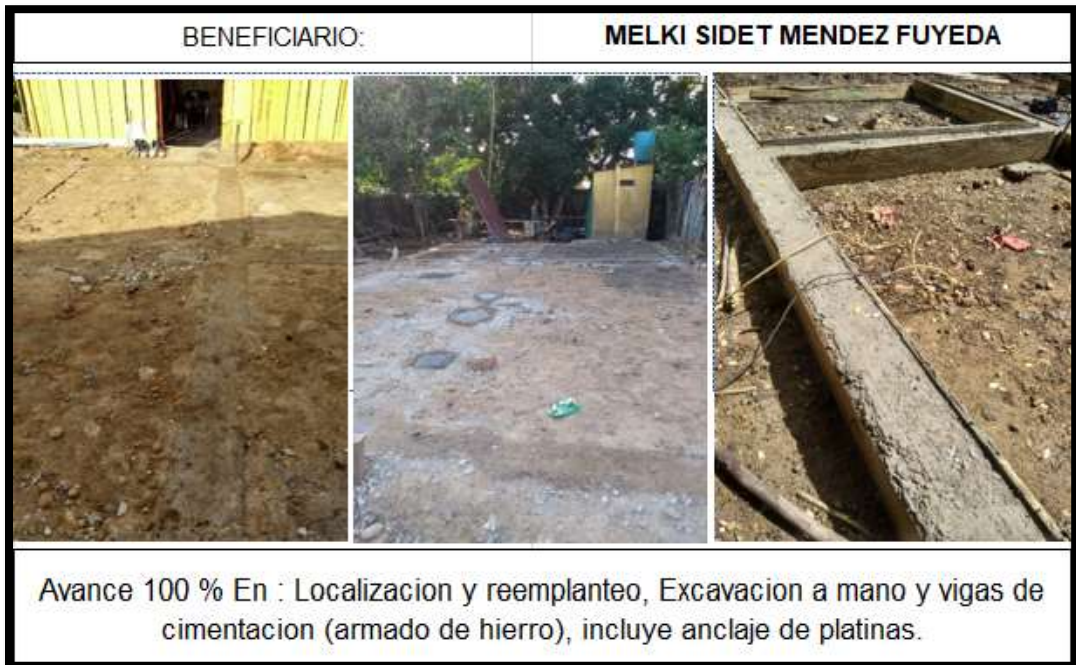
Ilustración 17. Registro fotográfico N°1 construcción de vivienda en Puerto Wilches, Santander.
