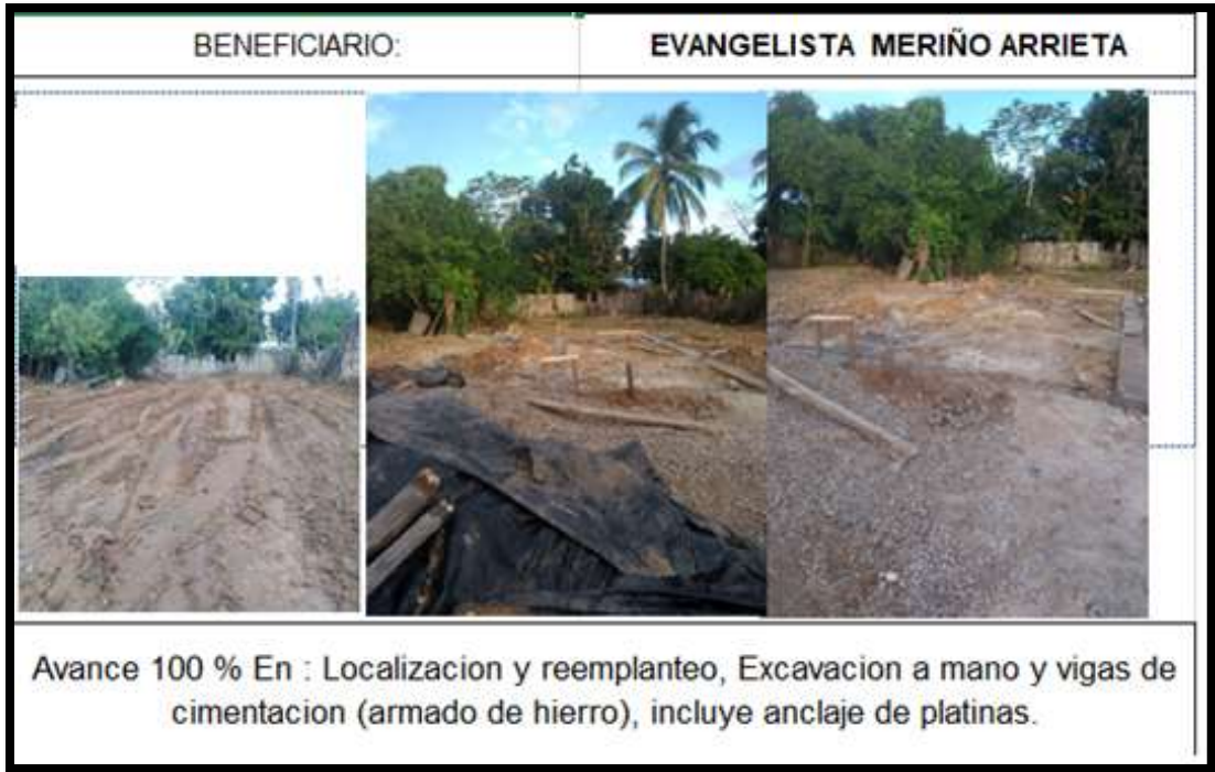
Ilustración 16. Registro fotográfico N°1 construcción de vivienda en Puerto Wilches, Santander.
