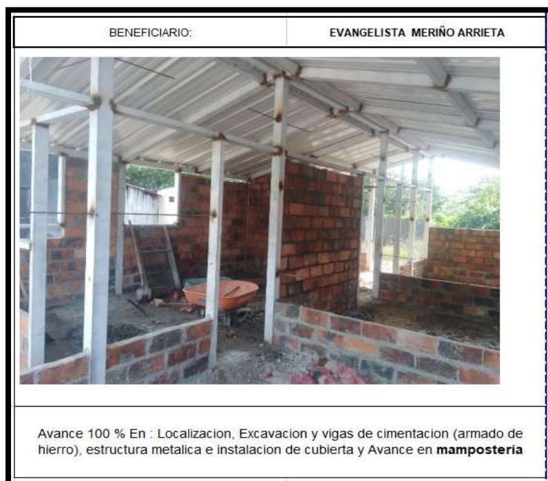
Ilustración 29. Registro fotográfico N°3 construcción de vivienda en Puerto Wilches, Santander
