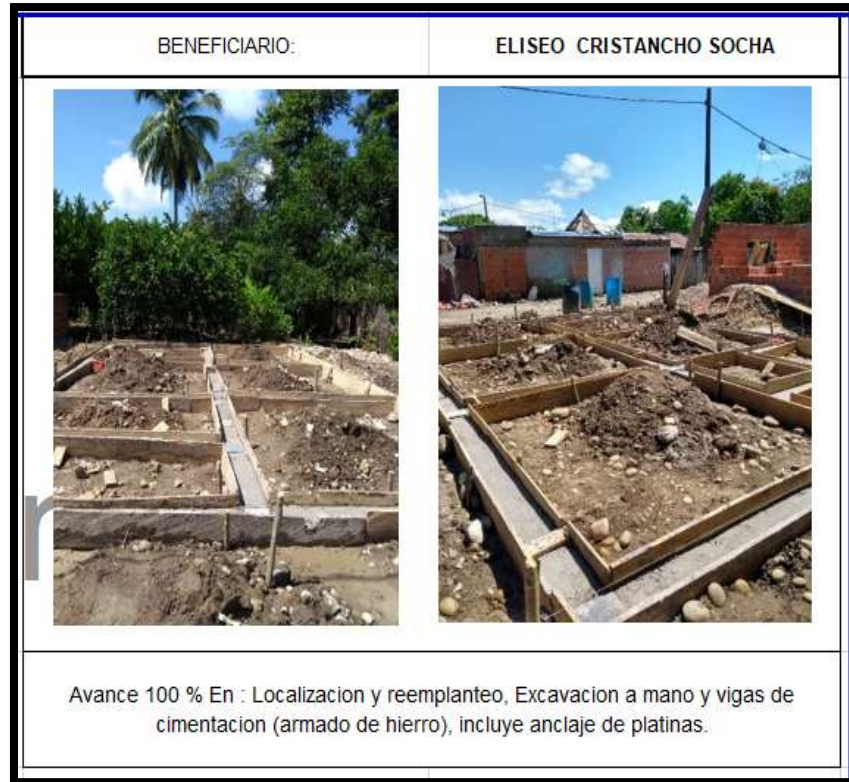
Ilustración 25. Registro fotográfico N°2 construcción de vivienda en Puerto Wilches, Santander.
