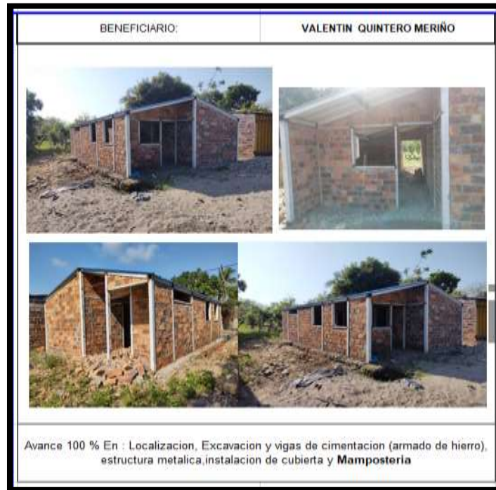
Ilustración 36. Registro fotográfico N°4 construcción de vivienda en Puerto Wilches, Santander
