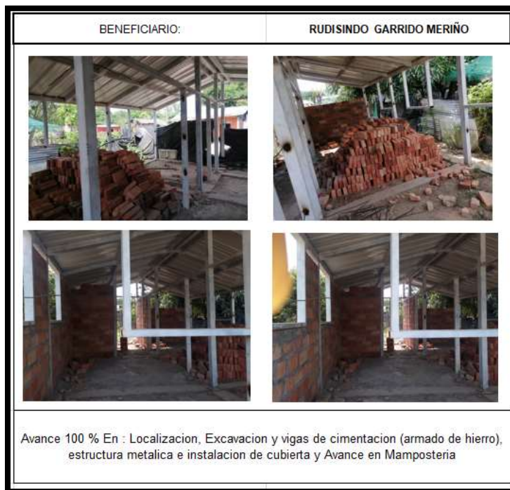
Ilustración 34. Registro fotográfico N°4 construcción de vivienda en Puerto Wilches, Santander
