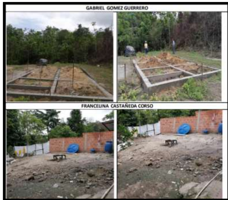
Ilustración 38. Registro fotográfico N°1 construcción de vivienda en Sabana de Torres, Santander.
