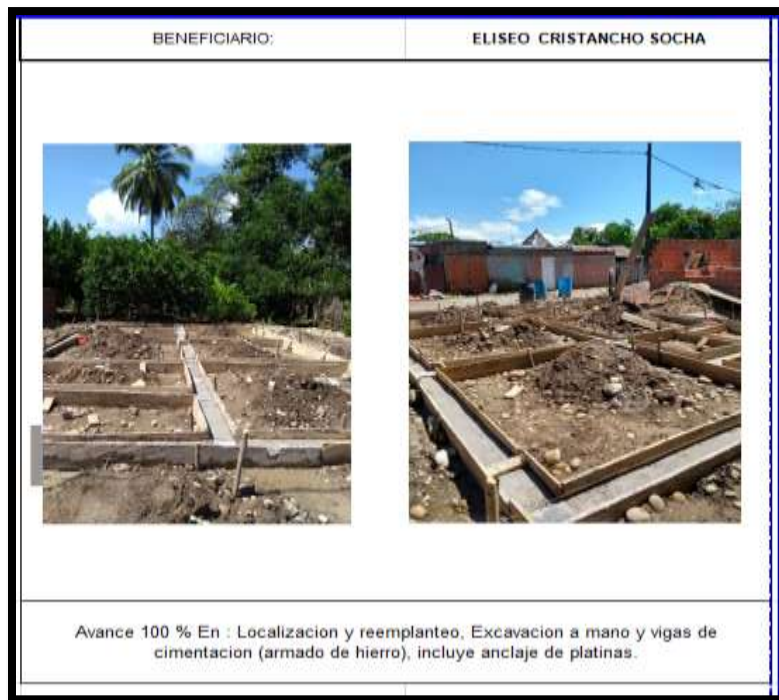
Ilustración 37. Registro fotográfico N°4 construcción de vivienda en Puerto Wilches, Santander
