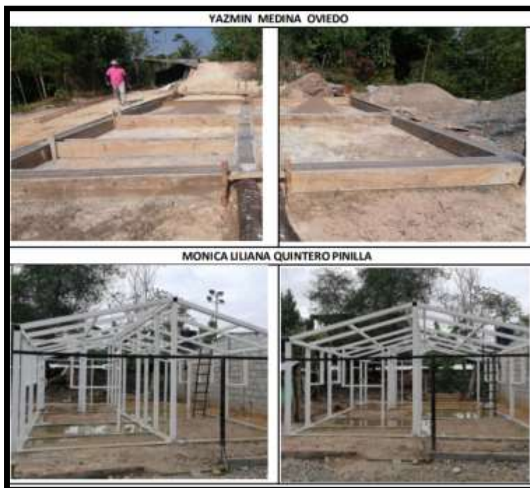
Ilustración 40. Registro fotográfico N°1 construcción de vivienda en Sabana de Torres, Santander.
