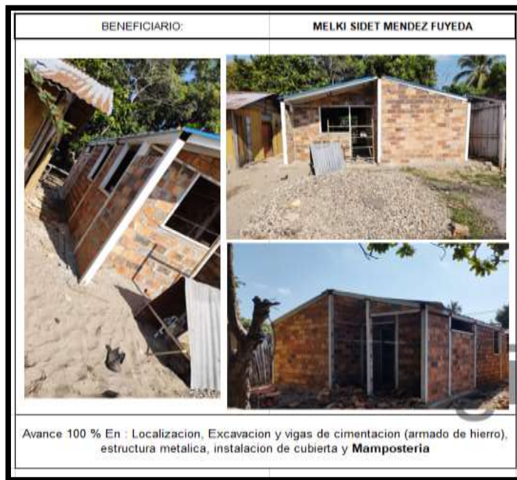
Ilustración 32. Registro fotográfico N°4 construcción de vivienda en Puerto Wilches, Santander
