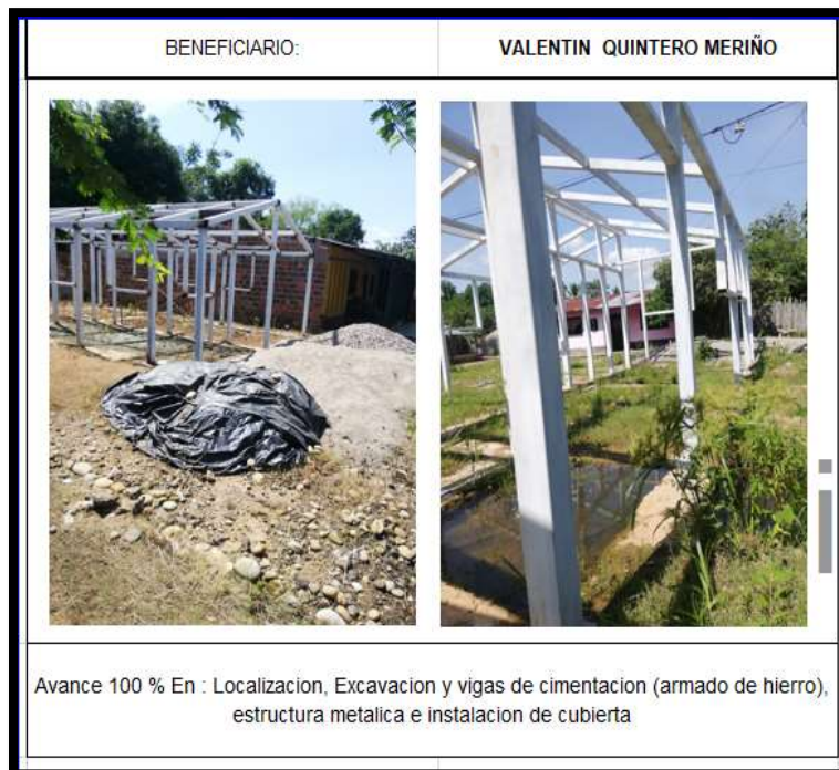
Ilustración 24. Registro fotográfico N°2 construcción de vivienda en Puerto Wilches, Santander.
