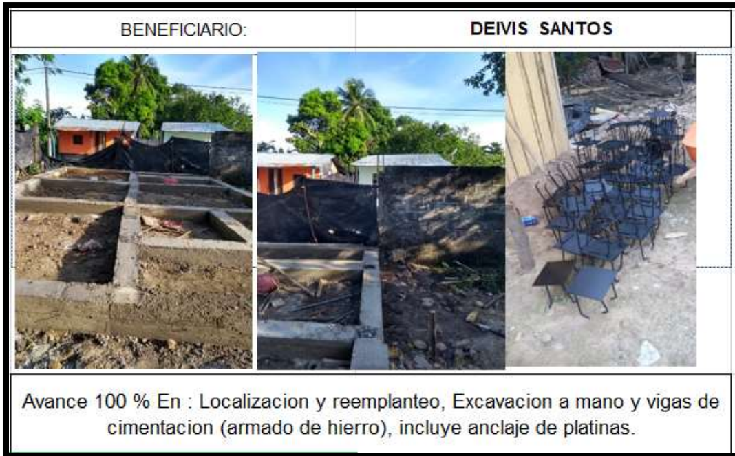
Ilustración 14. Registro fotográfico N°1 construcción de vivienda en Puerto Wilches, Santander.
