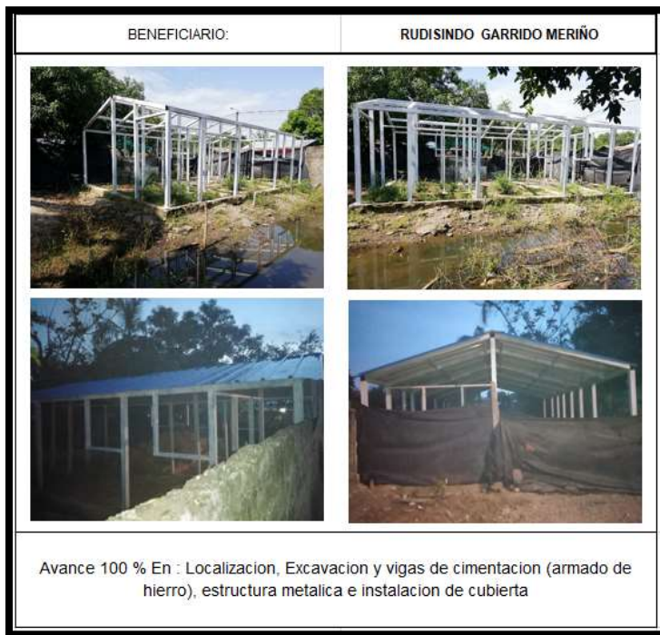
Ilustración 28. Registro fotográfico N°3 construcción de vivienda en Puerto Wilches, Santander
