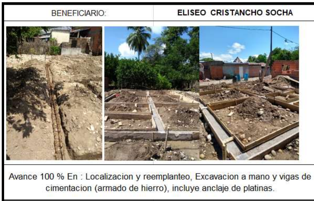
Ilustración 15. Registro fotográfico N°1 construcción de vivienda en Puerto Wilches, Santander.
