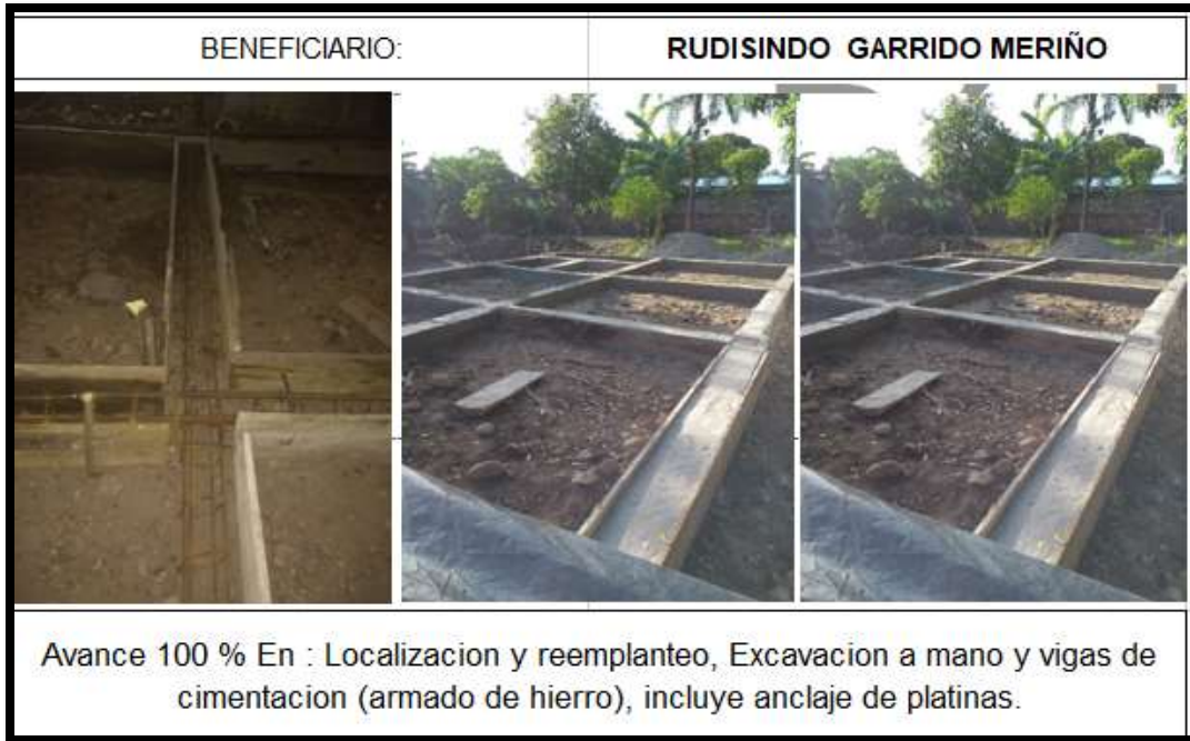
Ilustración 18. Registro fotográfico N°1 construcción de vivienda en Puerto Wilches, Santander.
