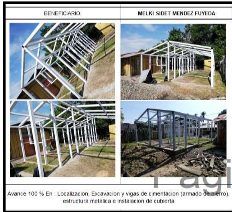
Ilustración 20. Registro fotográfico N°2 construcción de vivienda en Puerto Wilches, Santander.
