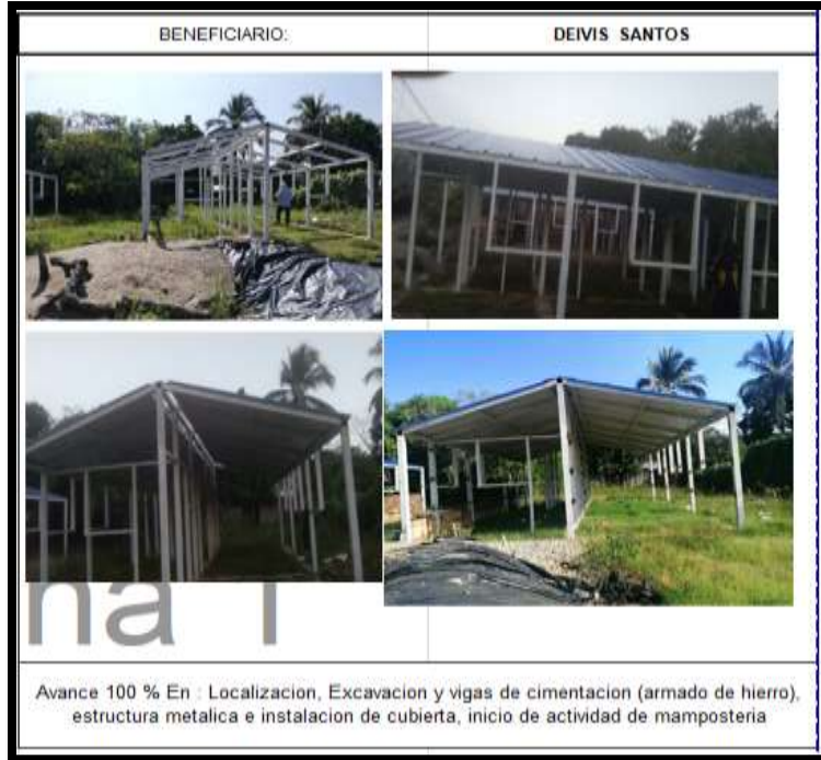
Ilustración 33. Registro fotográfico N°4 construcción de vivienda en Puerto Wilches, Santander
