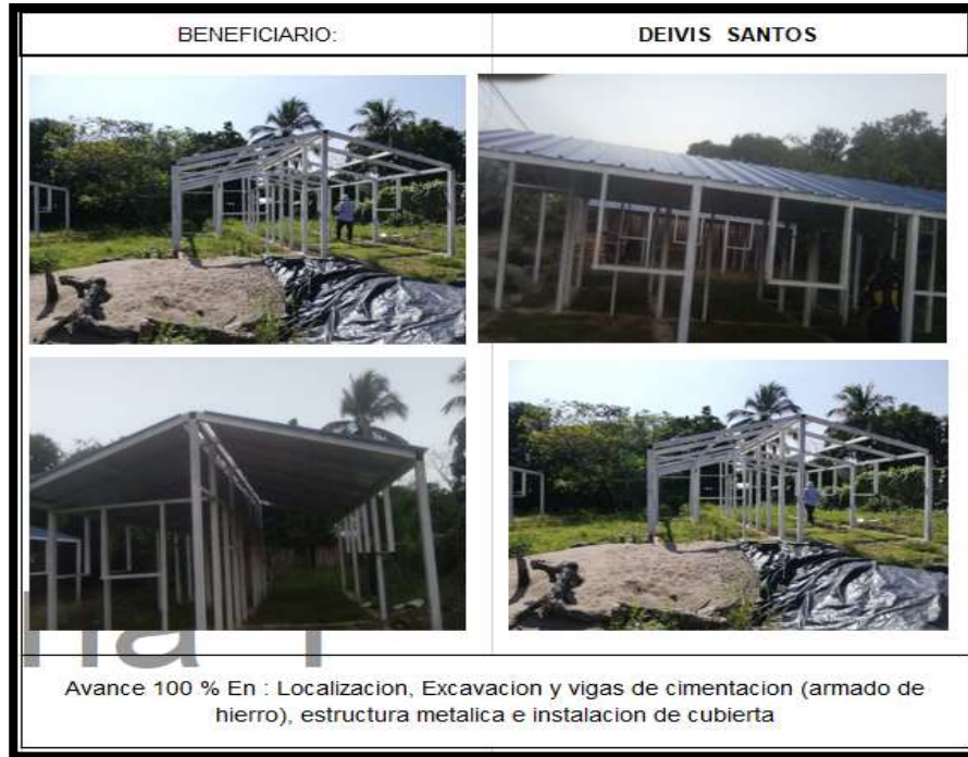
Ilustración 21. Registro fotográfico N°2 construcción de vivienda en Puerto Wilches, Santander.
