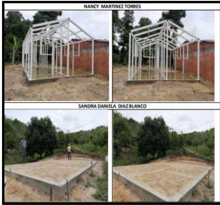
Ilustración 39. Registro fotográfico N°1 construcción de vivienda en Sabana de Torres, Santander.
