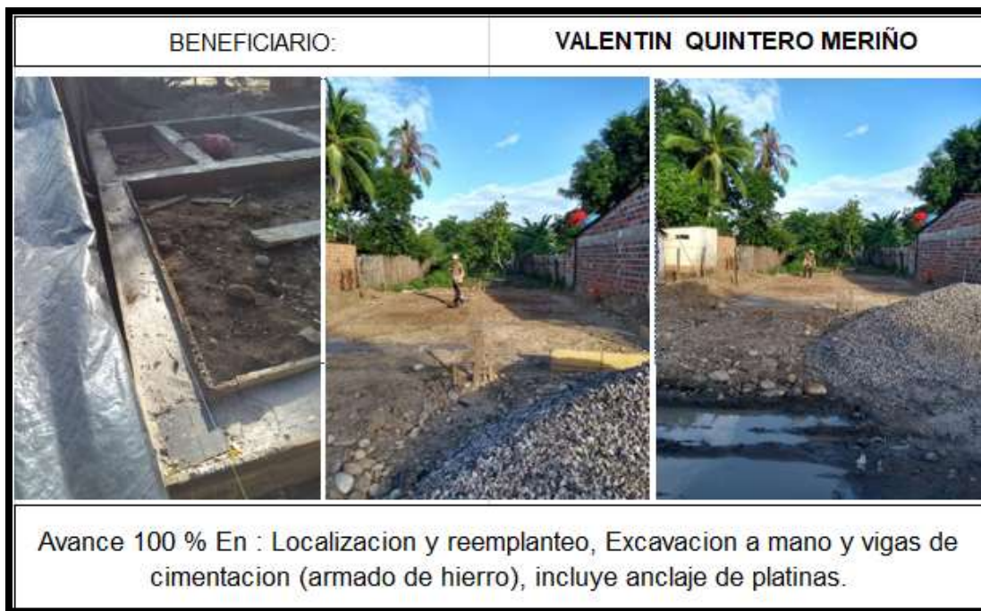
Ilustración 19. Registro fotográfico N°1 construcción de vivienda en Puerto Wilches, Santander.
