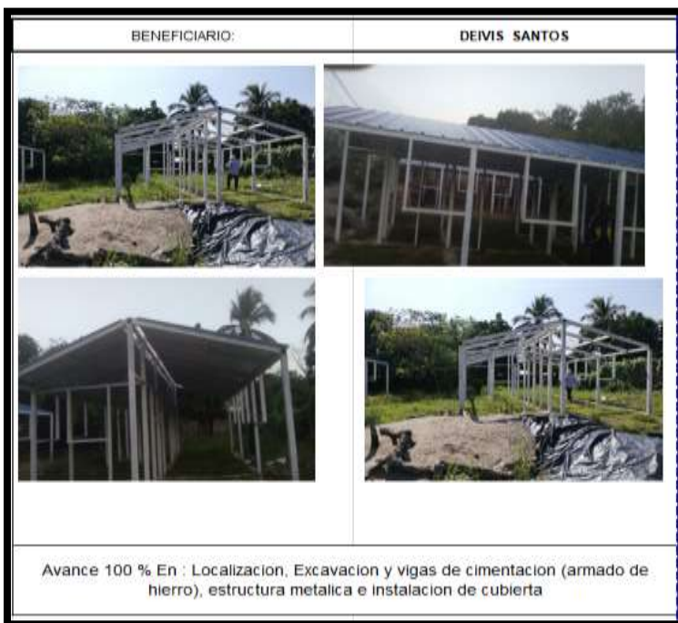
Ilustración 27. Registro fotográfico N°3 construcción de vivienda en Puerto Wilches, Santander
