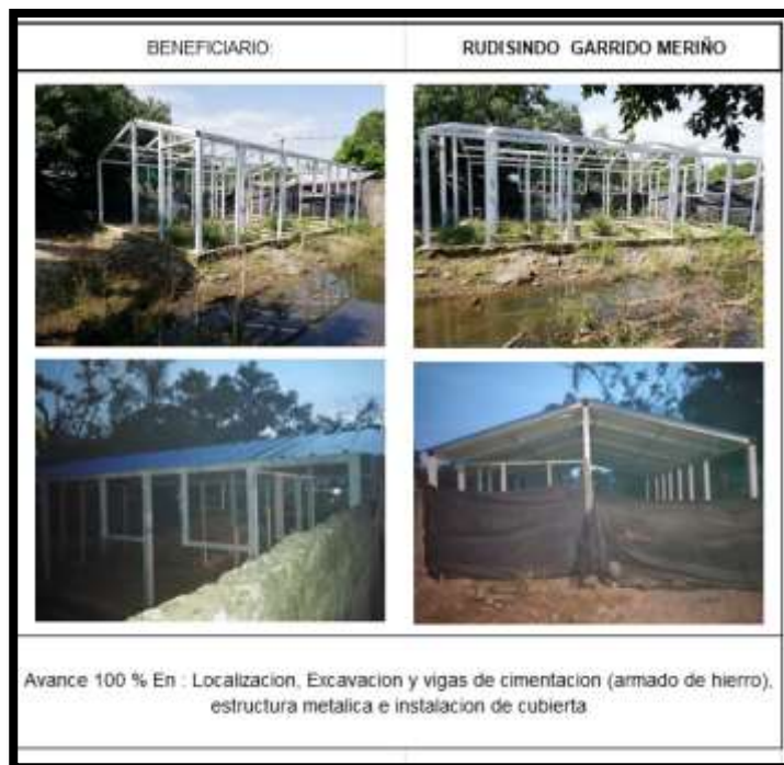
Ilustración 22. Registro fotográfico N°2 construcción de vivienda en Puerto Wilches, Santander.
