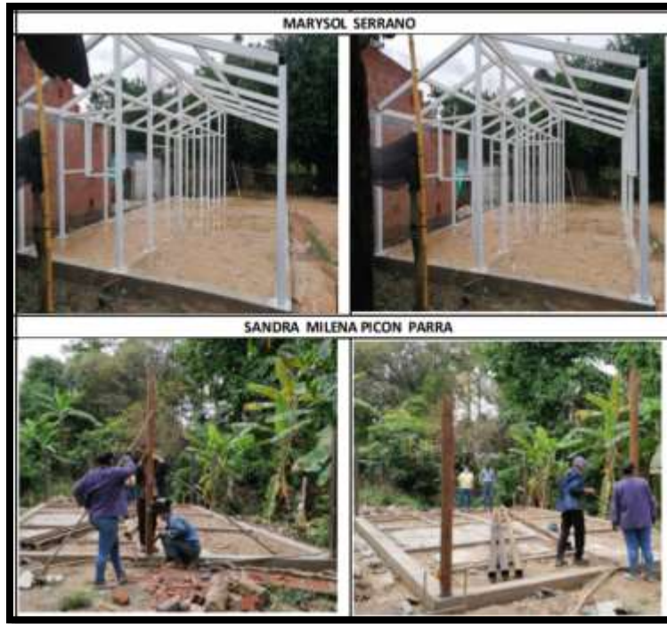
Ilustración 41. Registro fotográfico N°1 construcción de vivienda en Sabana de Torres, Santander.
