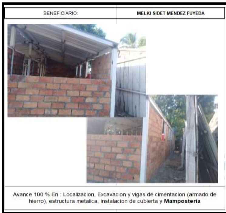
Ilustración 26. Registro fotográfico N°3 construcción de vivienda en Puerto Wilches, Santander
