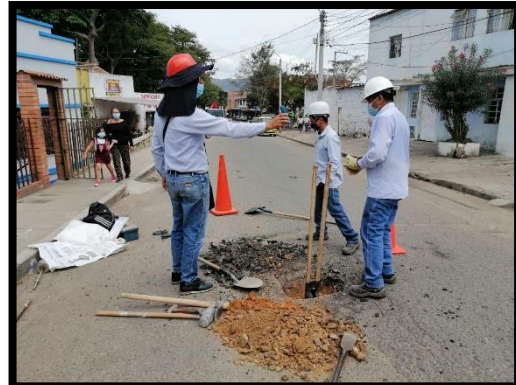
Ilustración 55. registro fotográfico en ejecución
