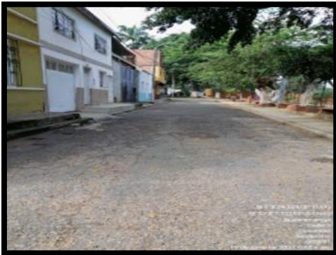
Ilustración 68. registro fotográfico de antes
