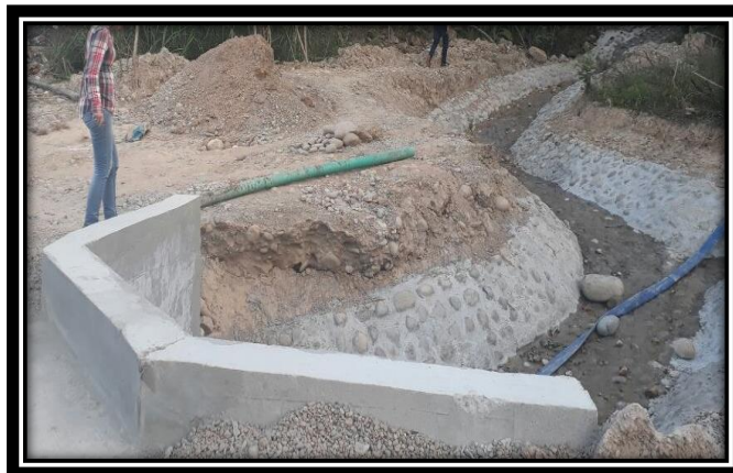
Imagen 1. Obra de Drenaje
