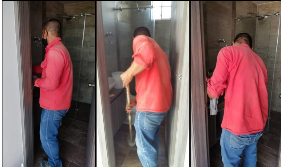
Ilustración 14. Limpieza de Baños – Carpintería Fuente: Autor
