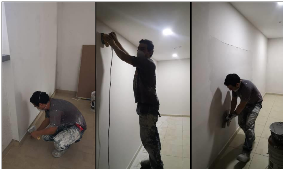
Ilustración 11. Terminación de Muros Fuente: Autor
