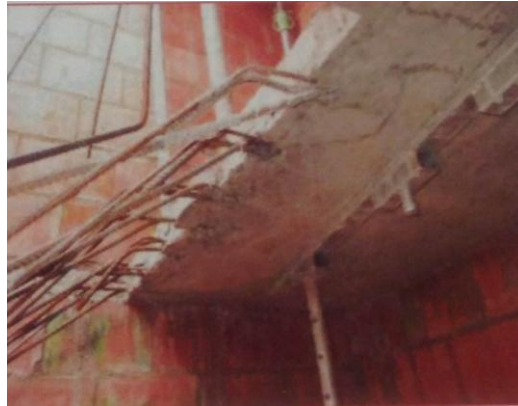
Figura 8. Armado de la placa y pasa tubos.
