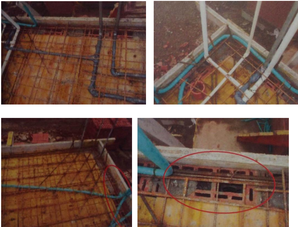
Figura 7. Armado de la placa
