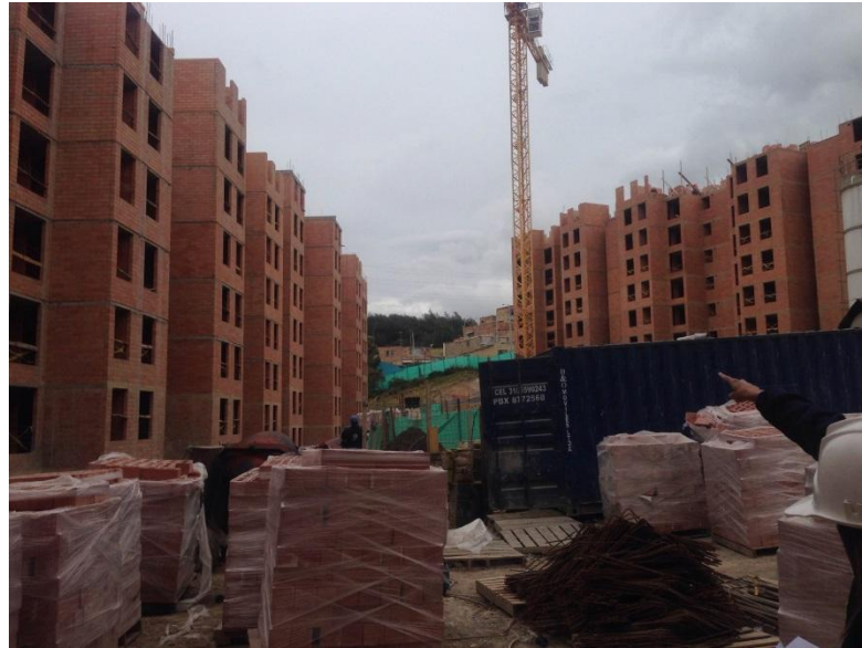
Figura 10. Suministro de materiales y su buena conservación ya que los apartamentos se entregan con mampostería a la vista.
