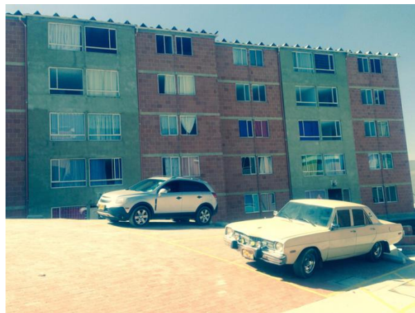
Figura 13. Proceso constructivo en mampostería estructural – proyecto Mirador del Parque.
