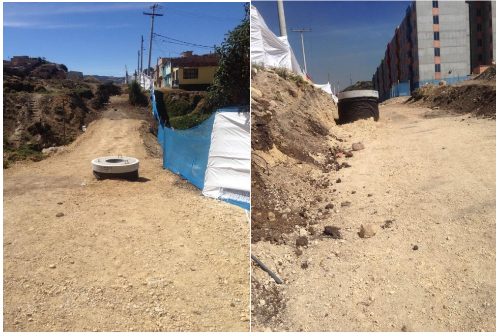
Figura 19. Vía de acceso principal proyecto Mirador del Parque.
