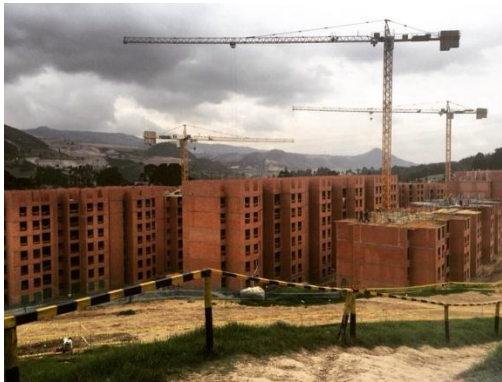
Figura 2. Proceso constructivo en mampostería estructural – proyecto Cantarrana.
