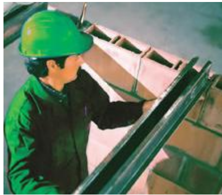
Figura 16. Instalacion de los perfiles metalicos apoyados en los muros minimo a 1.5cm y maximo a 2.5 cm.
