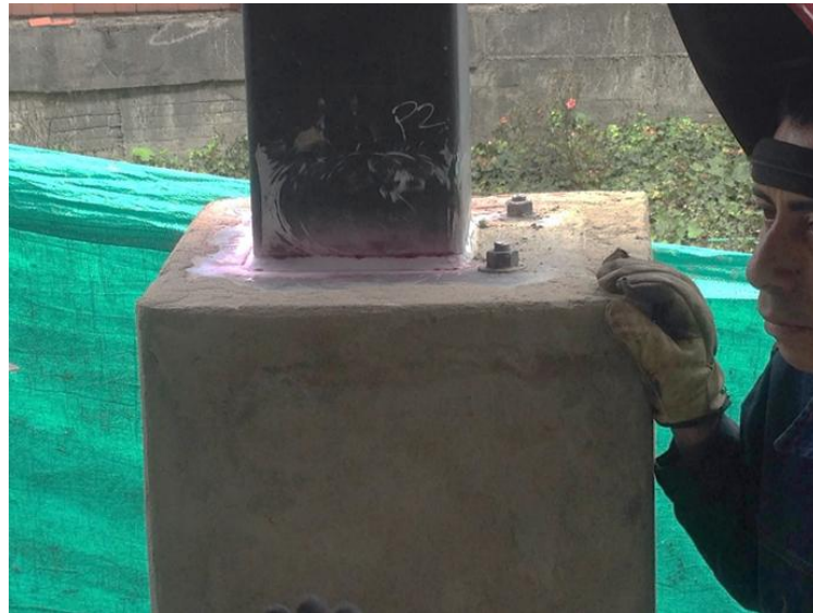
Figura 23. Método de tintas penetrantes para la inspección de soldadura para revelar la existencia de poros y fisuras.
