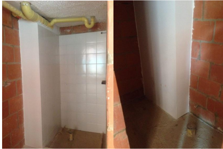
Figura 11. Baño principal con terminados y baño auxiliar sin acabados.
