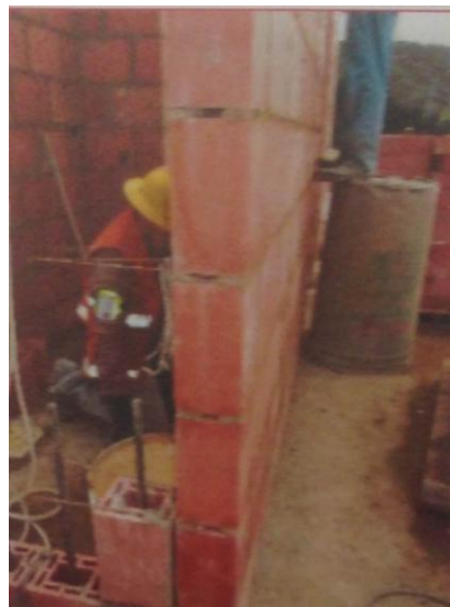
Figura 6. Construcción en mampostería
