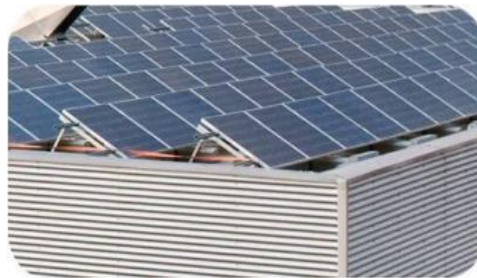
Figura 9. Paneles solares en cubierta de la fábrica de Solaria,
