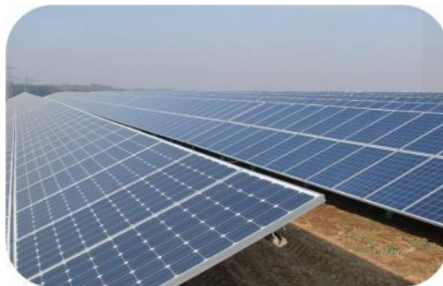
Figura 15. Instalación de paneles solares en suelo en Stalldorf, Alemania.
