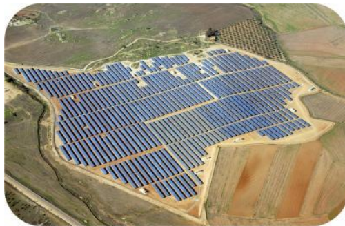
Figura 13. Instalación de paneles solares en suelo en Magacela, España.
