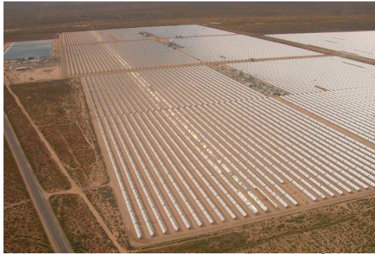
Figura 70. Sistemas de Generación de Energía Solar.
