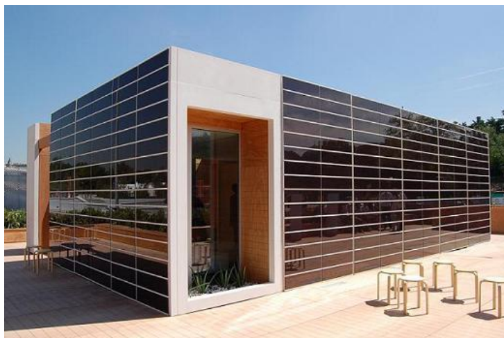
Imagen 42. Fachada con energía solar fotovoltaica.
