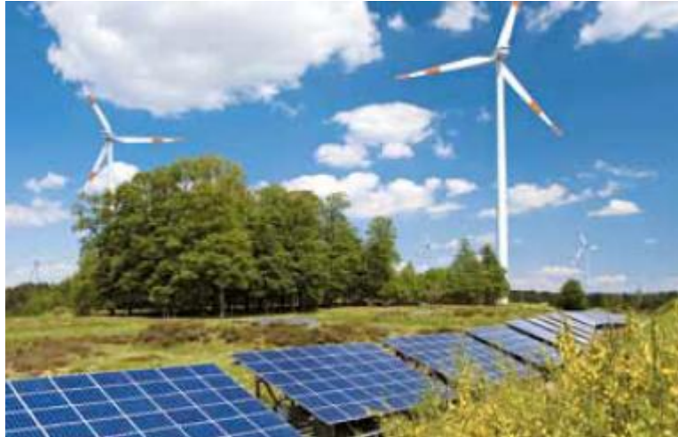
Figura 56. centro de energía renovable en morbach, Alemania.
