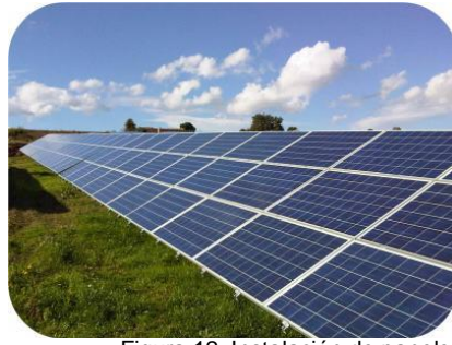
Figura 12. Instalación de paneles solares en suelo en ollastra, Italia.
