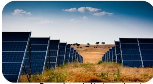
Figura 16. Instalación de paneles solares en suelo en Thale, Alemania.
