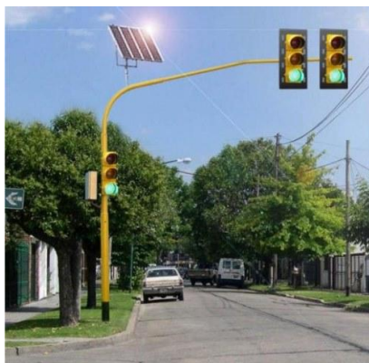
Figura 19. Proyecto de semáforo con energía renovable en Tuluá, Colombia.
