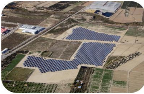
Figura 14. Instalación de paneles solares en suelo en Alhama de murcia, España.
