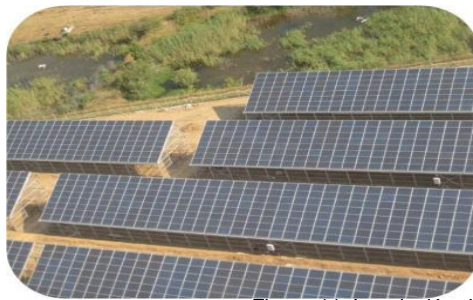
Figura 11. Instalación de paneles solares en UTA, Italia.
