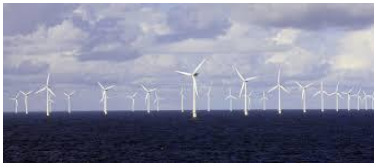
Figura 57. Parque eólico marino en Dinamarca.
