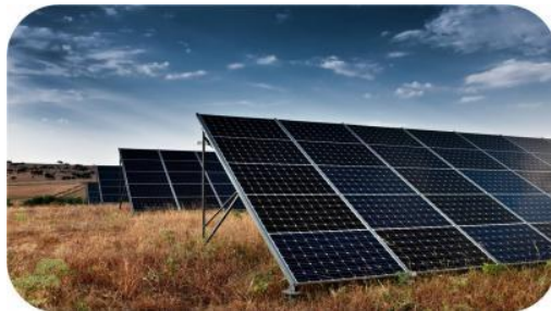
Figura 17. Instalación de paneles solares en suelo en Halle, Alemania.
