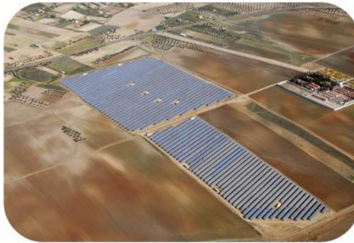
Figura 8. Instalación de paneles solares en Villanueva, España.
