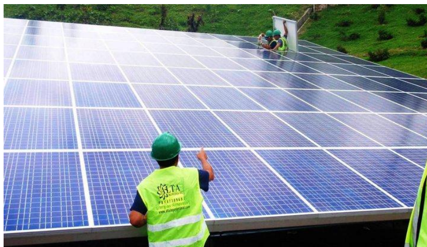
Figura 20. Instalación de paneles solares en la autopista del café, Colombia.
