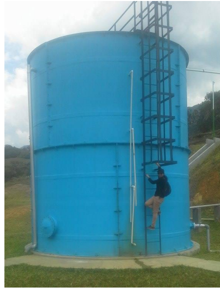
Fotografía 7. Inspección del UASB.
