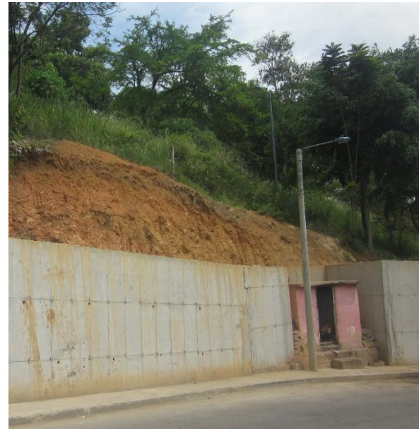
Fotografía 9. Muro de contención junto a la caseta antigua.
