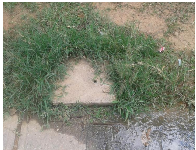
Fotografía 20. Filtros situados en la pared del talud.
