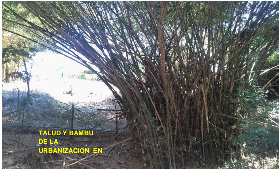
Fotografía 33. Talud y bambú en buen estado.
