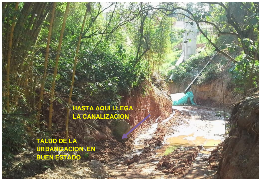
Fotografía 32. Obras de canalización.
