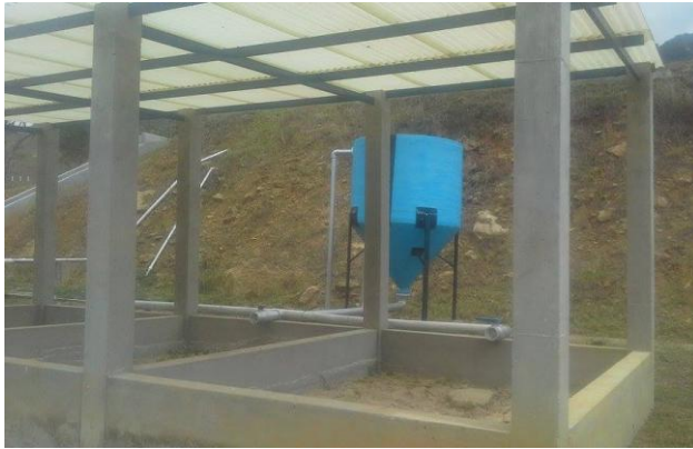
Fotografía 6. Secado de lodos.
