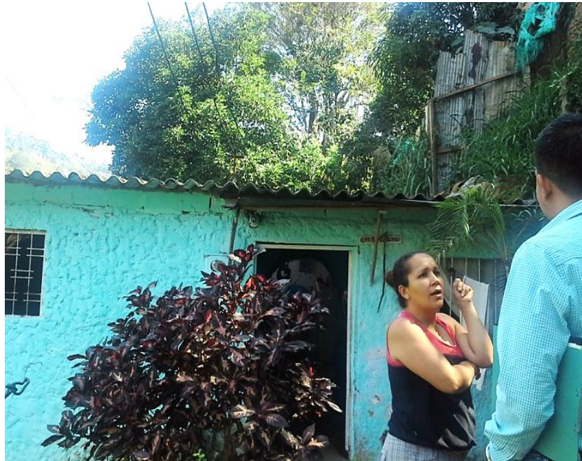
Fotografía 37. Vivienda Junto al talud.
