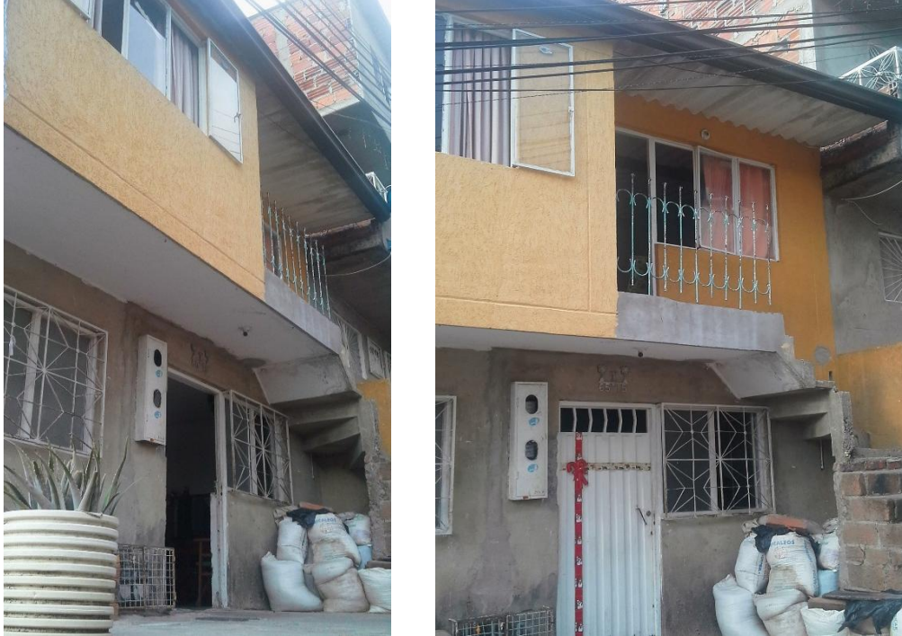
Fotografía 42. Vivienda de dos pisos ubicada en el Barrio Palmeras.
