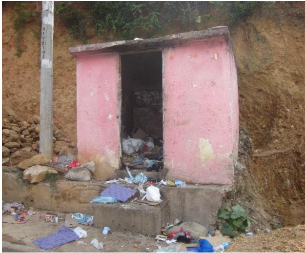
Fotografía 8. Anterior caseta de basuras
