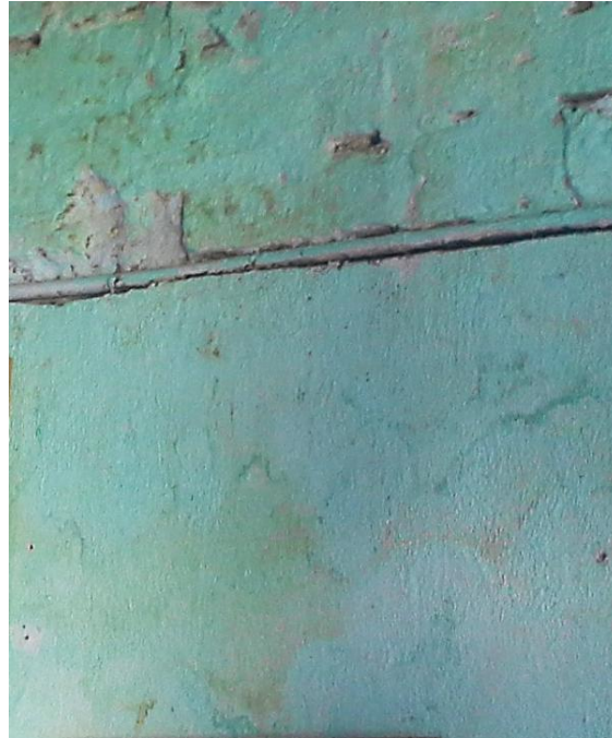
Fotografía 38. Humedad evidenciada.
