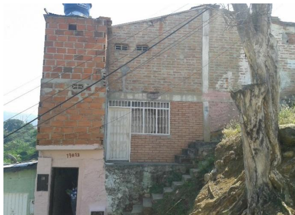
Fotografía 21. Casa ubicada en el talud.
