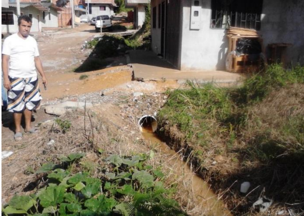
Fotografía 26. Se evidencia la falta de alcantarillado.
