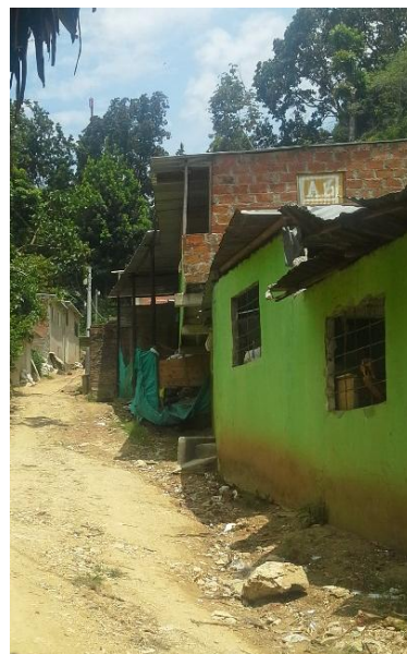
Fotografía 3. Marcación del agua en paredes
