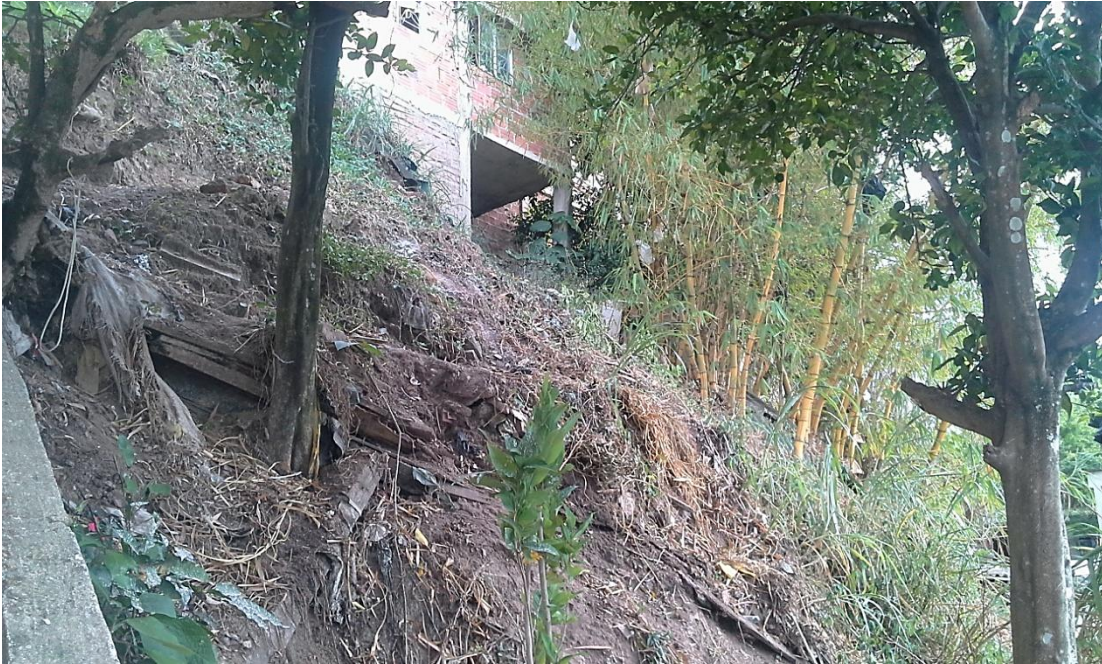
Fotografía 36. Lote y vivienda en la parte superior del talud.
