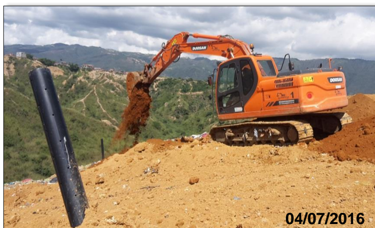
Imagen 6 Cobertura de residuos
