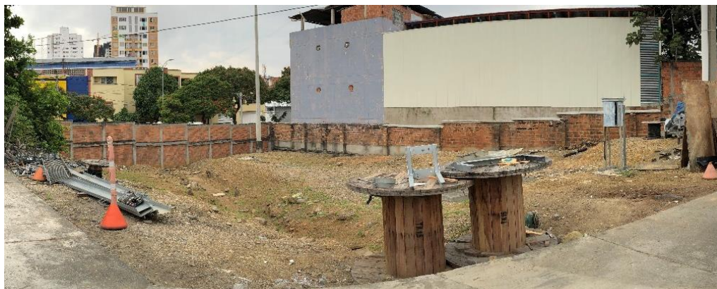
Figura 38. Zona de adecuación de parqueadero.
