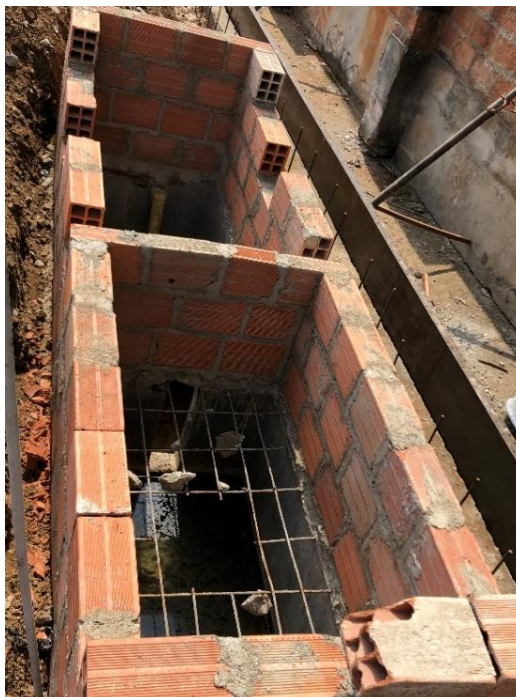
Figura 41. Cerramiento en mampostería para fuente de agua natural.
