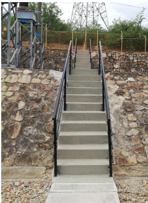
Figura 25. Escaleras con barandas Subestación Palos.
