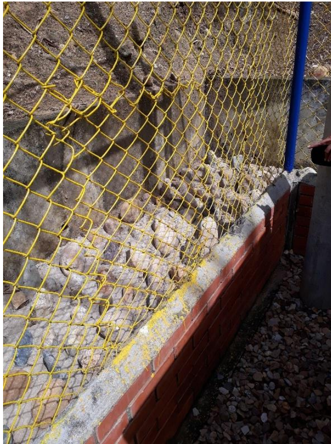
Figura 16. Malla reparada de subestación hamacas.
