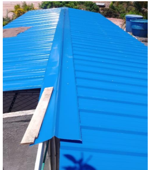
Figura 9. Instalación de cubierta y cumbrera
