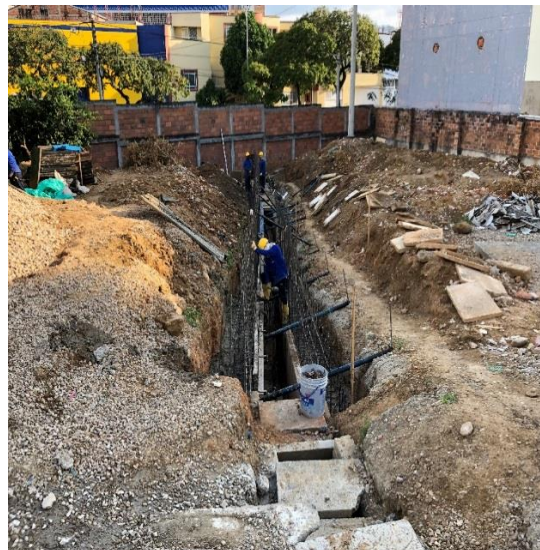
Figura 40. Colocación de acero de refuerzo para cárcamo.
