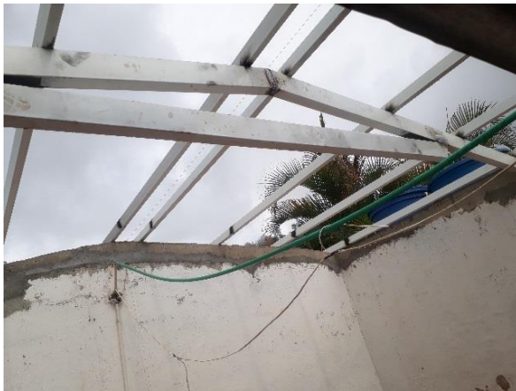
Figura 8. Cercha cubierta nueva
