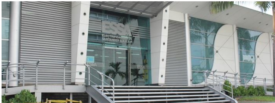
Figura 3. Sede Principal de la Electrificadora de Santander S.A. E.S.P.
