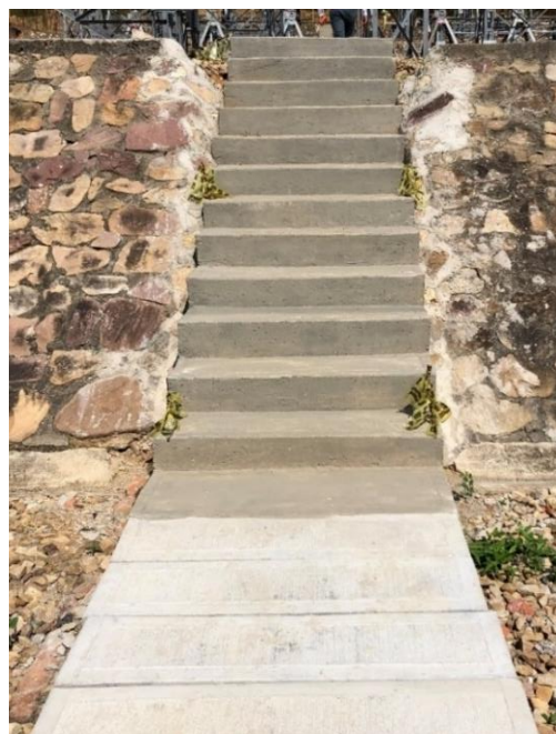
Figura 24. Escaleras Subestación Palos. Fuente: Autor
