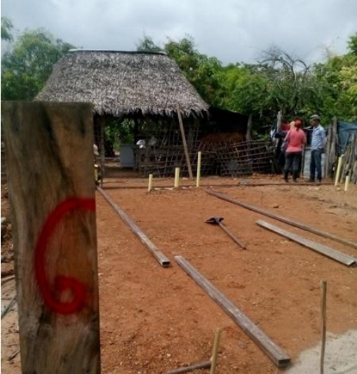
Figura 31. Terreno compactado listo para fundir solado.
