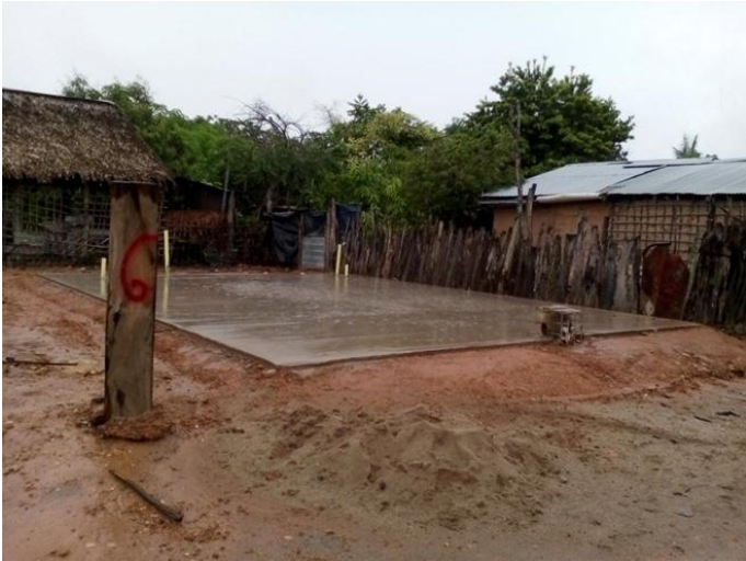
Figura 34. Placa fundida, en espera de secado para colocación de paneles.
