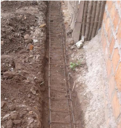
Figura 28. Armado de vigas para cimentación de patio.
