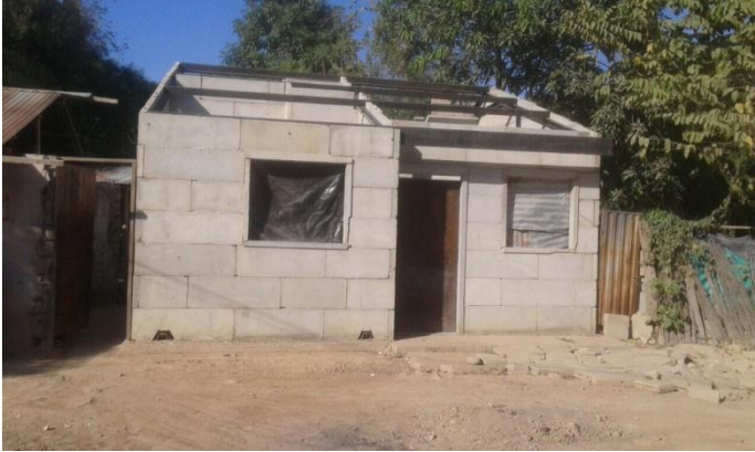
Figura 39. Perfiles y tejas instalados en vivienda.
