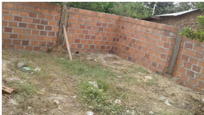
Figura 43. Cerramiento de patio en predio.
