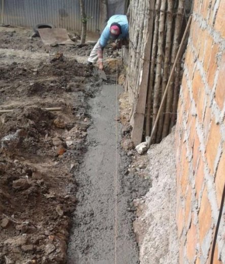
Figura 31. Terreno compactado listo para fundir solado.
