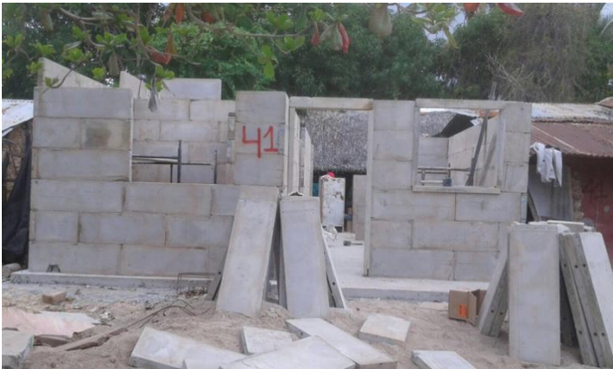
Figura 36. Vivienda en proceso de armado.
