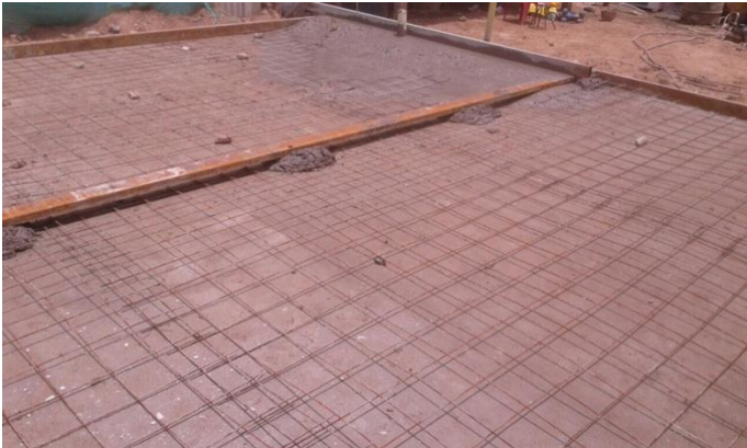
Figura 33. Proceso de nivelación de placa base.
