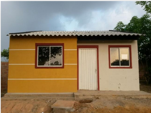
Figura 87. Reconstrucción de viviendas en sitio propio afectadas por ola invernal.
