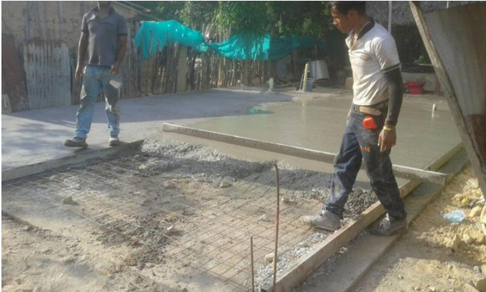
Figura 34. Placa fundida, en espera de secado para colocación de paneles.
