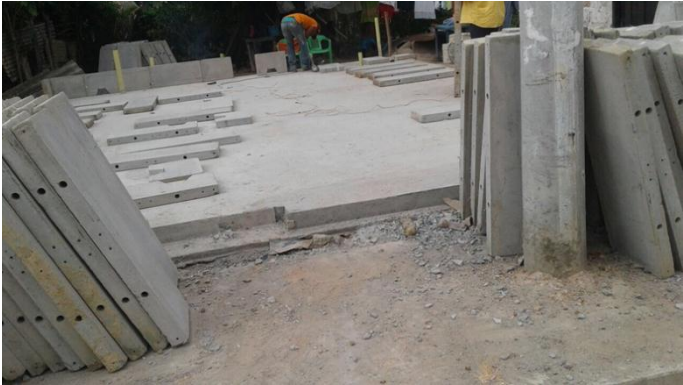
Figura 35. Paneles listos para inicio de armado de vivienda.
