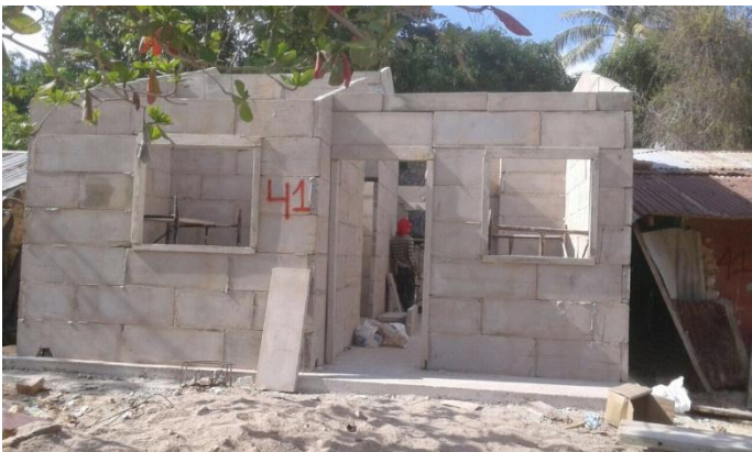
Figura 37. Vivienda armada, lista para colocación de perfiles de cubierta.
