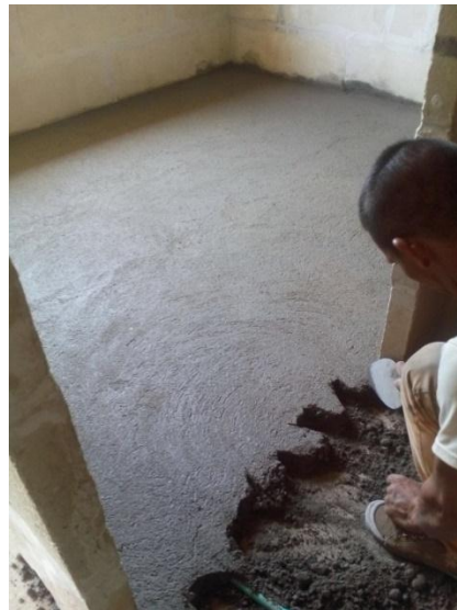
Figura 42. Proceso de emplantillar la vivienda para colocación de piso.
