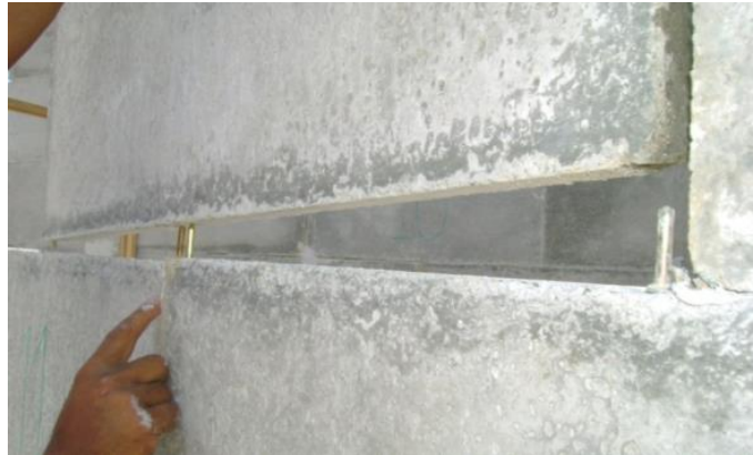
Figura 98. Forma de ensamble de los paneles.
