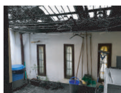
Muro ladrillo revocado y pintado
