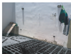
Muro ladrillo revocado y pintado
