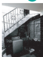
Muro ladrillo revocado y pintado
