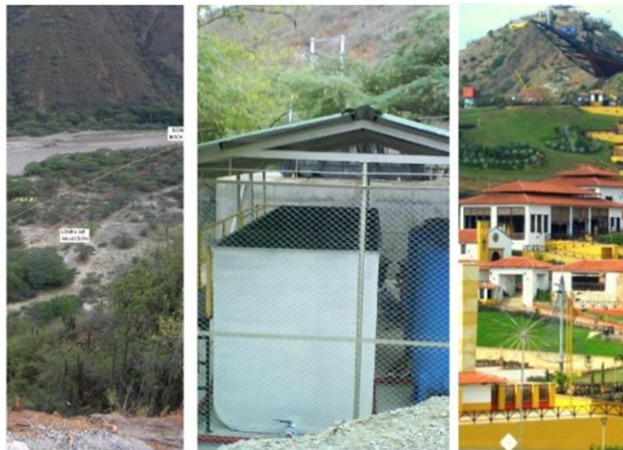
Imagen 1. Acueducto Panachi Fase I
