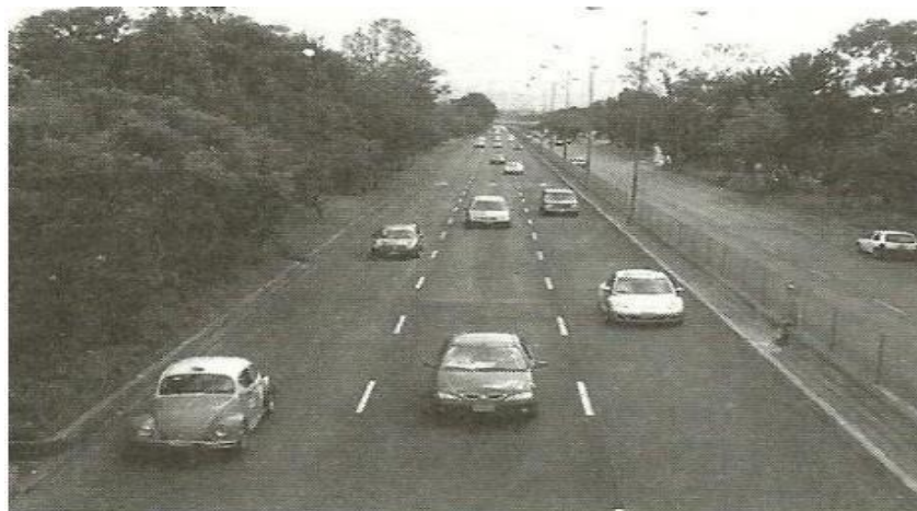
Figura 11. Nivel de servicio C
