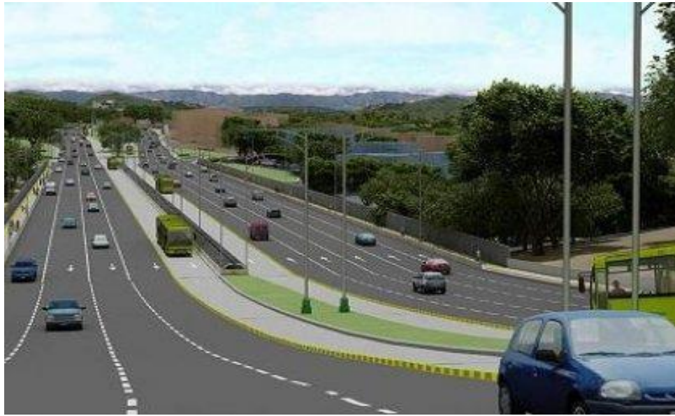
Figura 6. Tercer carril entre el puente de Provenza y la Puerta del Sol Fuente: http://www.rcnradio.com/noticias/se-podrian-perder-recursos-adjudicados-para-el-tercer-carril-en-bucaramanga-101583
