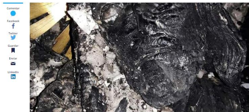
Así quedó la imagen de Jesús Nazareno después del incendio de esta madrugada. Foto: Suministrada
