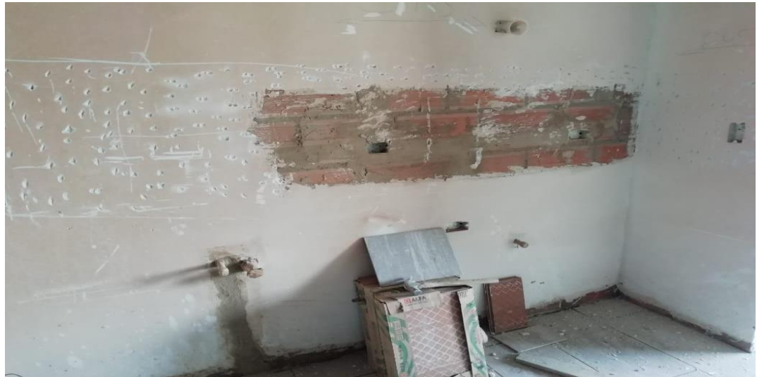
Figura 14. Pared de cocina sin enchape
