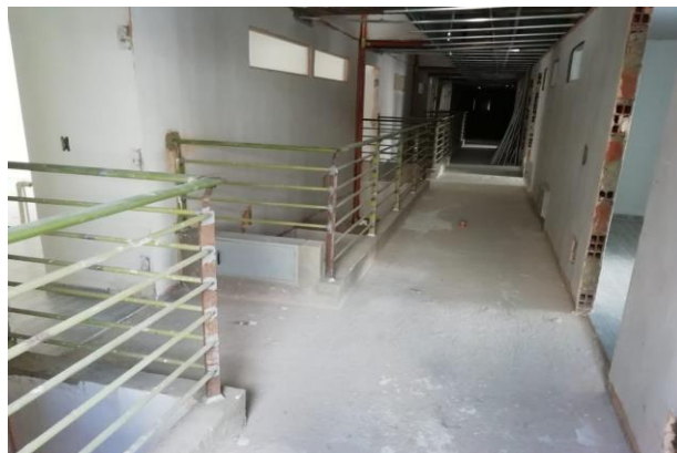
Figura 7. Barandas de pasillo de apartamentos
