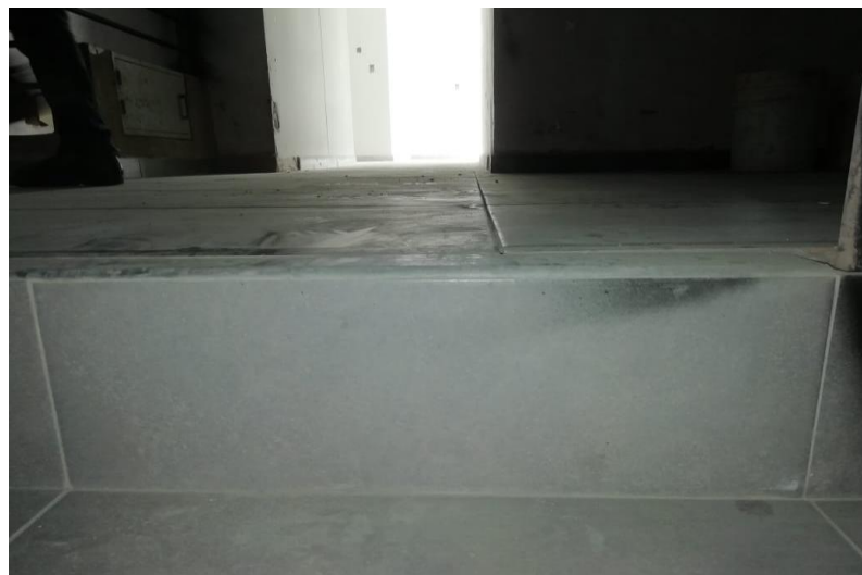
Figura 18. Tropezos entre losas de enchape
