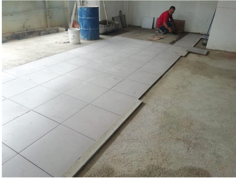
Figura 24. Instalación de enchape de piso "local comercial"
