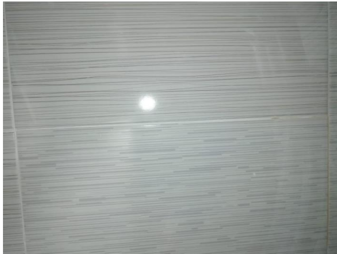
Figura 22. Losas de enchape de diferente diseño
