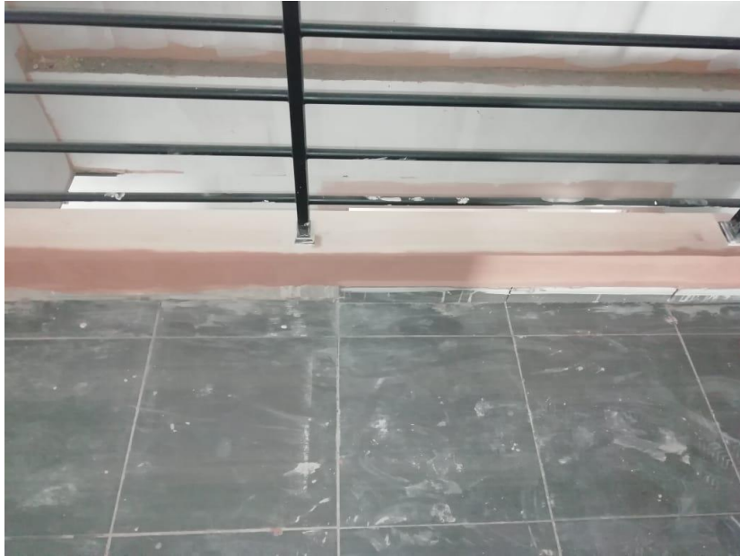
Figura 20. Secciones sin zócalos
