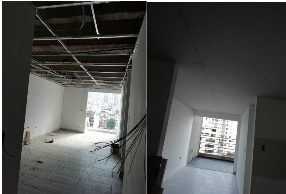
Figura 12. Instalación de láminas de Drywall en apartamentos
