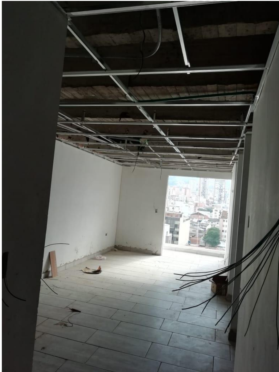
Figura 19. Juntas de enchape de cerámica sin brecha
