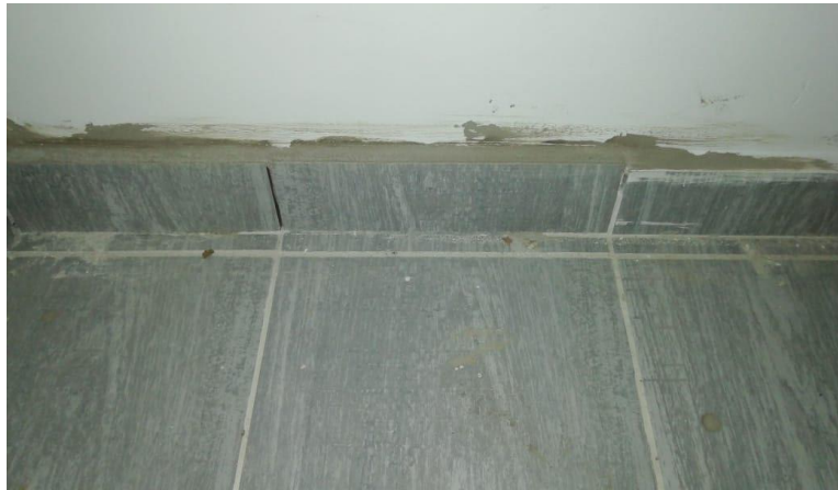
Figura 27. Secciones de dilataciones sin boquilla
