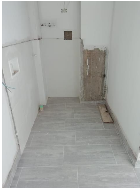
Figura 23. Instalación de enchape con todos los requerimientos
