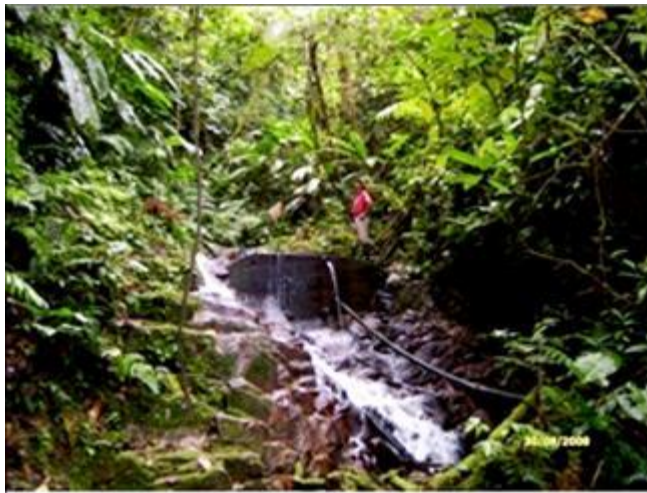
Foto 2. Tanque de distribución de agua potable
