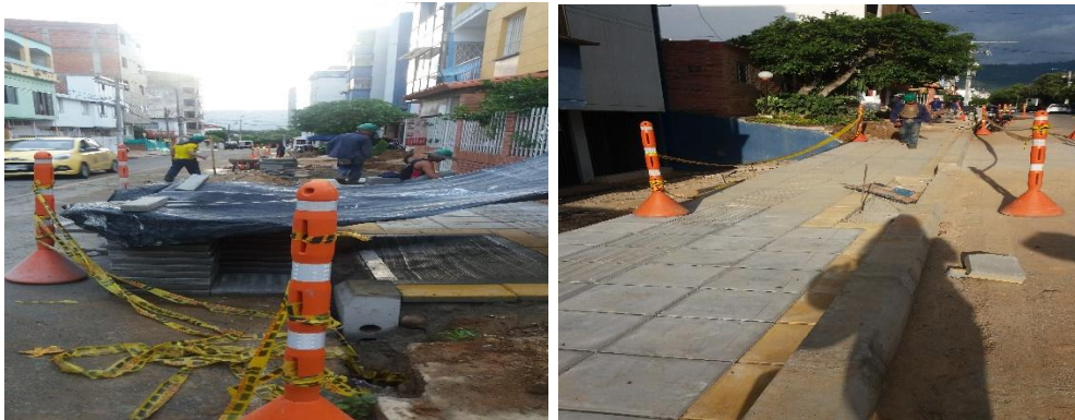
Fig. 78 Losetas, San miguel Fuente: autor
