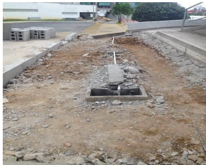
Fig. 40 Instalación sardinel, Mejoras públicas Fuente: autor
