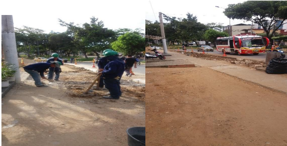
Fig. 63 Demolición de andén, Provenza -2 Fuente: autor
