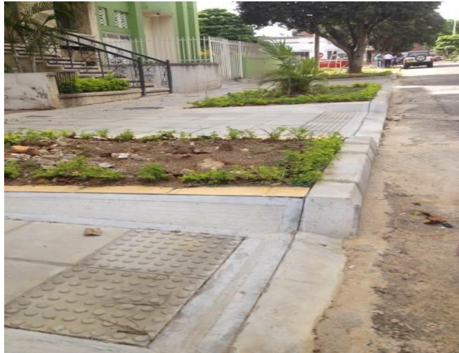
Fig. 27 Instalación de sardinel, Prado Fuente: autor
