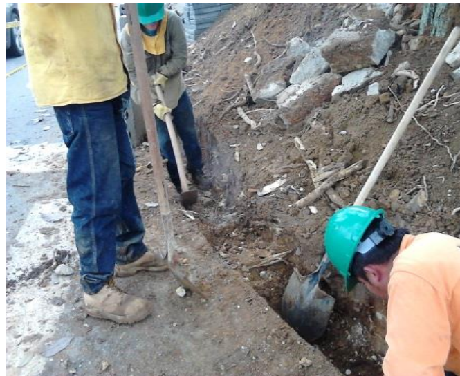
Fig. 24 Demolición de sardinel, Prado Fuente: autor
