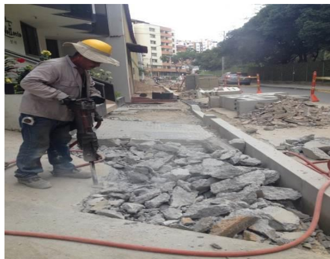
Fig. 36 Demolición de andén, Mejoras publicas Fuente: autor
