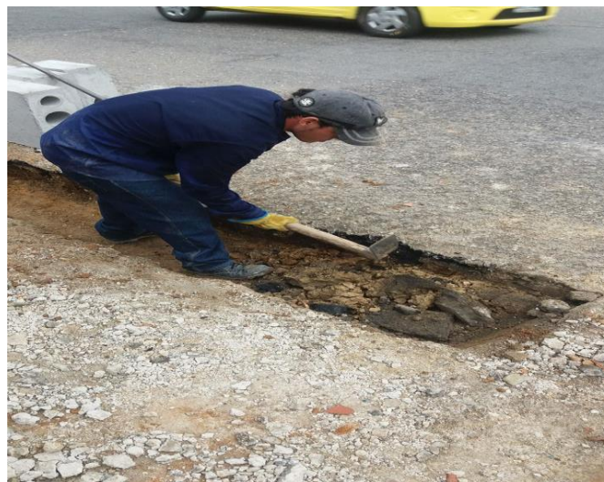
Fig.52 Excavación manual, Provenza-1 Fuente: autor
