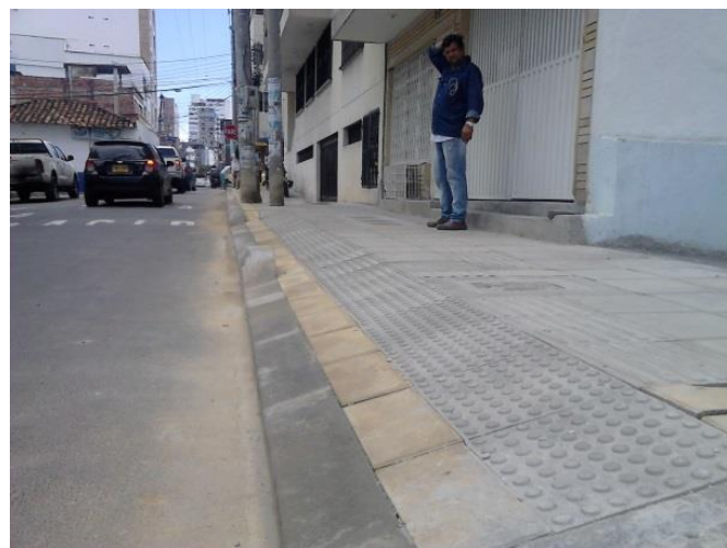
Fig. 16 Losetas instaladas, Alarcón Fuente: autor
