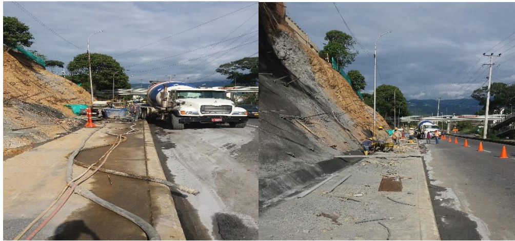
Fig.85 Suministro y colocación de concreto Fuente: autor
