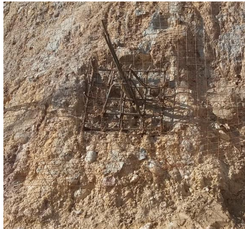
Fig. 86 Suministro y colocación de acero Fuente: autor
