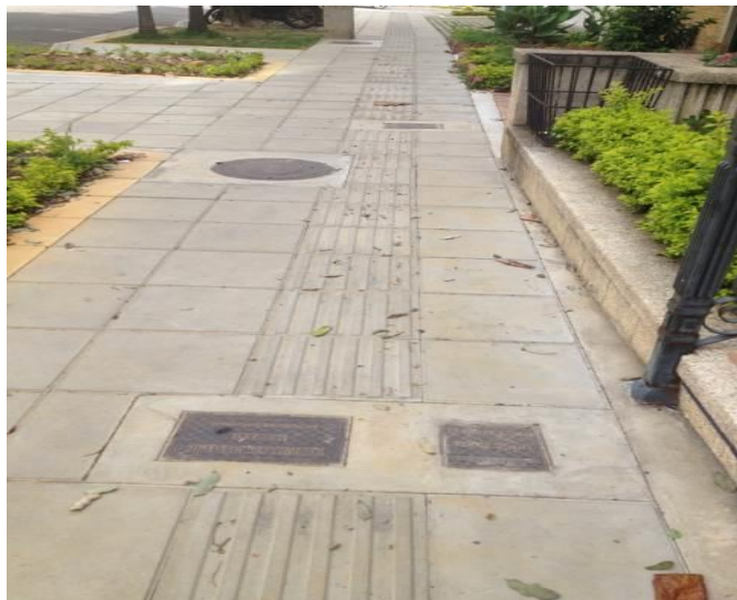
Fig. 30 Realce de cajas, Prado Fuente: autor
