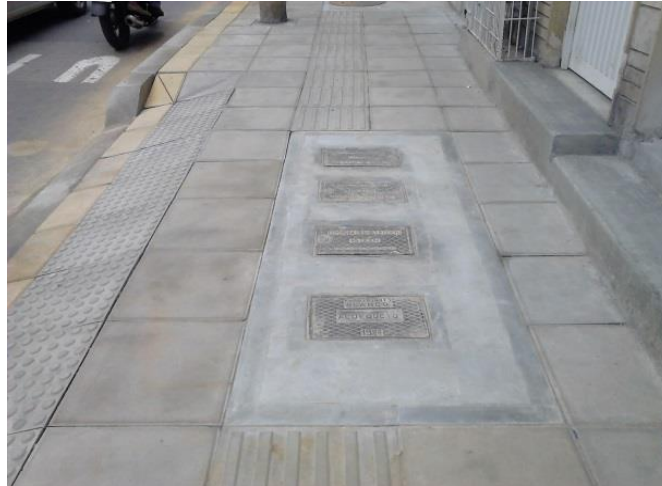
Fig. 17 Realce de cajas, Alarcón Fuente: autor
