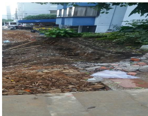
Fig. 74 Demolición de andén, San miguel Fuente: autor
