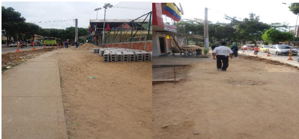
Fig. 66 Instalación de sardinel, Provenza-2 Fuente: autor
