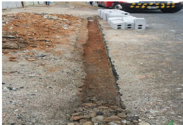
Fig.51 Demolición de sardinel, Provenza-1 Fuente: autor
