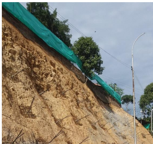
Fig. 84 Excavación Fuente: autor
