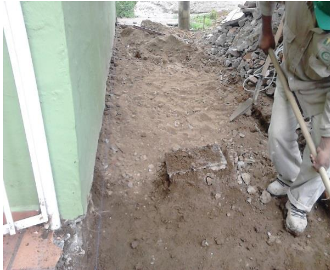
Fig. 25 Excavación manual, Prado Fuente: autor
