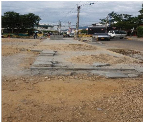
Fig. 67 Base granular, Provenza-2 Fuente: autor
