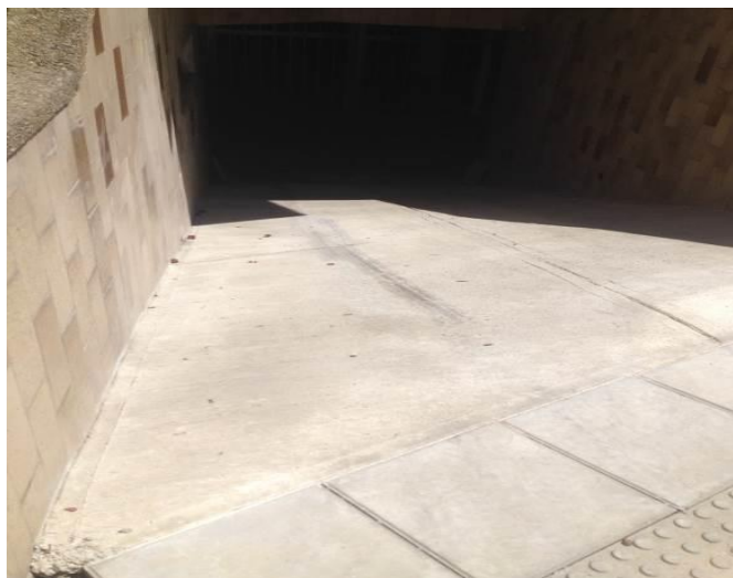
Fig. 45 Mampostería y friso liso, Mejoras públicas Fuente: autor
