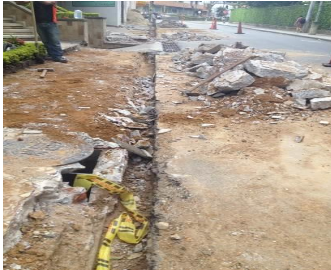
Fig. 37 Demolición de sardinel, Mejoras publicas Fuente: autor
