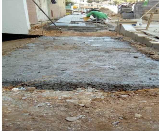
Fig. 41 Antepiso concreto, Mejoras públicas Fuente: autor
