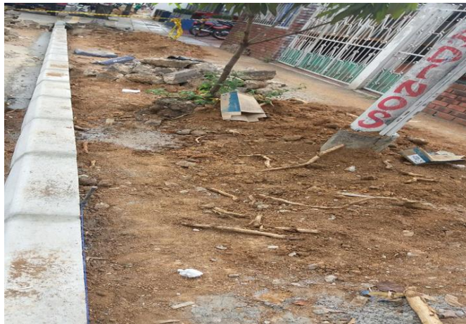
Fig.53 Base granular, Provenza-1 Fuente: autor
