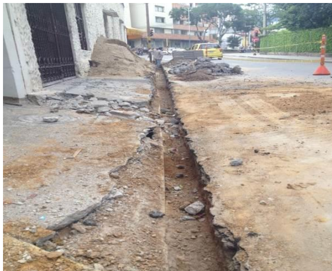
Fig. 38 Excavación manual, Mejoras publicas Fuente: autor
