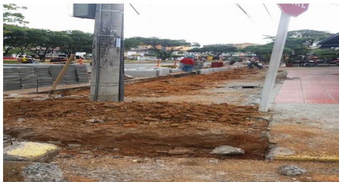
Fig.54 Instalación de sardinel, Provenza-1 Fuente: autor
