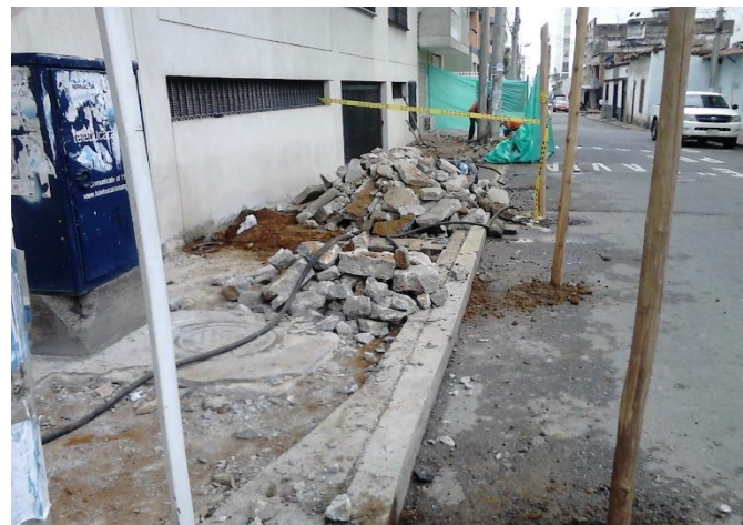
Fig. 10 Demolición de andén, Alarcón Fuente: autor
