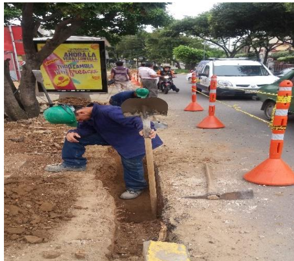
Fig. 64 Demolición de sardinel, Provenza -2 Fuente: autor
