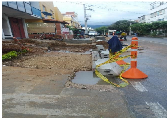
Fig.75 Excavación, San miguel Fuente: autor
