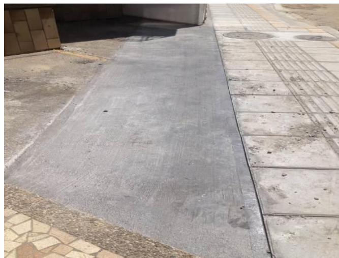
Fig. 42 Losetas instaladas, Mejoras públicas Fuente: autor
