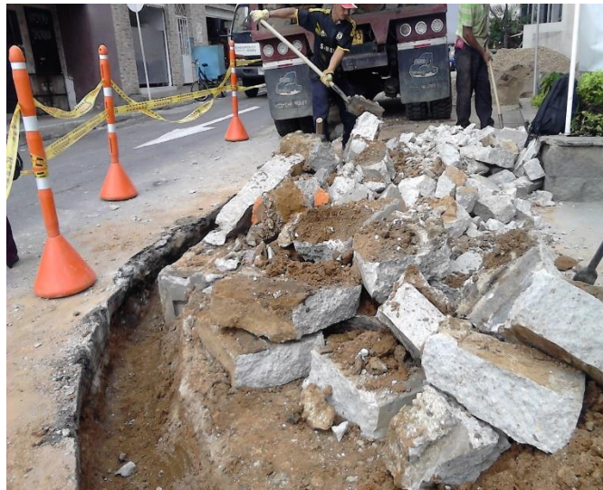
Fig. 12 Excavación manual, Alarcón Fuente: autor
