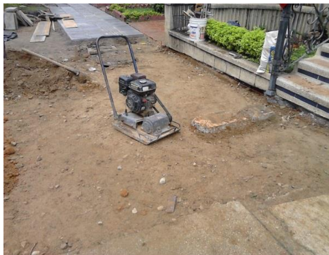
Fig. 26 Base granular, Prado Fuente: autor
