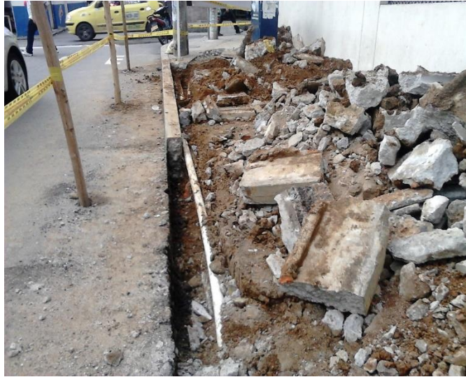
Fig. 11 Demolición sardinel, Alarcón Fuente: autor
