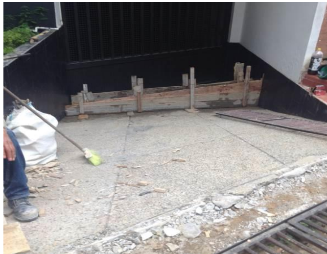
Fig. 44 Rampas vehiculares, Mejoras públicas Fuente: autor
