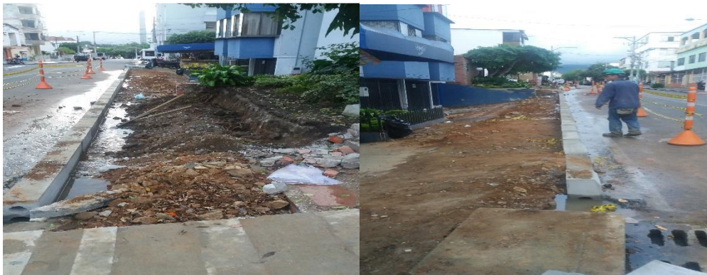
Fig. 76 Instalación de sardinel, San miguel Fuente: autor
