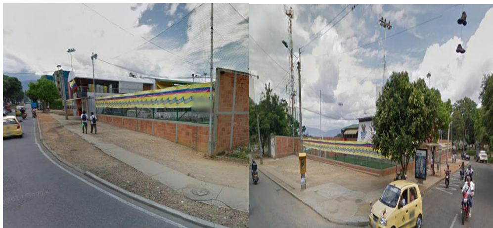
Fig. 62 Localización y replanteo, Provenza -2 Fuente: google maps
