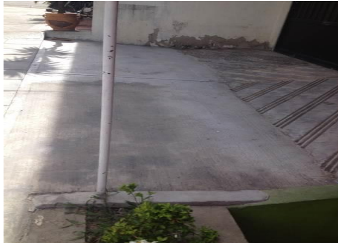
Fig. 15 Antepiso concreto, Alarcón Fuente: autor
