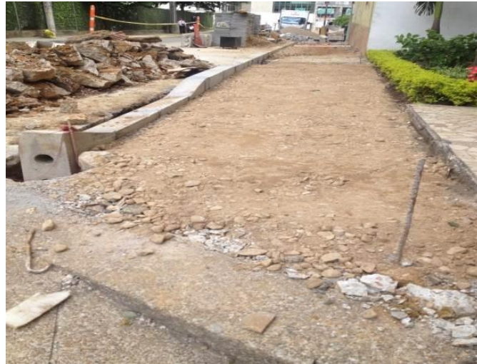
Fig. 39 Base granular, Mejoras públicas Fuente: autor
