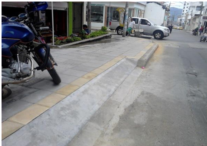
Fig. 14 Instalación de sardinel, Alarcón Fuente: autor
