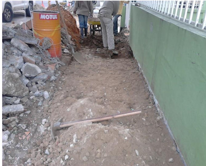
Fig. 23 Demolición de andén, Prado Fuente: autor
