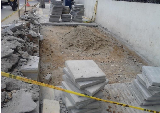
Fig. 13 Base Granular, Alarcón Fuente: autor
