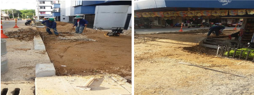
Fig. 77 Base granular, San miguel Fuente: autor
