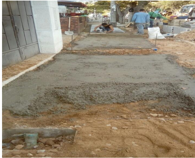
Fig. 55 Antepiso concreto, Provenza-1 Fuente: autor
