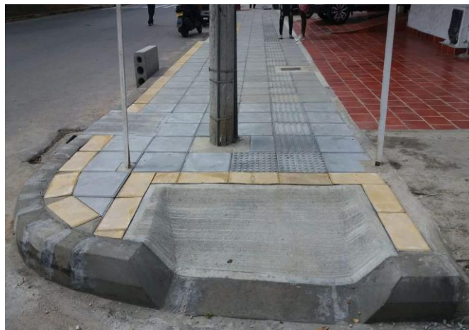
Fig. 56 Losetas instaladas, Provenza-1 Fuente: autor
