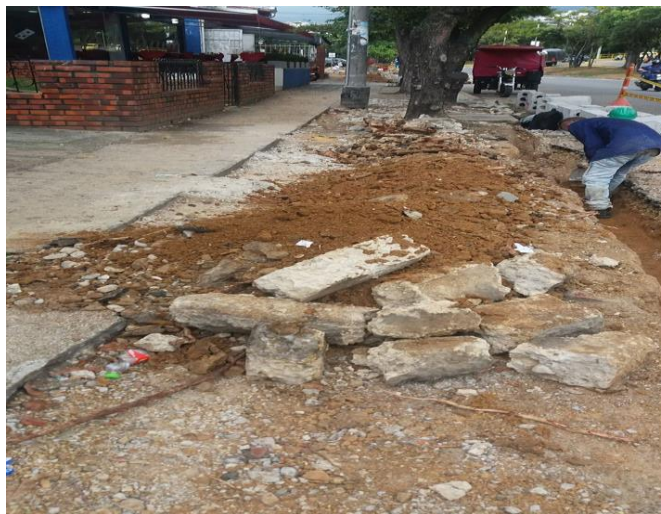
Fig.50 Demolición de andén, Provenza-1 Fuente: autor
