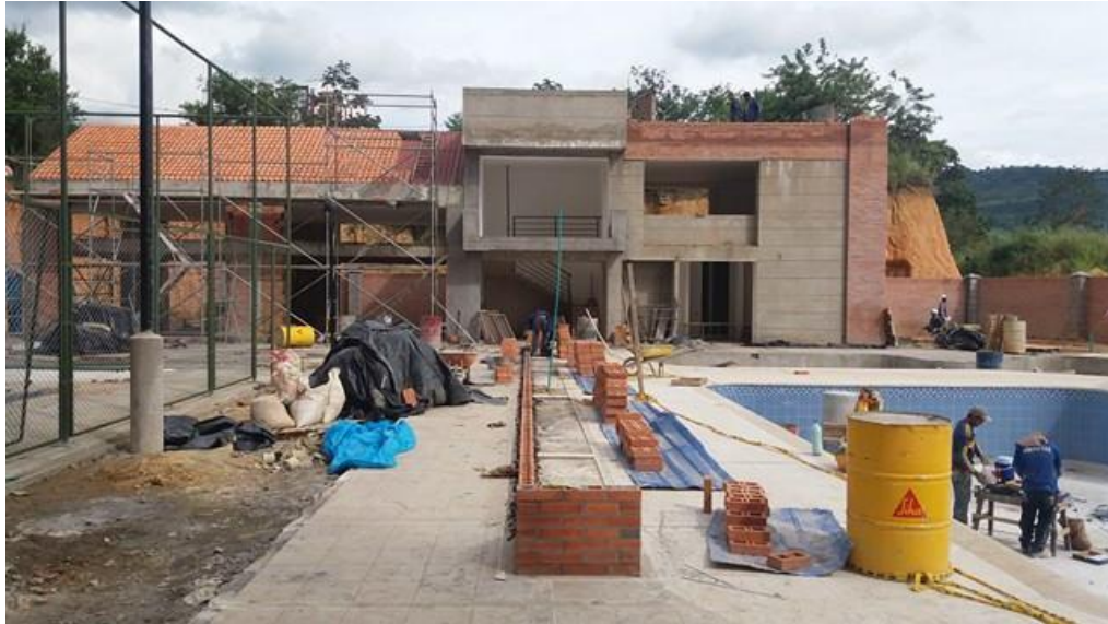
Imagen 4. Adecuación Zonas Comunes.
