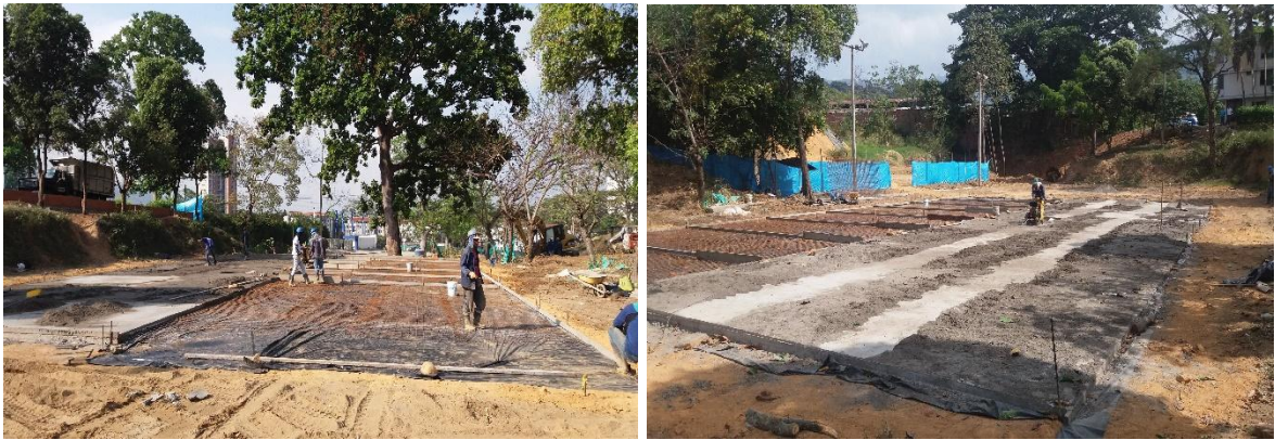
Imagen 25. Actividad Fundida Placa Cancha Sintética segundo día - Dilataciones Placa.
