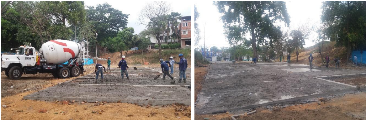
Imagen 26. Actividad Fundida placa cancha sintética Tercer y cuarto día - Impermeabilización de placas.
