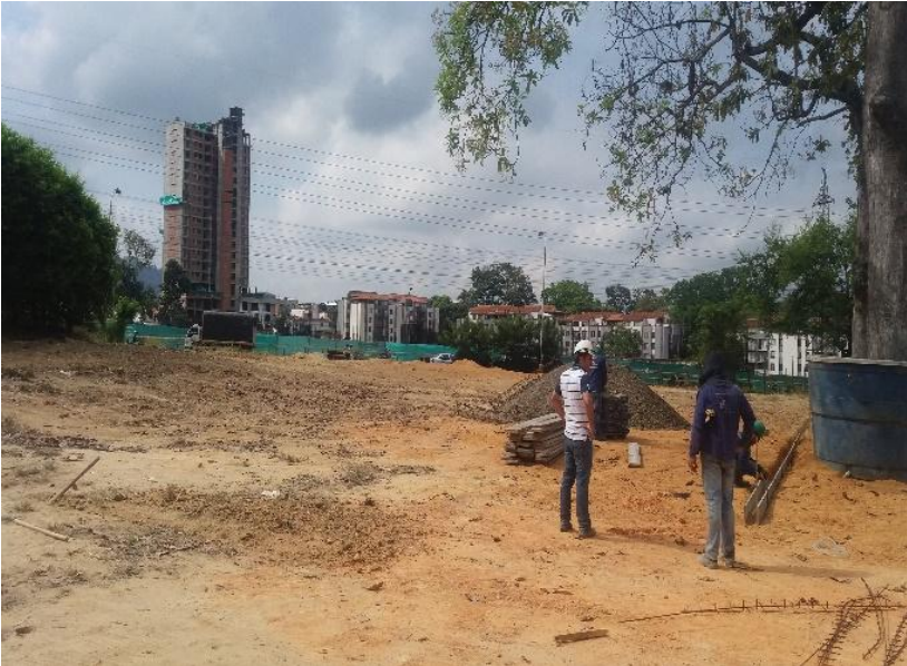
Imagen 9. Conformación de Terrero Sala de Ventas Belfort.
