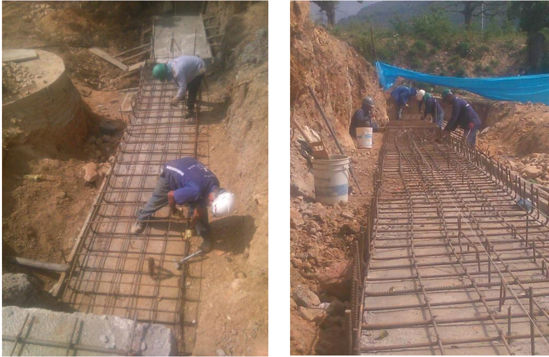
Imagen 29. Actividad Armado de Hierro Zarpa Muro de Contención.
