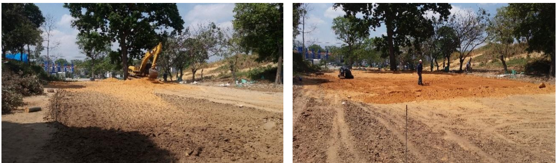
Imagen 19. Actividad Replanteo Cancha Sintética – Conformación del Terreno.
