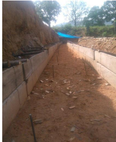
Imagen 28. Actividad Armado de Formaleta para Ciclópeo.
