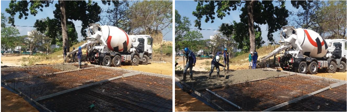
Imagen 22. Actividad Primer día de Fundida Placa Cancha Sintética.
