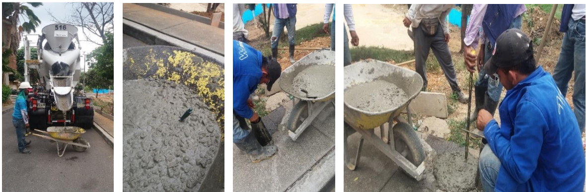
Imagen 15. Actividad Fundida de Viga de Cimentación Cerramiento.
