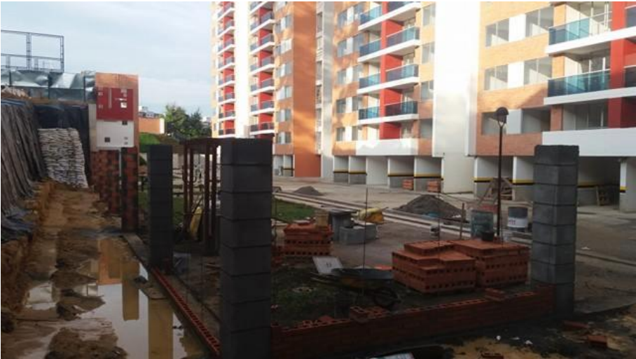
Imagen 7. Cerramiento Zona BQQ
