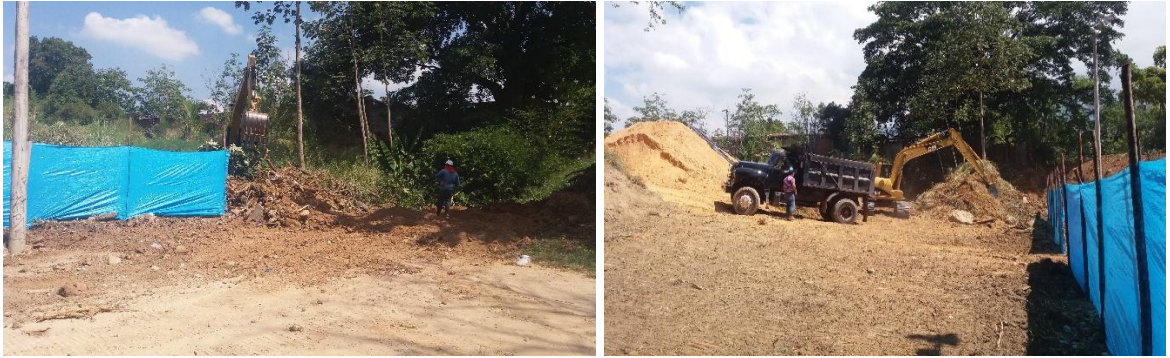
Imagen 18. Actividad Retiro de Escombros.
