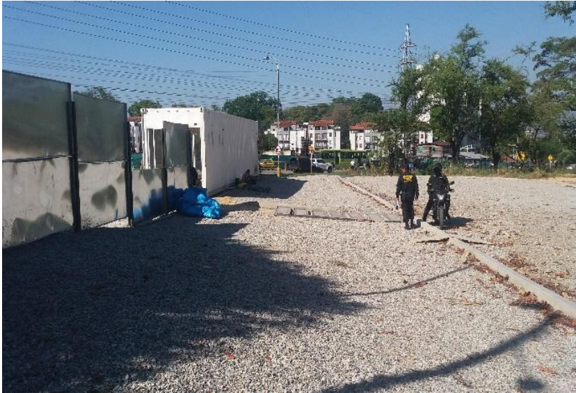
Imagen 11. Adecuación de Container para Sala de Ventas Belfort.
