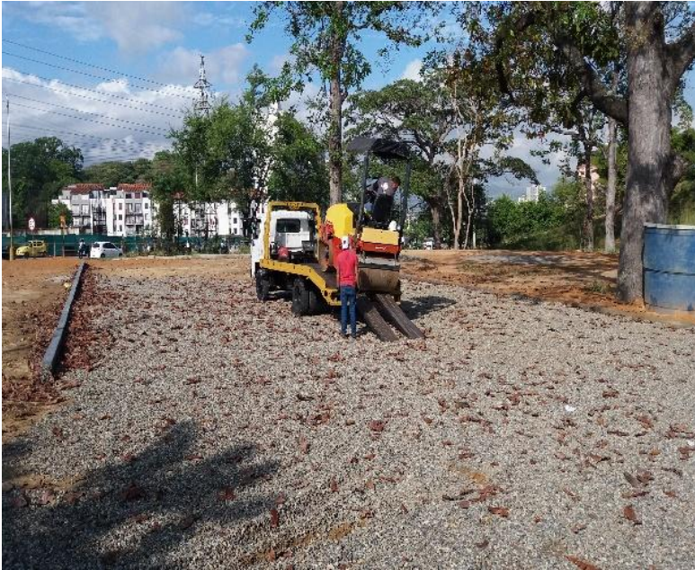
Imagen 10. Adecuación con Triturado Sala de Ventas Belfort.
