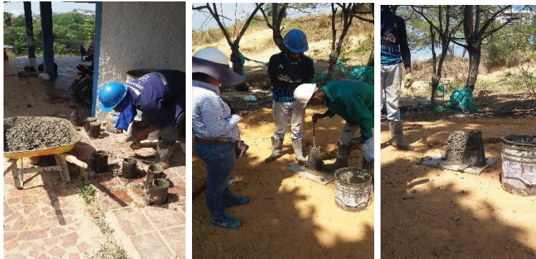
Imagen 23. Actividad Pruebas Realizadas al Concreto para Fundida Placa Cancha Sintética.
