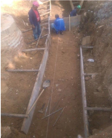
Imagen 28. Actividad Armado de Formaleta para Ciclópeo.
