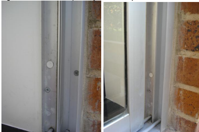
Figura 115 Sensores de apertura y cierre montaje final
