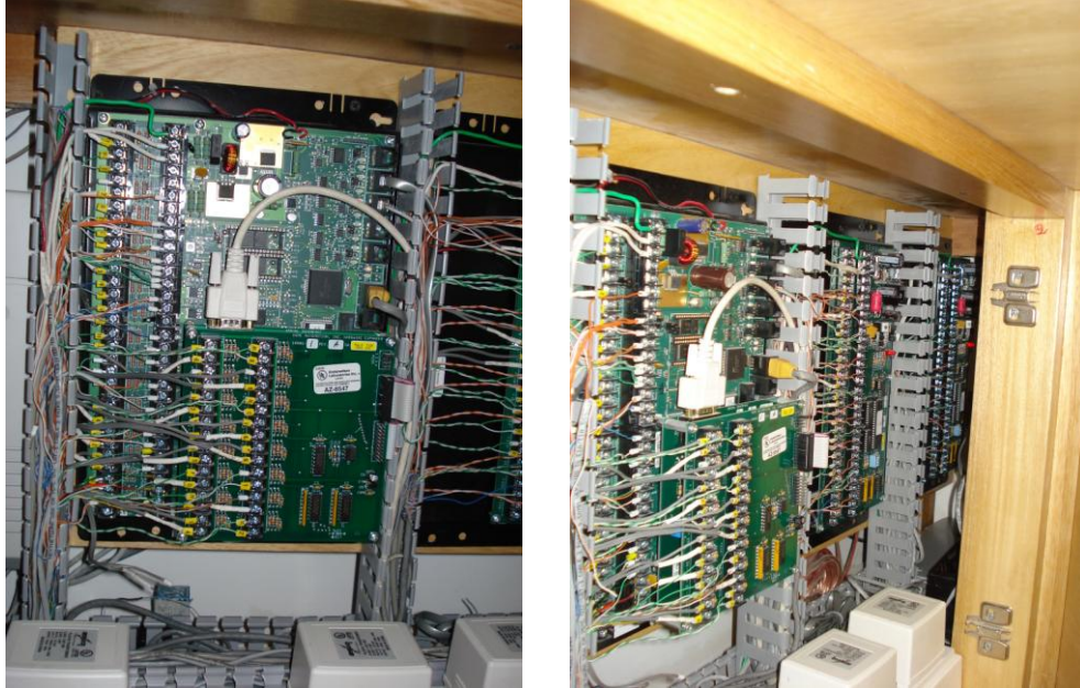
Figura 121 Conexión al controlador (montaje final)
