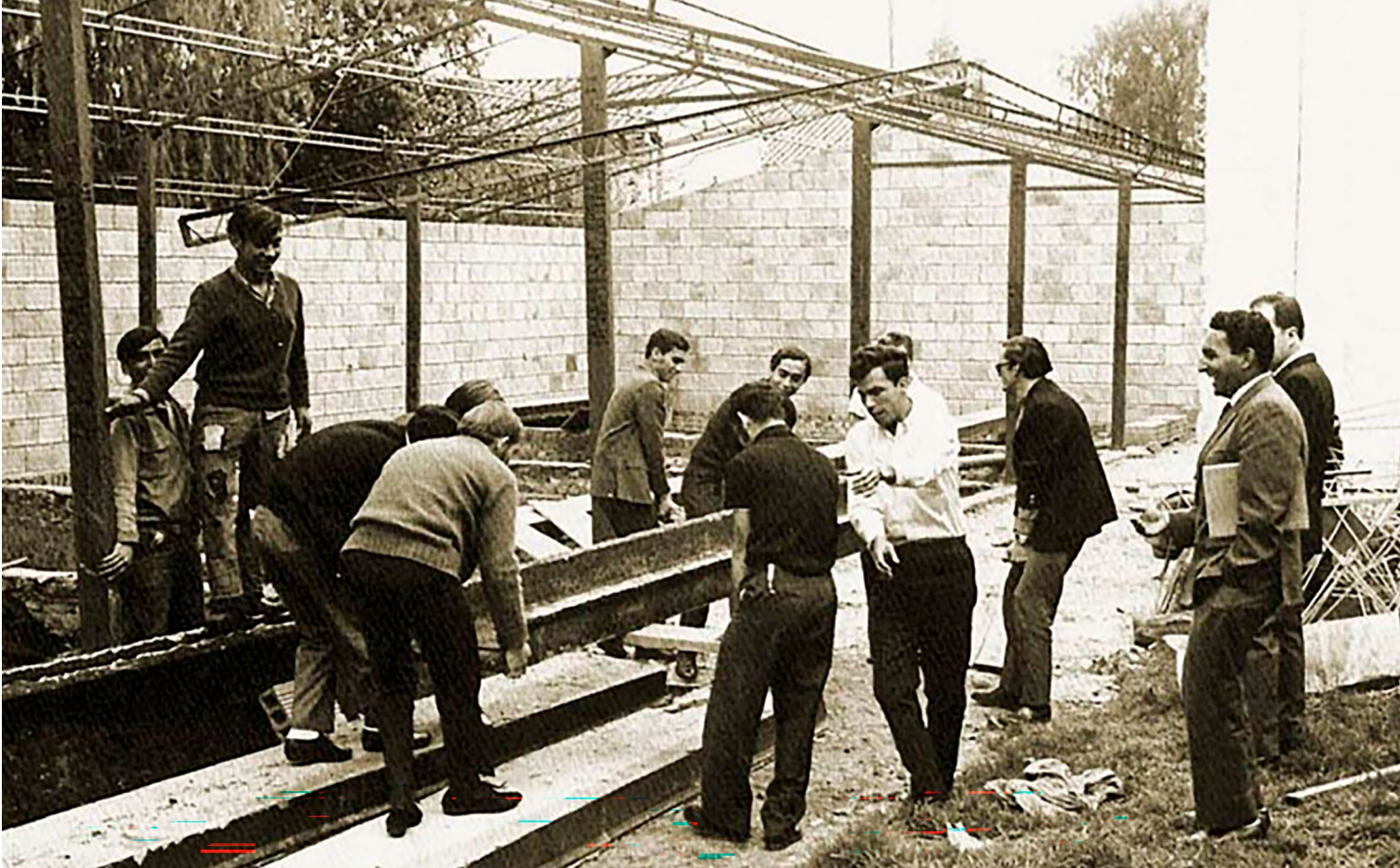
● Figura 31. Desconocido, primeras obras en la construcción de la UniPiloto en Bogotá, de la mano de los estudiantes, años 60. Archivo Universidad Piloto.
