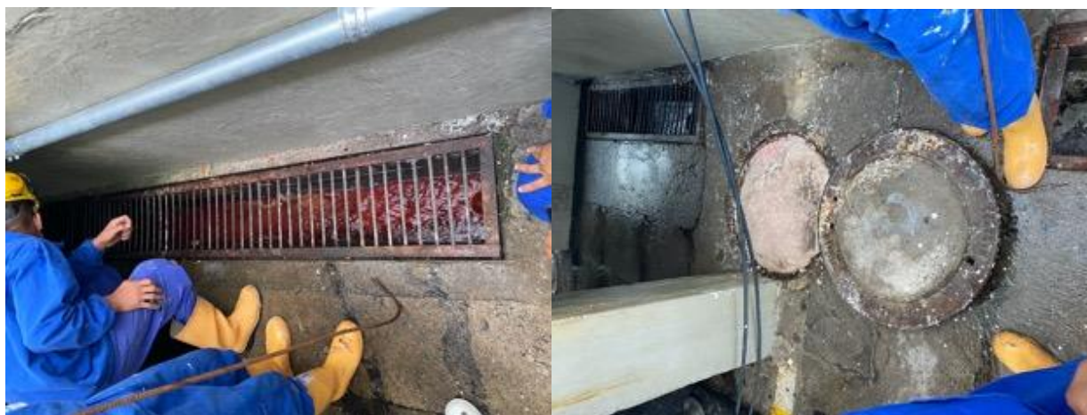
Ilustración 10: Taponamiento de pozo de inspección tubería de agua residual. Fuente: Autor.
