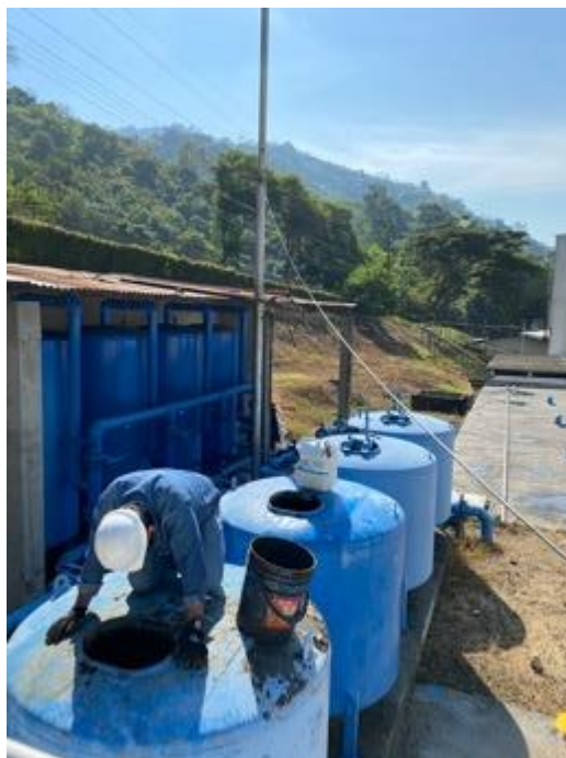
Ilustración 15: Cambio de lechos filtrantes. Fuente: Autor.
