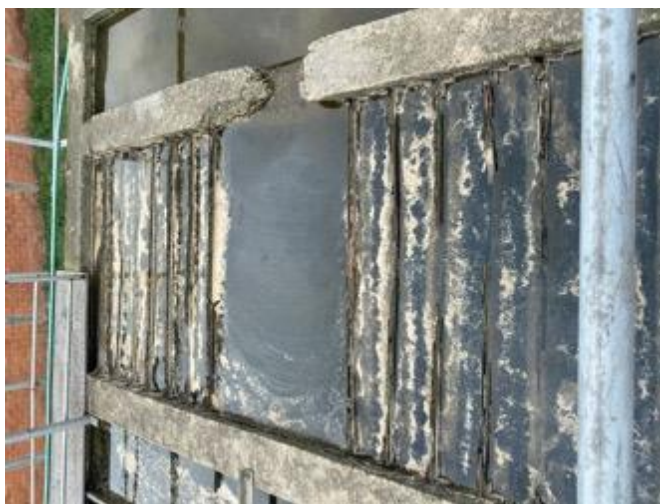
Ilustración 8: Módulos de floculación. Fuente: Autor.
