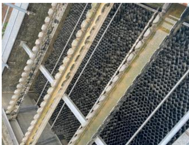
Ilustración 8: Módulos de floculación. Fuente: Autor.
