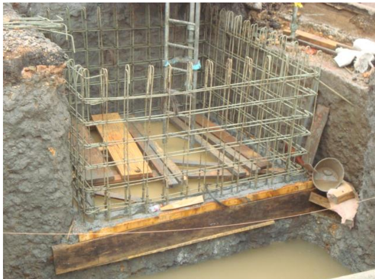
Imagen 5. Aplicación solado, instalación acero de piso, foso y arranque de muros, fundida de acero de piso, foso y arranque de muros, modificación andamios y armado de acero paredes laterales
