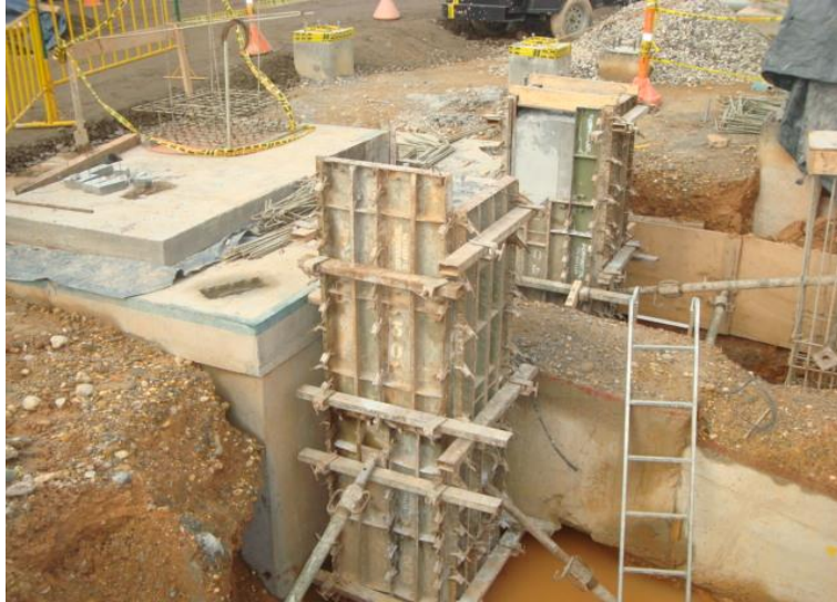
Imagen 18. Formaleteado pedestal, topografía e instalación de pernos y fundida del pedestal
