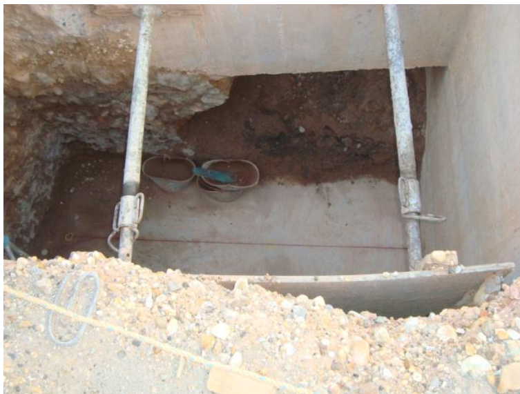
Imagen 15. Recubrimiento mortero paredes y solado
