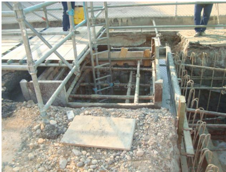
Imagen 7. Fundida de muros manholes
