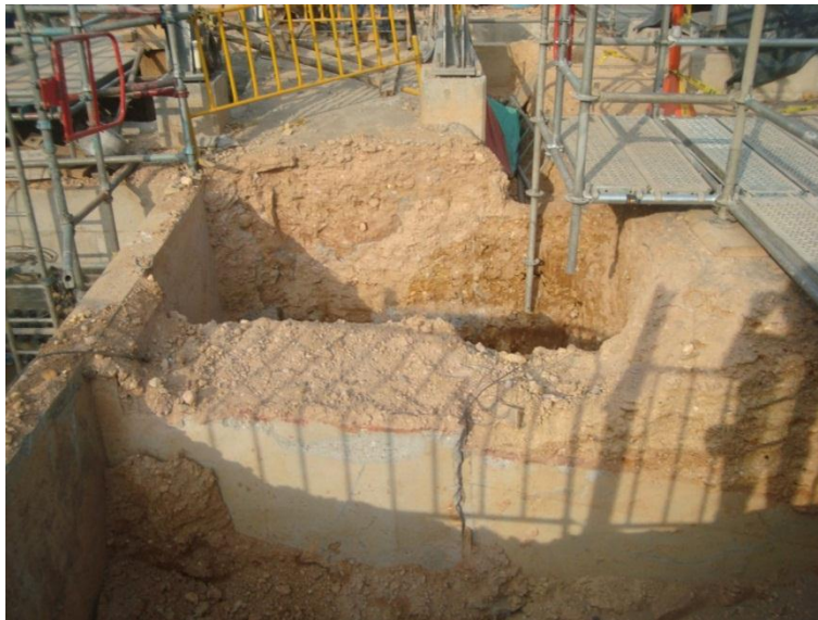
Imagen 15. Recubrimiento mortero paredes y solado
