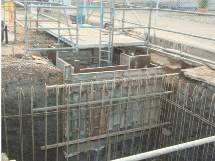
Imagen 7. Fundida de muros manholes
