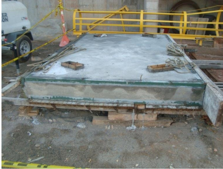
Imagen 12. Desencofrado de la tapa
