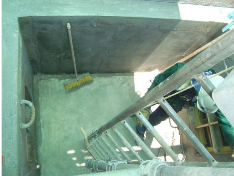
Imagen 8. Desencofrado de muros manhole:
