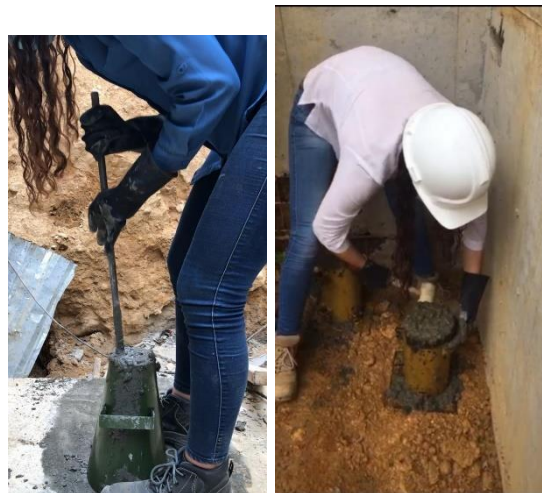
Ilustración 17. Realización de ensayo de asentamiento y toma de muestras de concreto.
