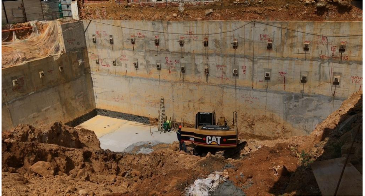
Ilustración 12. Palace Condominio, estado actual de obra, lado iglesia.
