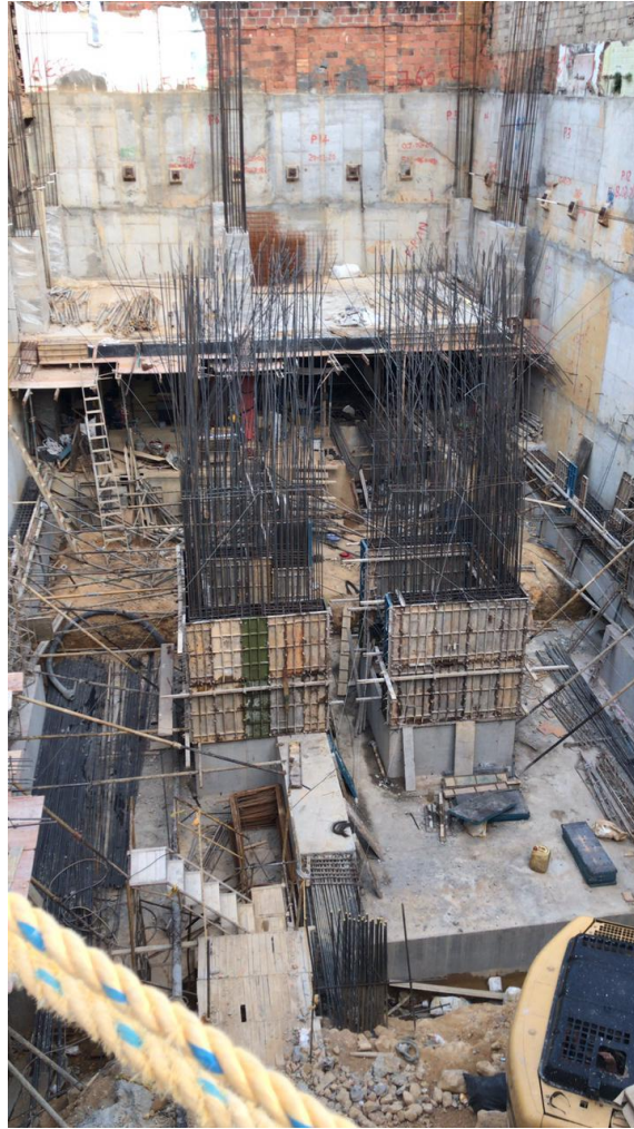
Ilustración 14. ARMADO DE HIERRO DE MUROS DE ASCENSOR.
