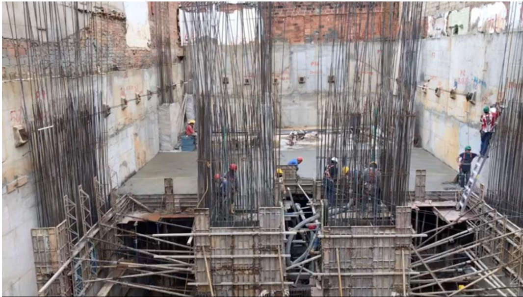
Ilustración 16. FUNDIDA DE PLACA, COLUMNAS Y MUROS DE ASCENSOR.
