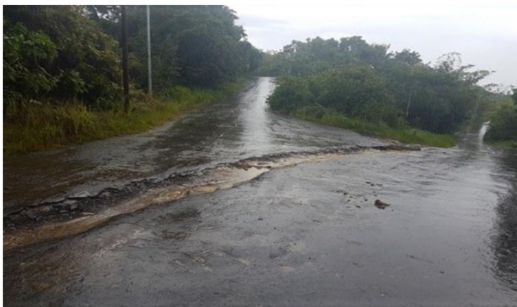
Imagen 6 Inspección previa de zona a intervenir, Lisama 18
