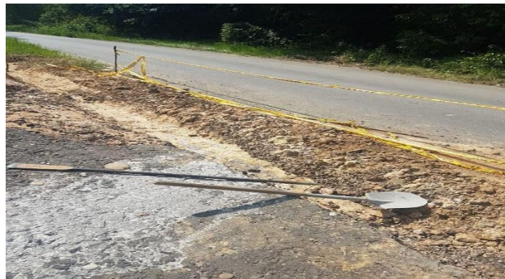
Imagen 9 Excavación manual para la construcción de cunetas
