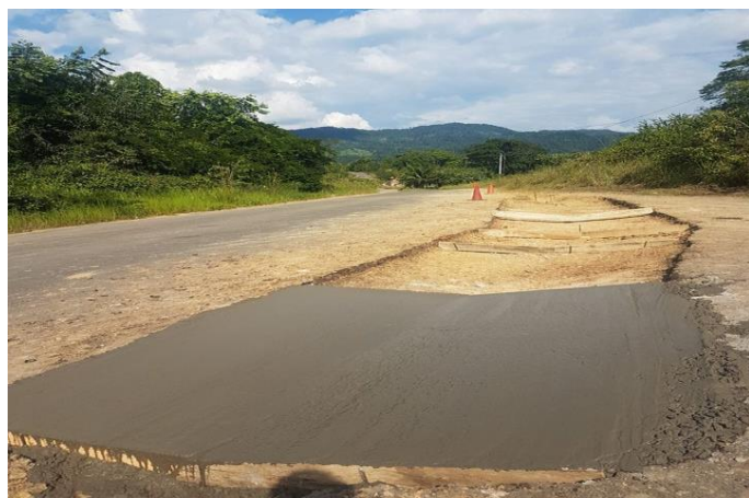
Imagen 12 Construcción en concreto de placa batea
