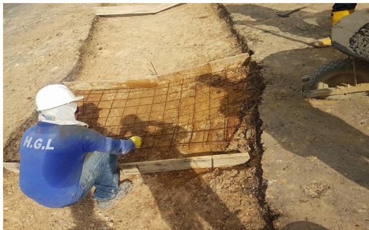
Imagen 10 Instalación de acero de refuerzo en placa batea
