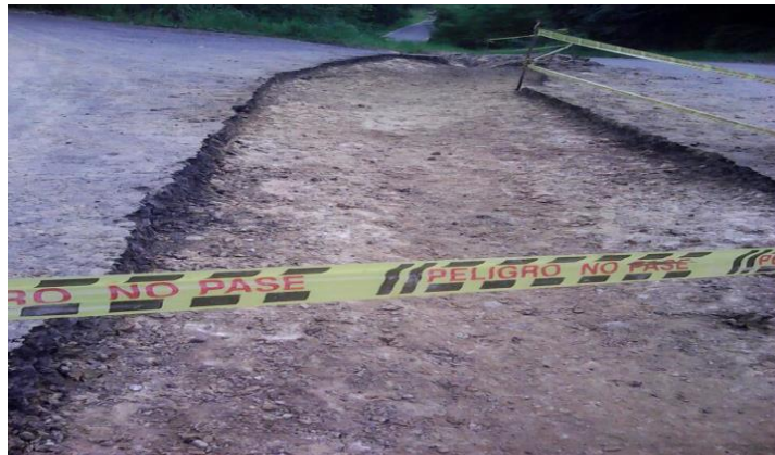
Imagen 8 Excavación manual para la construcción de placa batea
