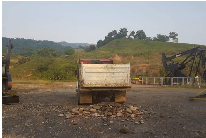
Imagen 22 Descargue de crudo de río en zona de trabajo
