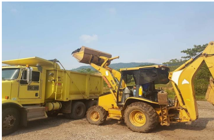
Imagen 23 Retiro de subbase granular
