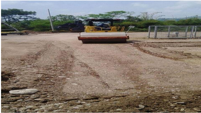
Imagen 26 Subbase granular compactada a máquina
