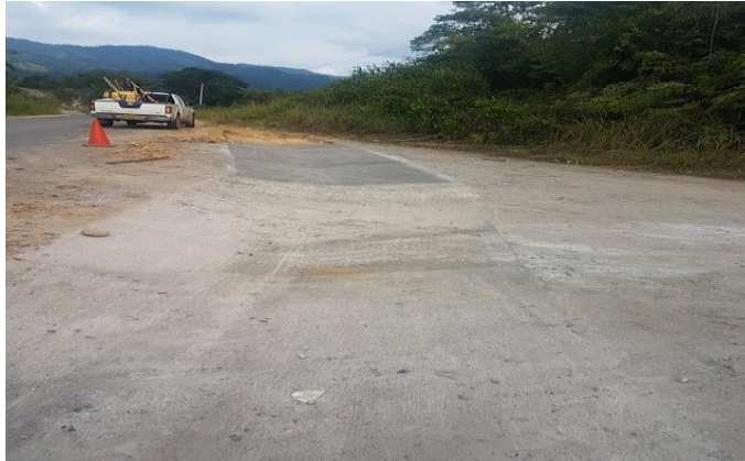
Imagen 13 Construcción en concreto de placa batea finalizado
