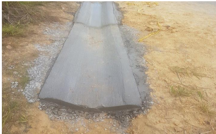
Imagen 14 Construcción en concreto de cuneta
