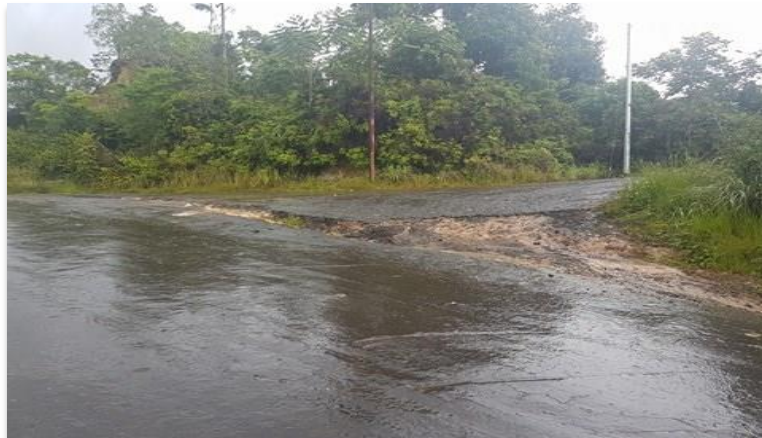
Imagen 5 Inspección previa de zona a intervenir, Lisama 18
