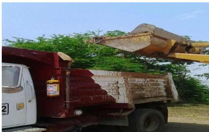
Imagen 21 Acarreo de material sobrante de excavación
