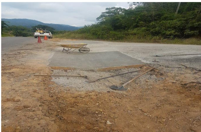
Imagen 11 Construcción en concreto de placa batea
