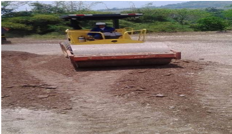
Imagen 27 Subbase granular compactada a máquina
