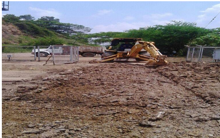
Imagen 20 Excavación a máquina en zona de fallo
