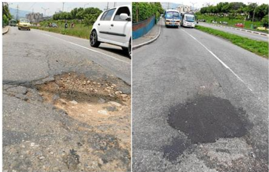
Figura 34: Arreglos en el pavimento
