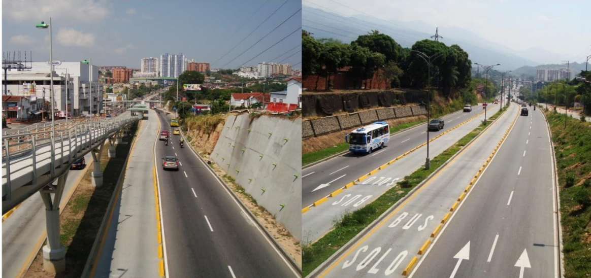
Figura 30: Estado del pavimento
