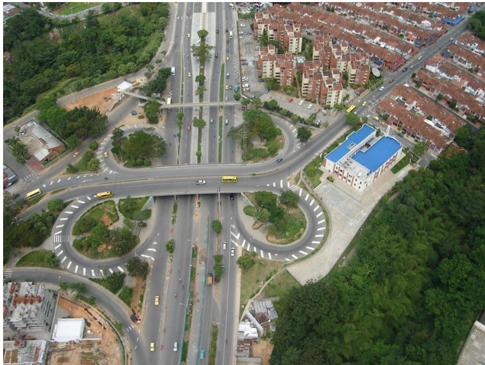
Figura 26: Vista aérea del Puente de Provenza
