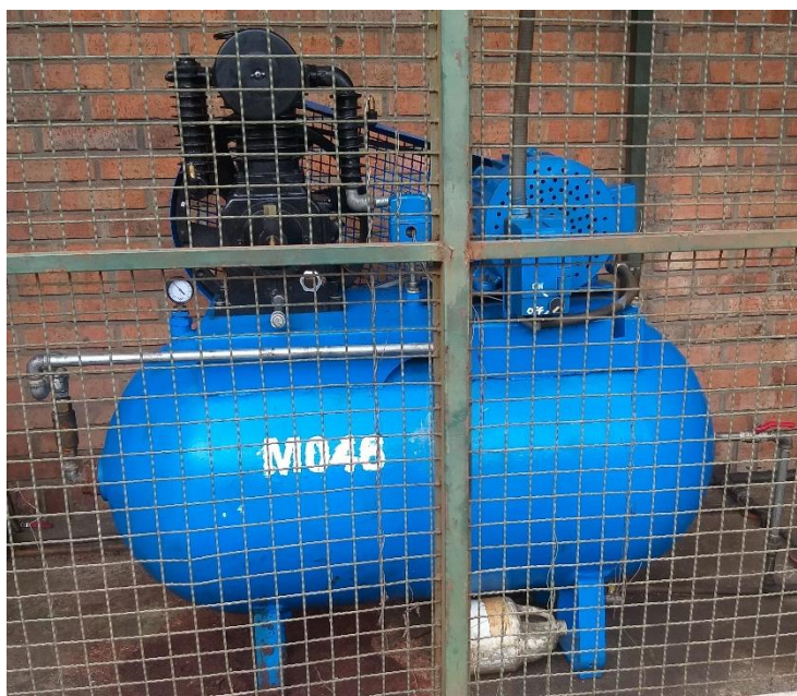
Figura 27. Compresor M046 con su respectivo código.
