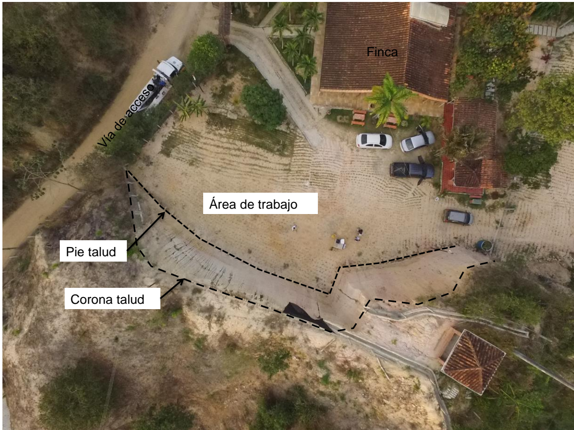
Figura 18 – Vista aérea del área de trabajo
