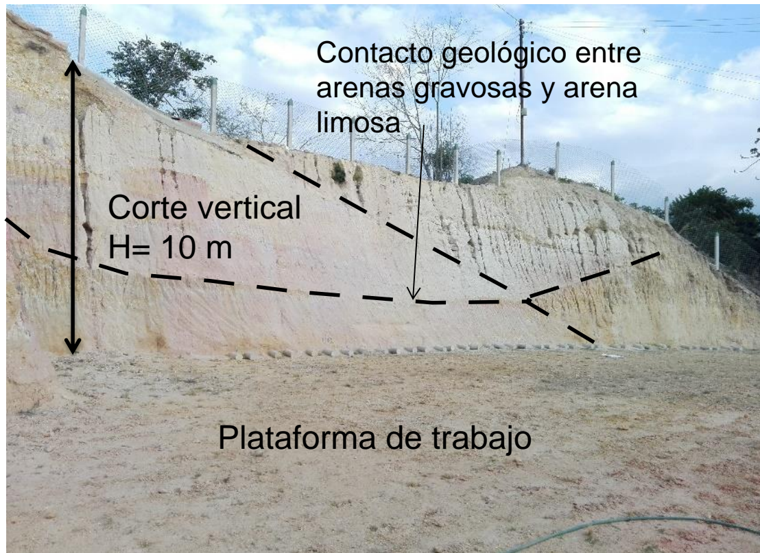
Figura 17 – Vista del talud en corte y plataforma de trabajo
