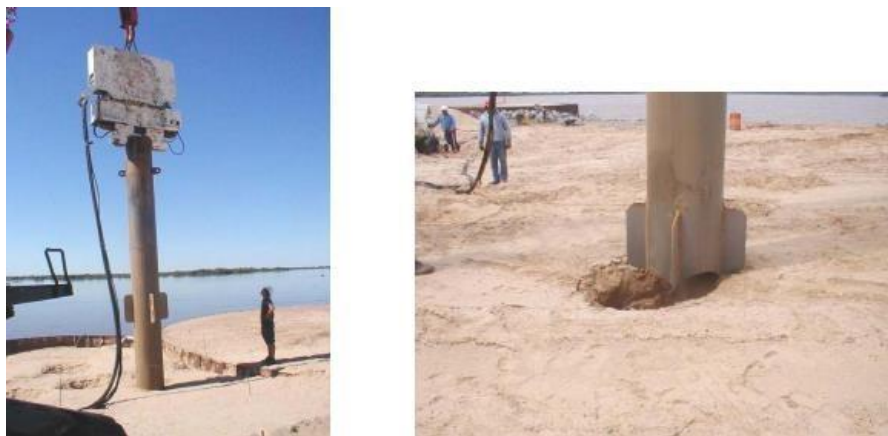
Figura 2 - Equipos de vibrocompactación. Fuente: Geotecnia y Cimentaciones [6]
