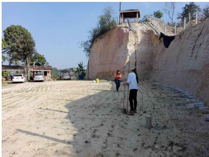
Figura 25 – Ensayos de PDC, condiciones pre-compactación
