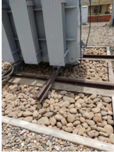
Figura 32. Instalación de bolo SE Cocos
