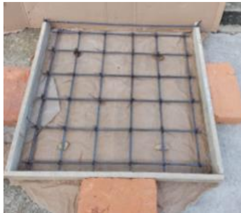
Figura 36. Construcción tapa de caja en concreto SE Conuco
