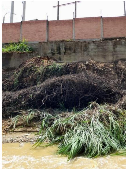
Figura 38. Gaviones adyacentes a muro de contención
