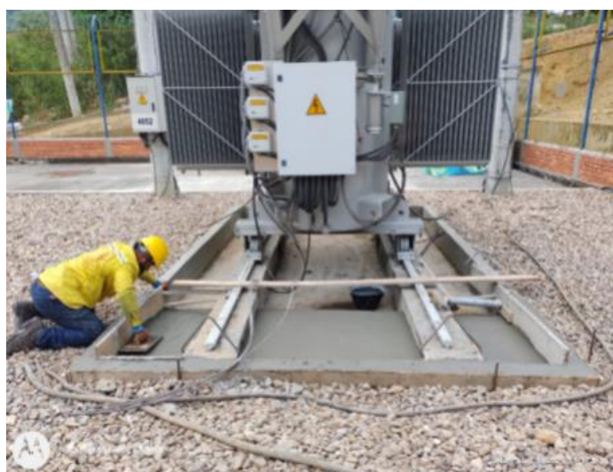
Figura 31. Ampliación de foso para transformador SE Hamacas
