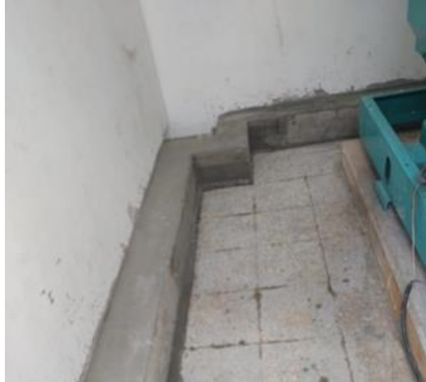
Figura 35. Construcción dique de contención transformador auxiliar SE Florida
