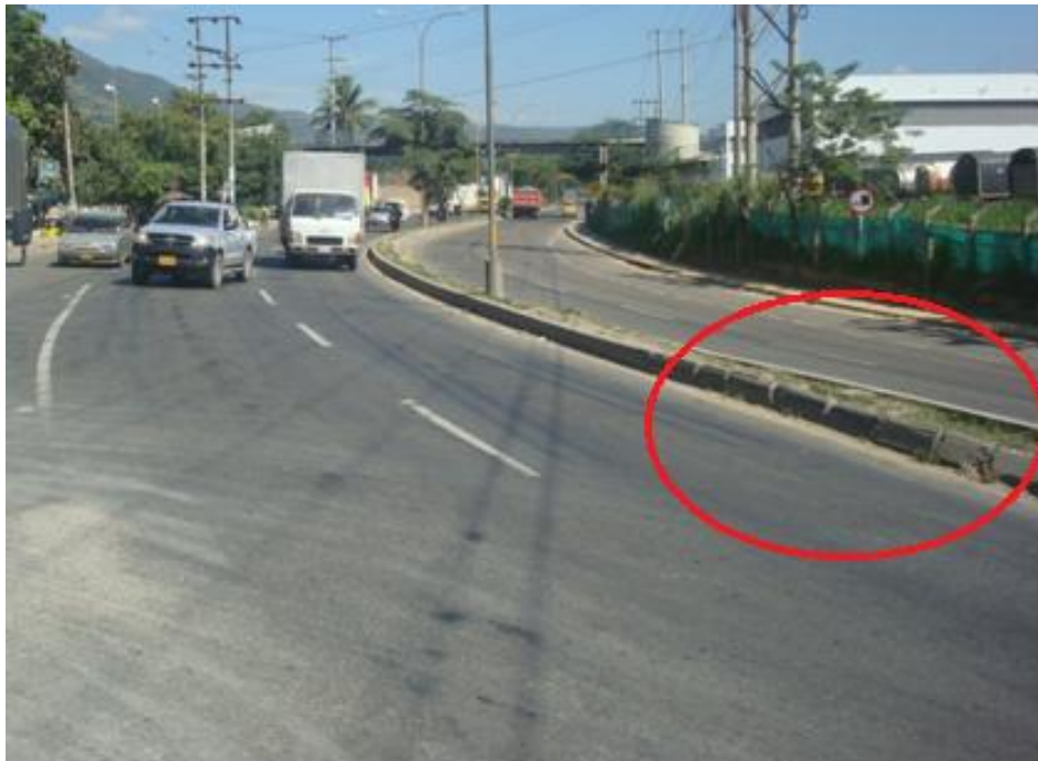
Figura 56. Sentido Café Madrid-Palenque Km 10+800, separador en mal estado
