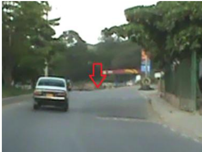
Figura 20. Sentido Palenque-Café Madrid Km 11+100, coincide curva horizontal y curva vertical
