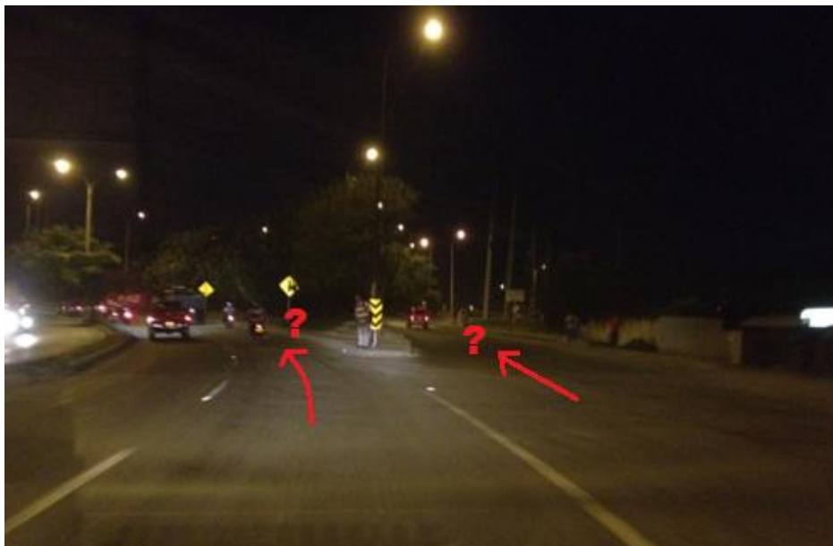
Figura 64. Sentido Café Madrid-Palenque Km 10+200, señalización informativa
