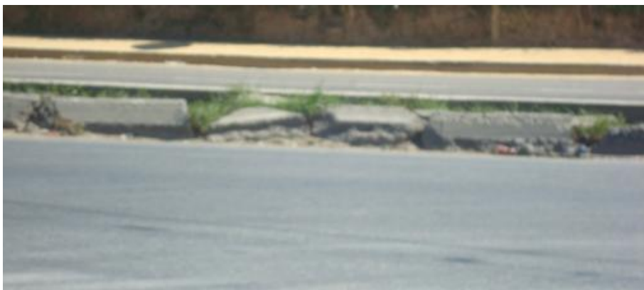
Figura 56. Sentido Café Madrid-Palenque Km 10+800, separador en mal estado
