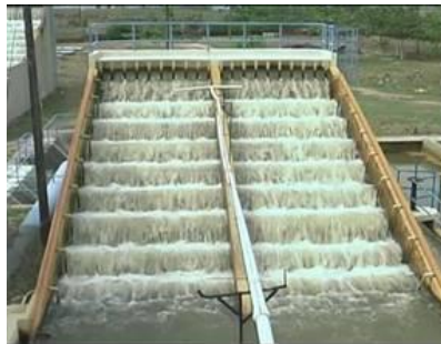
Figura 20. Sistema de aireación mediante saltos.
