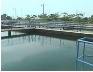
Figura 23. Piscinas de sedimentación.
