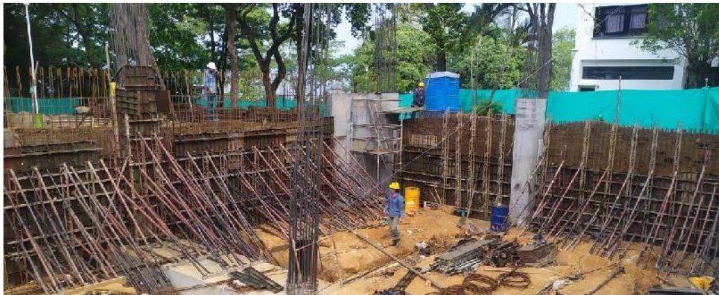
Figura 32. Instalación de Formaleta para Muros de Contención Fuente: Autor
