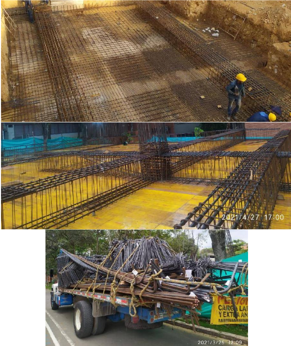
Figura 26. Acero de Refuerzo para Cimentación y Planta Libre Fuente: Autor
