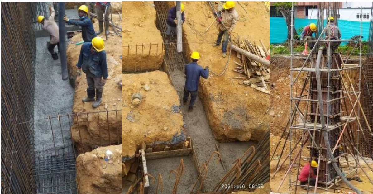
Figura 27. Vaciado de Concreto para Cimentación y Columnas Fuente: Autor
