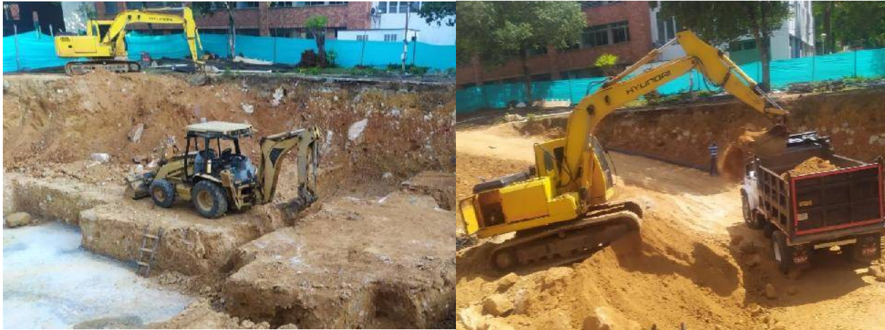
Figura 25. Excavación con Máquina para la Cimentación Fuente: Autor
