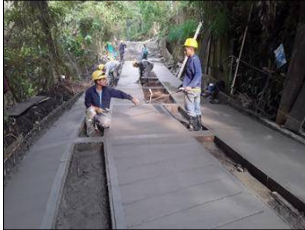
Figura 5. Construcción Placa Huella en Landázuri - Santander Fuente: Ingeniero Luis López
