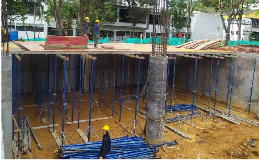
Figura 34. Instalación de STEN para Planta Libre Fuente: Autor
