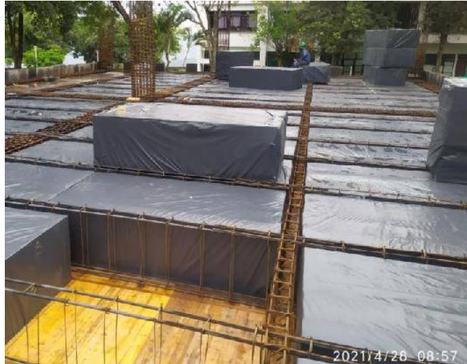
Figura 28. Instalación de Casetones para la Planta Libre Fuente: Autor
