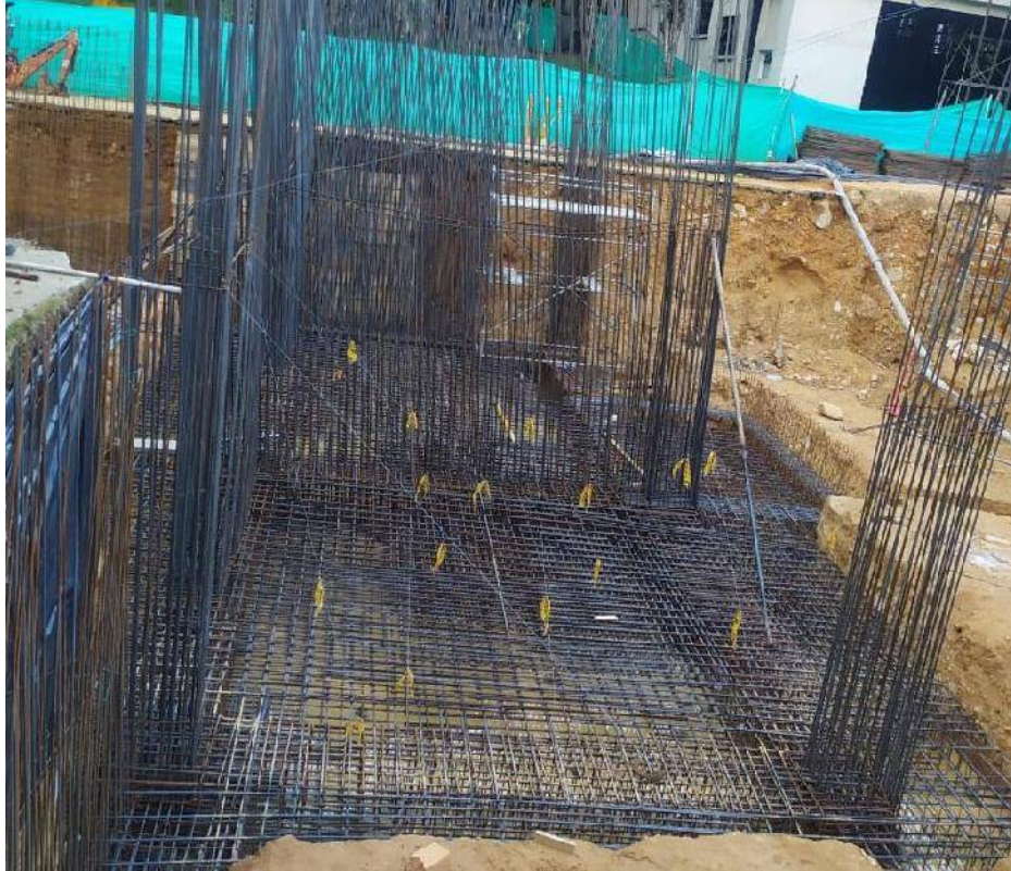
Figura 36. Instalación de Acero en la Cimentación
