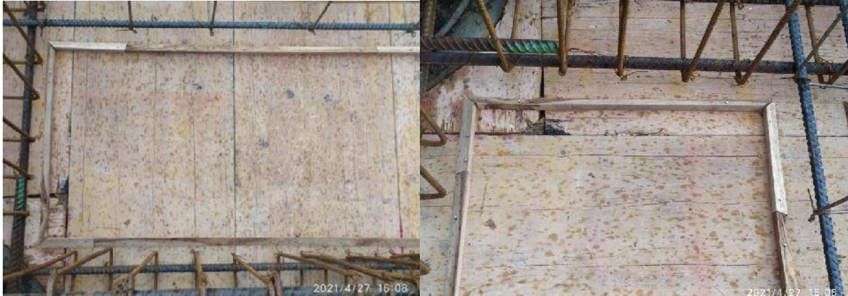
Figura 29. Instalación de Biseles para la Planta Libre Fuente: Autor
