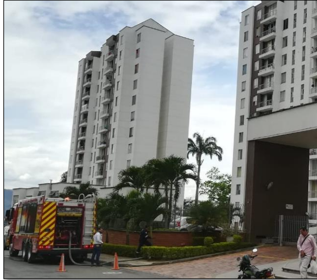
Figura 8. Conexión de Bomberos Fuente. Autor
