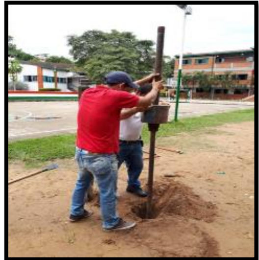
Imagen 15: Ejecución de sondeo.
