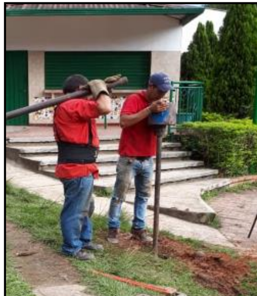
Imagen 19: Ejecución de sondeo
