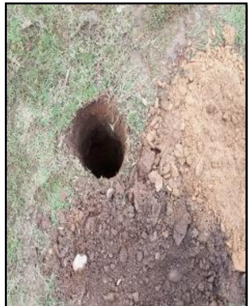
Imagen 17: Ejecución de sondeo.
