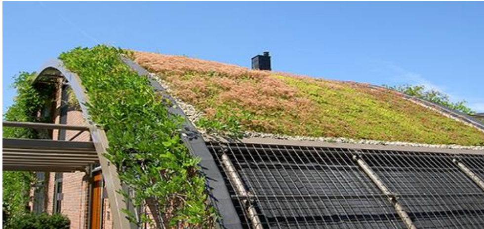
Figura 2. Cubierta verde extensiva Tomada de Cubiertas Verdes Extensivas [Fotografía], ZinCo, https://zinco-cubiertas-ecologicas.es
