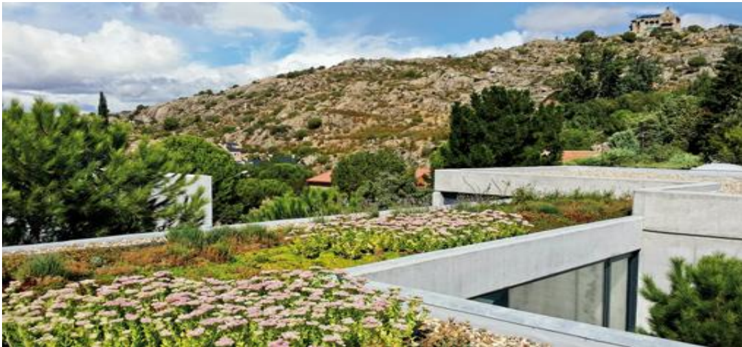
Figura 4. Sistema combinado intensiva-extensiva. Tomada de Cubierta Semi-intensiva [Fotografía], ZinCo, https://zincocubiertas-ecologicas.es
