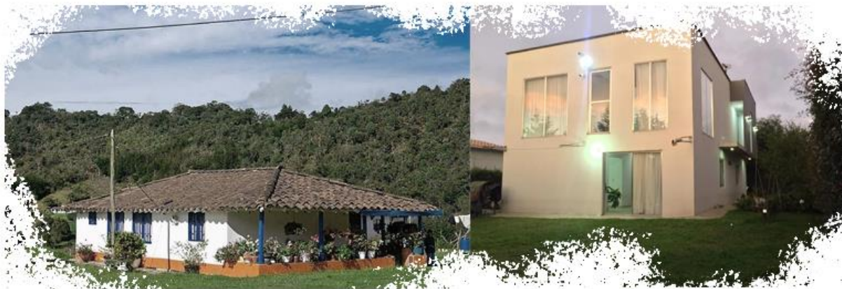
Ilustración 22 Fractura arquitectónica en Santa Elena Antioquia
