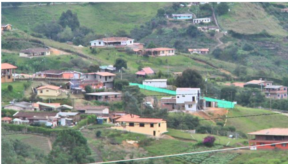
Ilustración 16 Loaiza, Santiago. 2021. construcciones ilegales en Santa Elena
